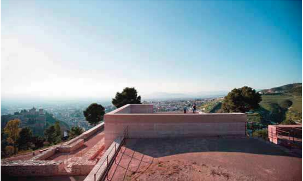
Figura 12. Torre mirador desde la plataforma trasera. Fotografía: Javier Callejas Sevilla
