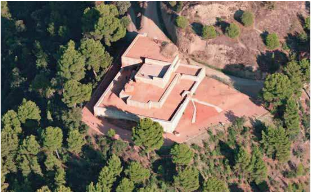
Figura 13. Vista aérea tras la intervención. Fotografía: Javier Callejas Sevilla
