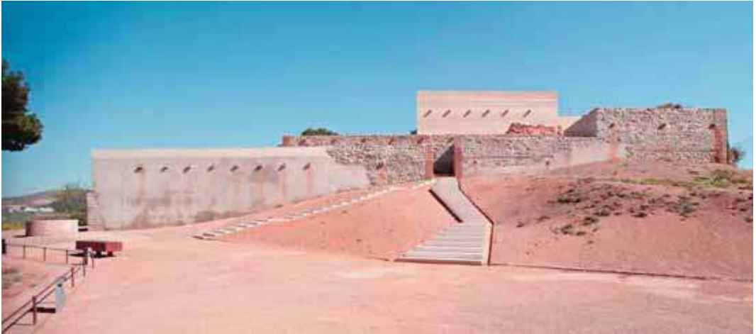
Figura 9. Frente de acceso a la Silla del Moro desde la carretera. Fotografía: Javier Callejas Sevilla
