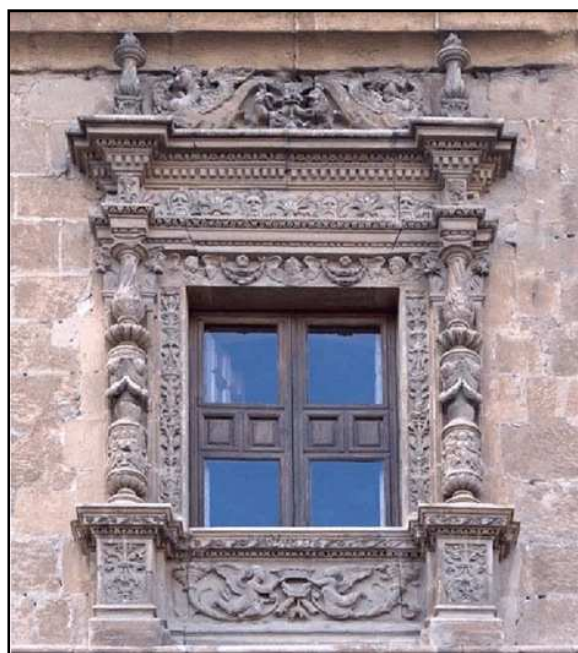
Imágenes 7 y 8 Ventanas del Hospital Real
