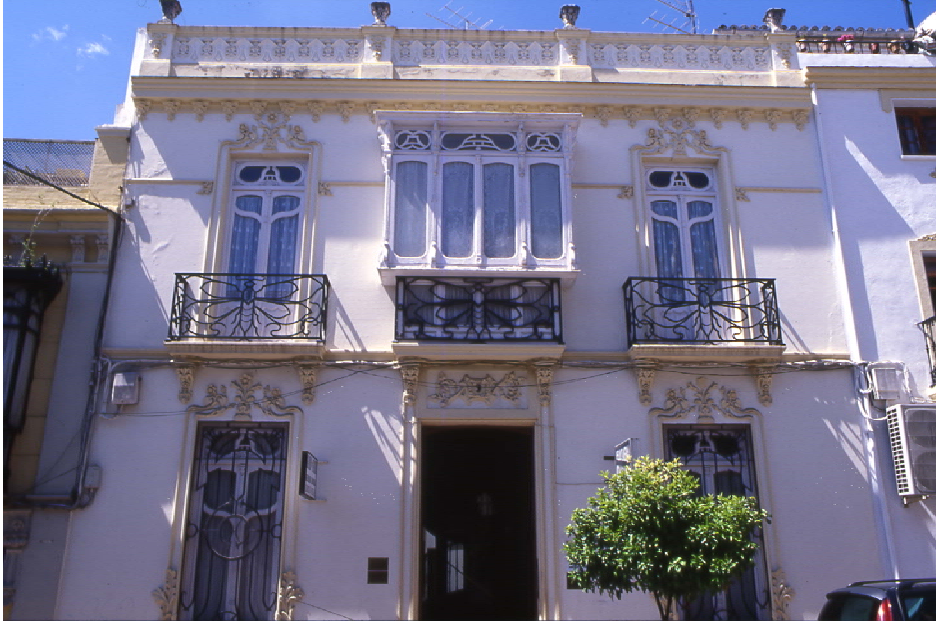
Lám. 41. Casa en Calle Sevilla nº 9. Sanguinetti. Año 1910. Ronda.
