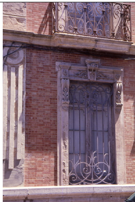
Lám. 19. Detalle hueco ventana y cerramiento de esquinas. Calle de los Remedios nº 19. Ronda.
