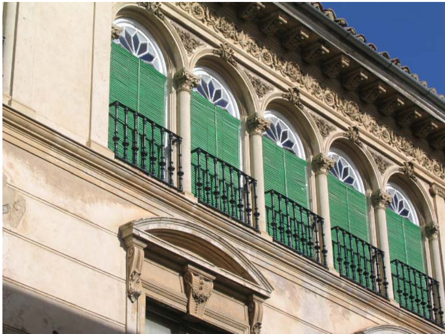
Lám. 14. Ventanas en arquería. Calle Maria Cabrera nº 17. Ronda.
