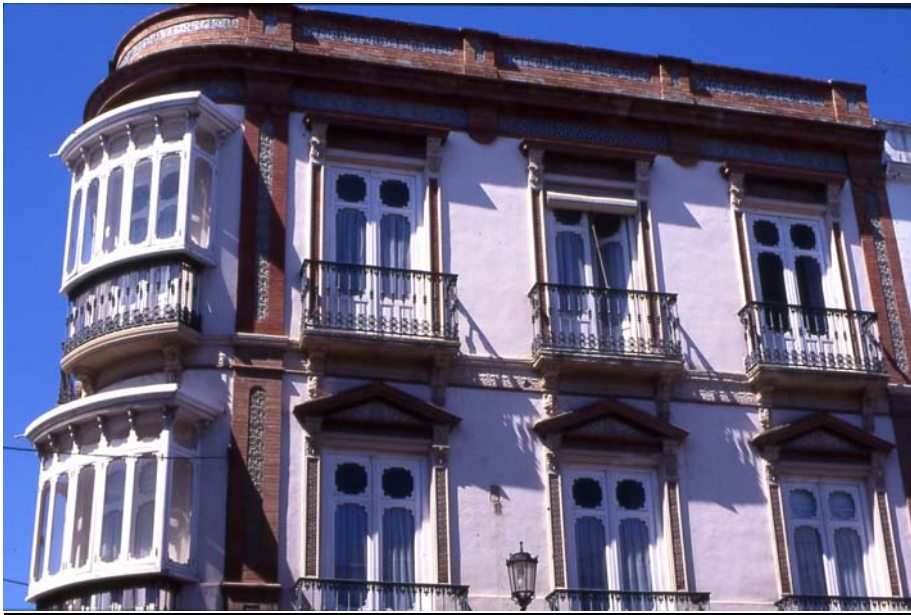
Lám. 47. Vivienda en Calle Las Tiendas esquina con Plaza de Carmen Abela. José Gutiérrez. Año 1905. Ronda.
