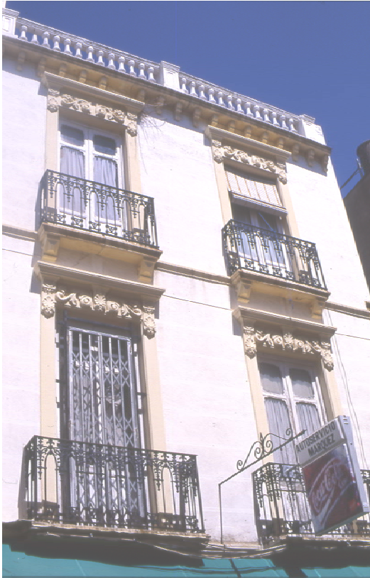
Lám. 34. Vivienda en calle Espinel 21. Ronda.
