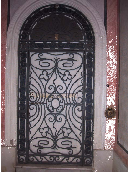
Lám. 60. Cancela modernista de la vivienda nº 19 de la calle Virgen de los Dolores. Ronda.
