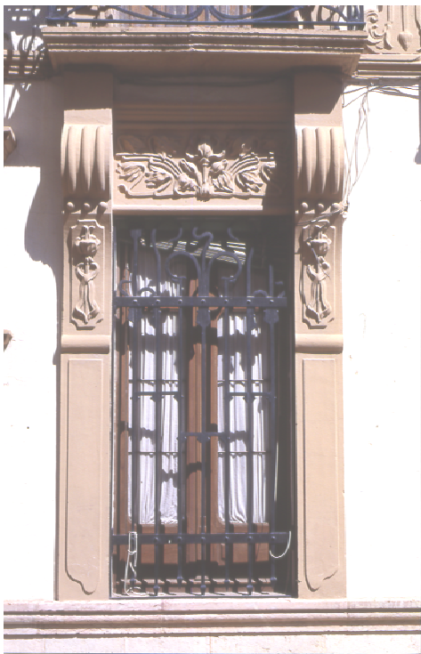
Lám. 22. Detalle Ventana piso inferior. Calle Tenorio nº 2. Ronda.
