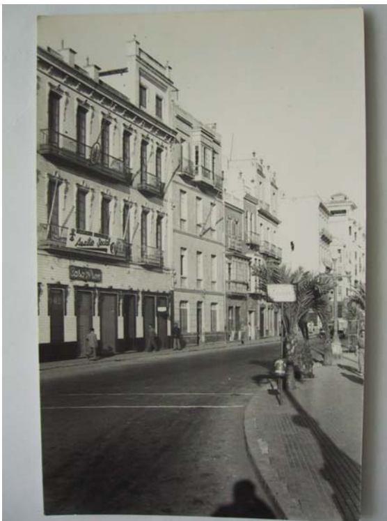
Lám. 79. Hotel Hispano Marroquí y Clínica de Urgencias, después de la ampliación de Gaspar Blein en 1937. Sanguinetti. Ceuta.
