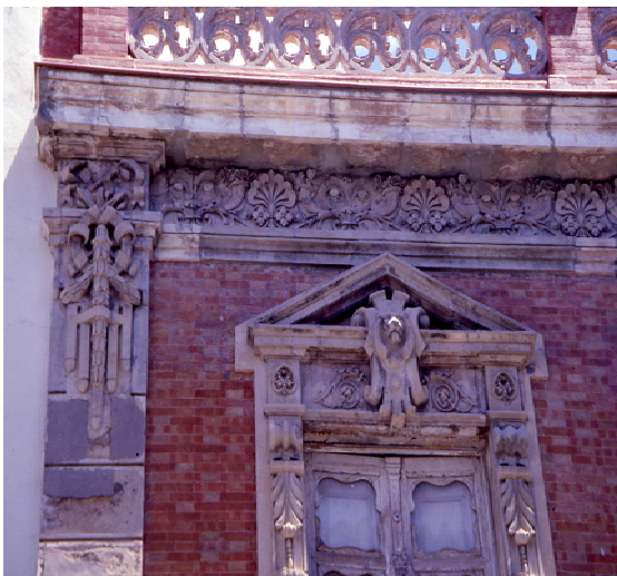
Lám. 18. Detalle balcón superior. Calle de los Remedios nº 19. Ronda.
