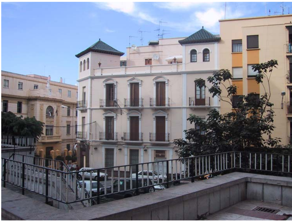
Lám 139. Edificio Luis de Mesa y León. Plaza de Ruiz. Sanguinetti. Junio 1927. Ceuta.
