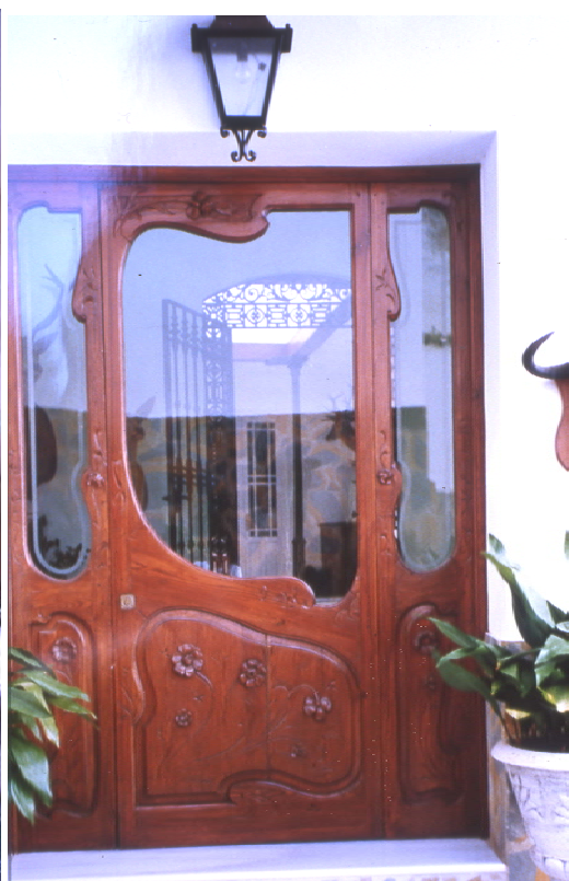
Lám. 58. Portal modernista en calle Armiñan nº 59. Ronda.
