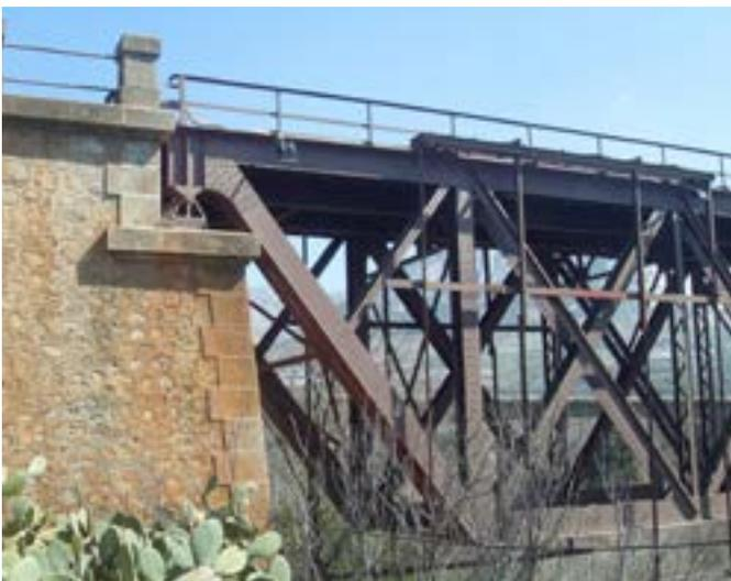
Detalle del extremo de las vigas y aparato de apoyo
