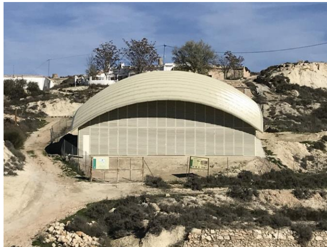
Fig 127. Cubierta estructural. Vista exterior, sistema de protección y musealización yacimiento de Fuente Nueva 3, Orce (Granada). Imagen: Eva Montilla Jiménez.
