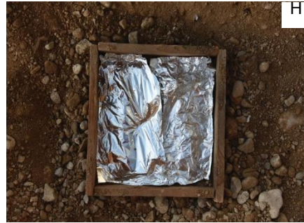
Fig. 92 Aplicación mediante film de aluminio y perímetro con tablas rígidas de madera.
