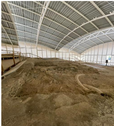
Fig 126. Cubierta estructural. Vista interior. Sistema de protección y musealización yacimiento de Fuente Nueva 3, Orce (Granada). Imagen: el autor.
