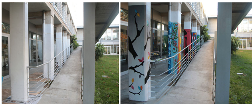
FIGURA 12. Resultados de algunas de las obras de co-creación de la segunda edición ¿Dónde está el color? en 2015. Se muestra el cambio estético y visual del antes y el después de la intervención.
