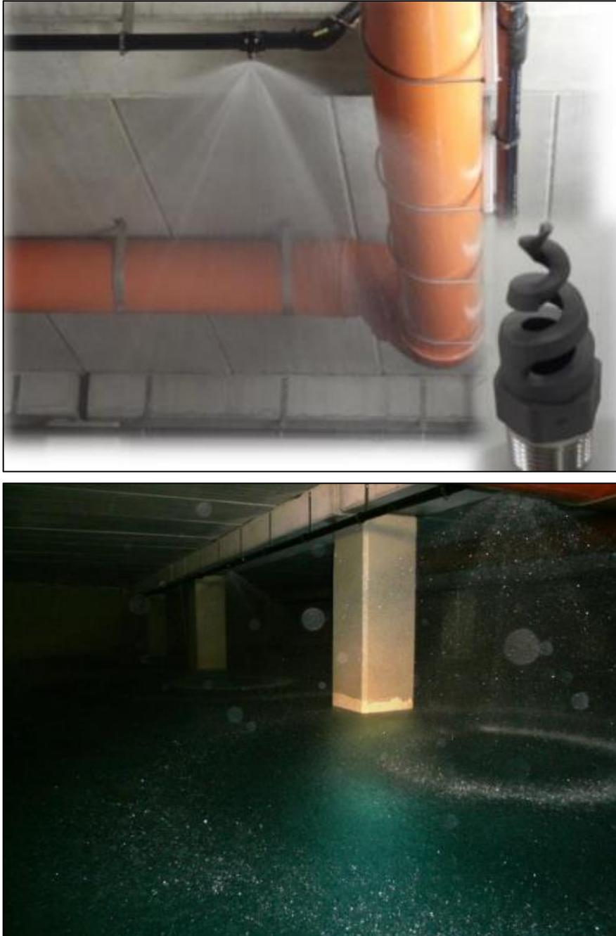
**Figura 18:** Rociador del sistema TRS y vista en el interior del depósito A
