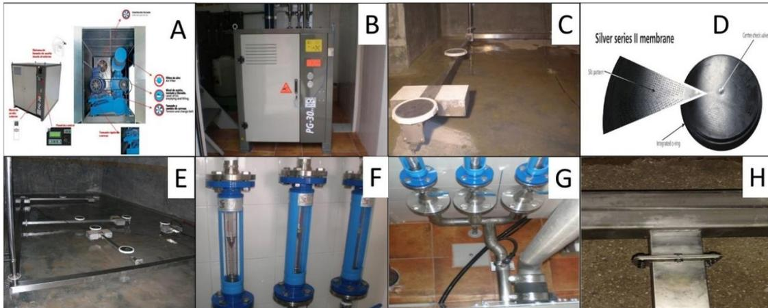
**Figura 27:** Elementos y equipos instalados en Depósito Cabezo de la Plata: A) Detalle del soplante. B) Soplante. C) Detalle de unos difusores instalados. D) Detalle de la membrana de los difusores. E) Conducciones sobre suelo de depósito de la cámara de entrada. F) Rotámetros. G) Colector y válvulas de cada conducción principal con una conducción secundaria.
