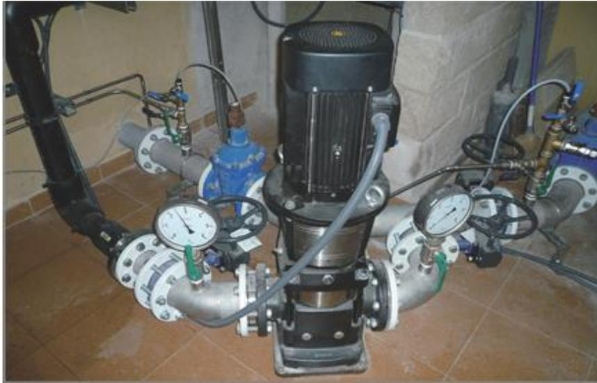
**Figura 19:** Bomba de recirculación depósito A
