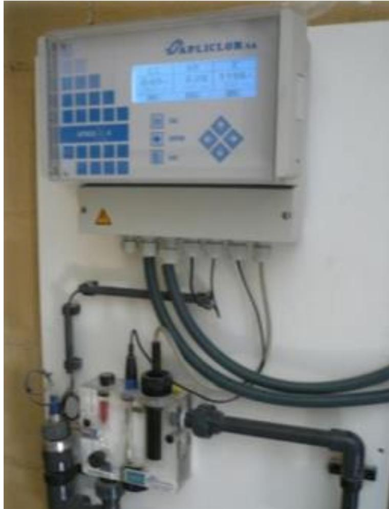
**Figura 24:** Analizador en continuo de Cl, pH, temperatura y conductividad
