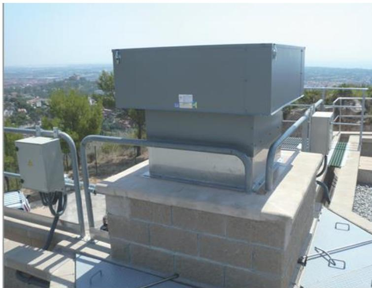
**Figura 20:** Aireador del sistema TRS
