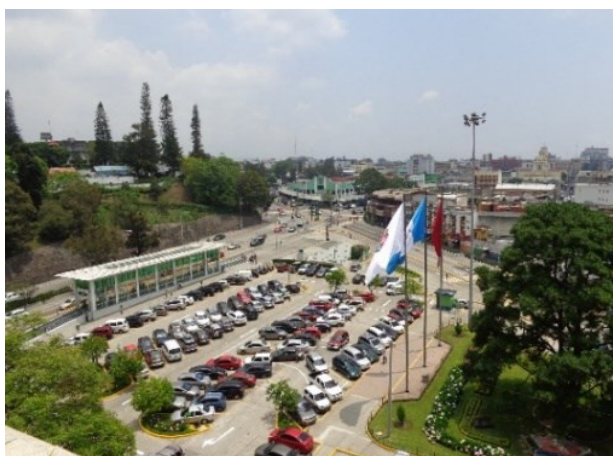
337. Vista del estacionamiento de la Municipalidad de Guatemala. Al lado izquierdo estación del Transmetro. Fuente: SEBC, 2018.
