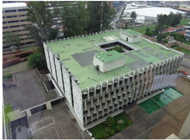
244. Vista del patio interior del Banco CHN. Fuente: SEBC, 2018.
