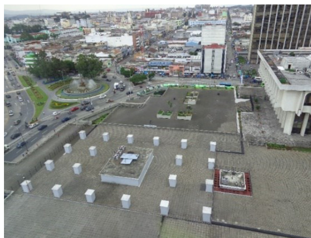
334. Techo de la Biblioteca Nacional cerrado al público. Se observan arranques de columnas para torre que no fue construida. Fuente: SEBC, 2018.
