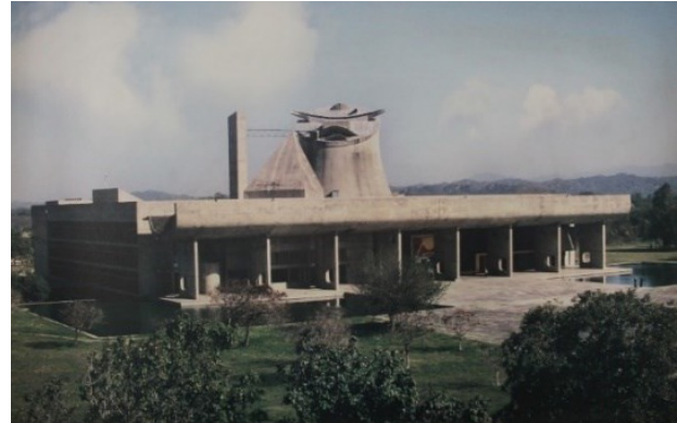
257. Palacio de la Asamblea de Chandigarh, fachada y cubierta, 2018. Fuente: Roberto Marcatti.
