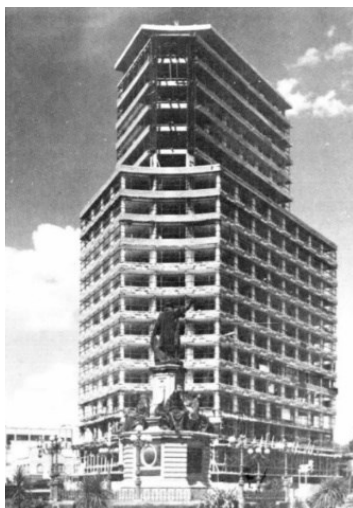
53. Proceso de colocación de platabandas de mosaico de metal esmaltado en el edificio de Recursos Hidráulicos. Fuente: Noelle, L. (1987).
