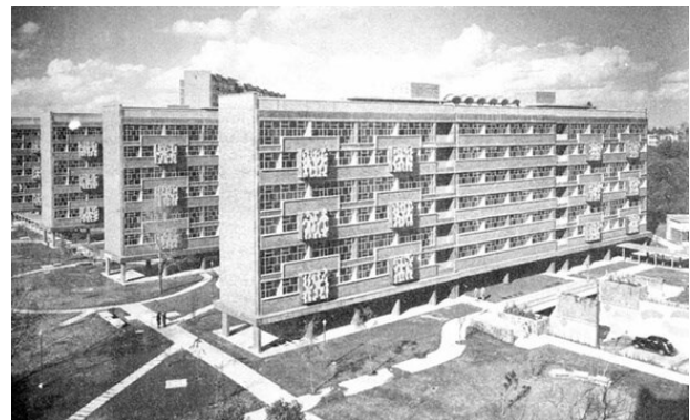
47. Vista General de los edificios del multifamiliar presidente Juárez con la obra de Carlos Mérida.
