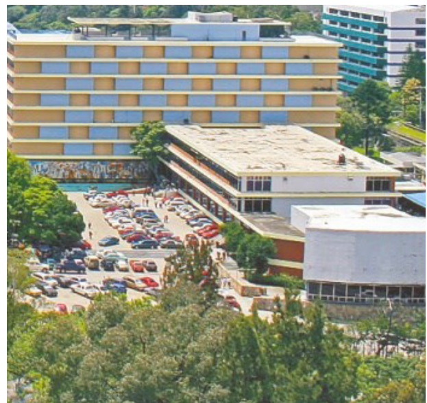
238. Vista poniente. En el fondo se aprecia el edificio de oficinas, seguido por el de atención al cliente y el auditorio en primer plano.
