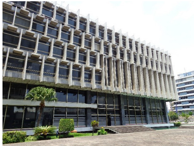
245. Vista de los parteluces de la fachada Norte del CHN. Fuente: SEBC, 2018.
