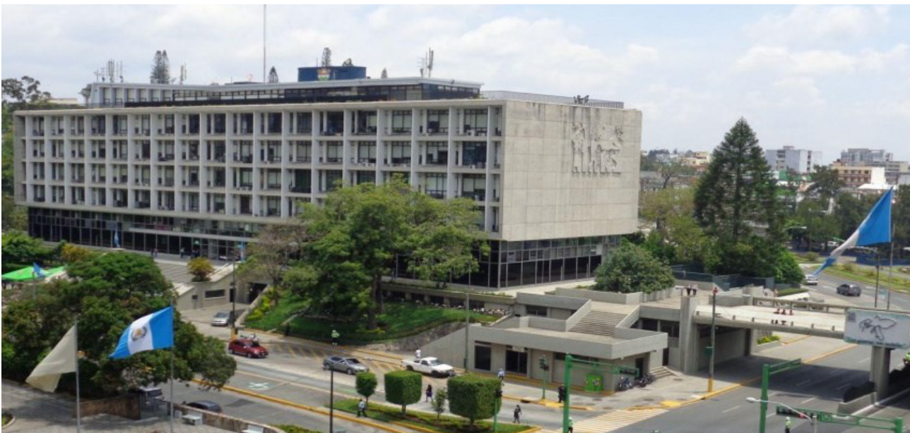
236. Vista de la fachada Sur del Palacio Municipal. Fuente: SEBC, 2018.
