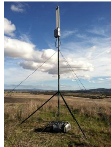
Diagrama 11. Ejemplo de instalación de una estación base en un entorno rural
