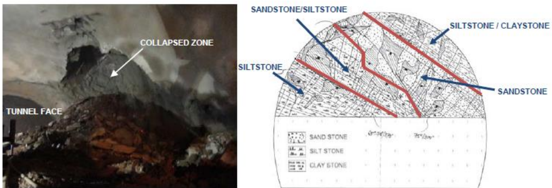
Figura 2: Vista e interpretación geológica del frente de excavación del túnel Chenari – Nashi en el momento del colapso. A la izquierda, fotografía del frente de excavación en el momento del colapso y a la derecha interpretación geológica de dicho frente (Palomba 2013)
