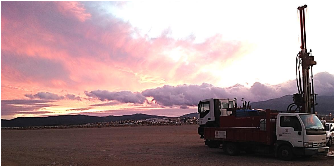
Figura 28: Equipo de sondeos RL-400 perteneciente a la empresa SERGEYCO trabajando en las instalaciones de la Autoridad Portuaria Bahía de Algeciras
