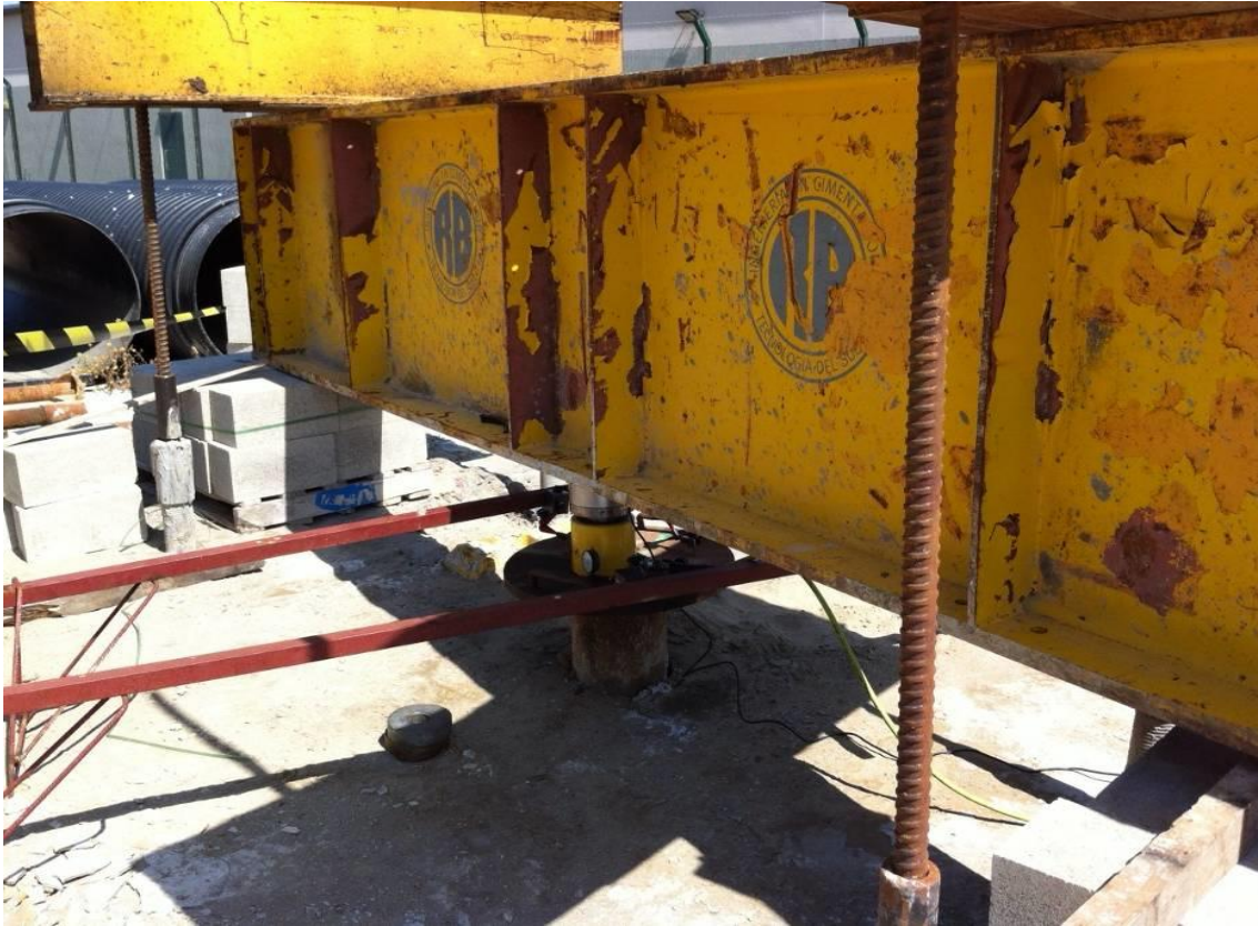
Figura 99: Vista del sistema de reacción colocado sobre los cuatro anclajes.
