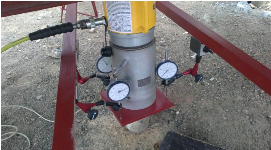
Figura 100: Vista del sistema de medida de los asientos en la cabeza del micropilote.
