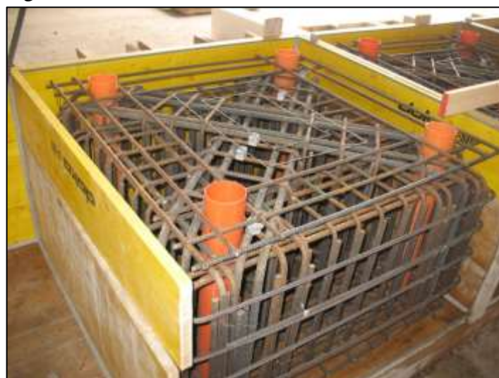
Figura 8: Posizionamento della gabbia nella cassaforma
