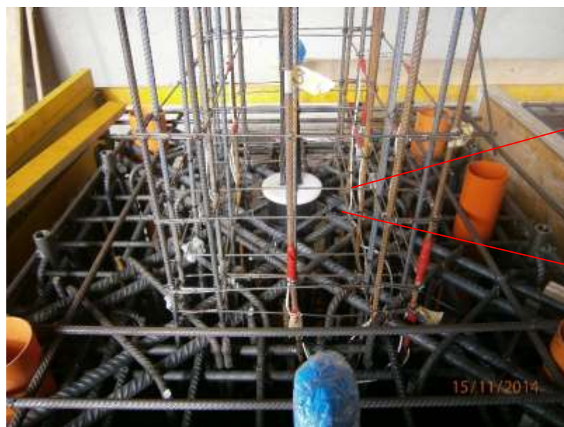
Figura 10: Dettaglio dell'anello in acciaio e del disco in nylon.
