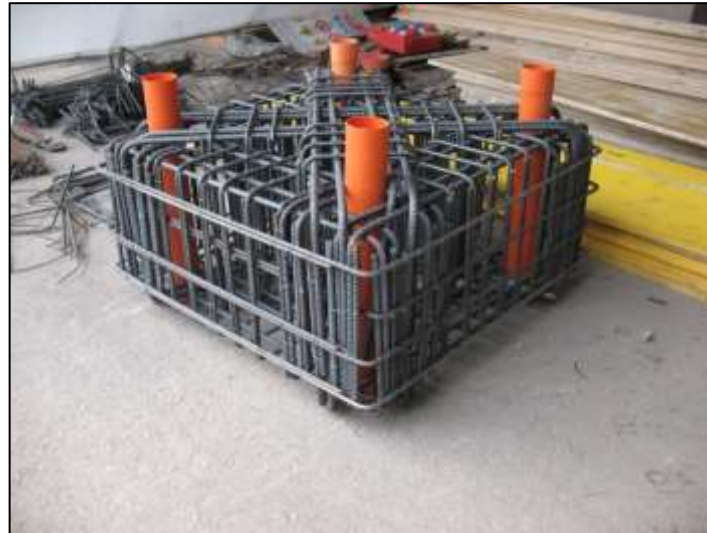
Figura 7: Gabbia di armatura del plinto di fondazione
