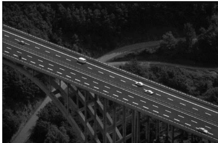
Figura 1: Ponte con arco in calcestruzzo dell'A1 (Roma-Firenze) [2]
