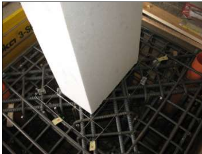
Figura 11 – Posizionamento del cilindro in polistirolo interno (cavità)
