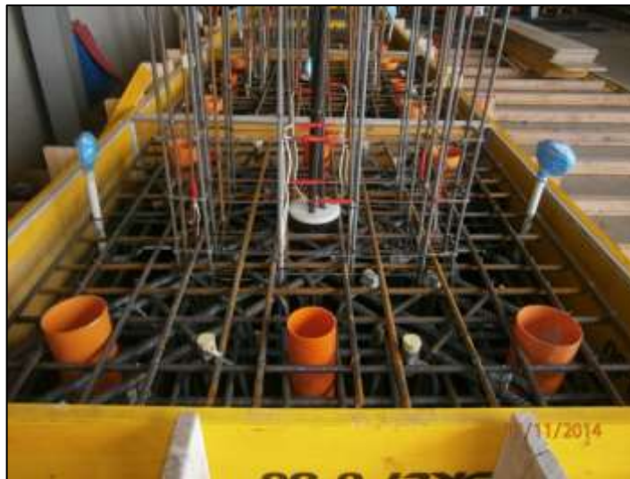
Figura 12: Installazione della strumentazione (strain-gauge)
