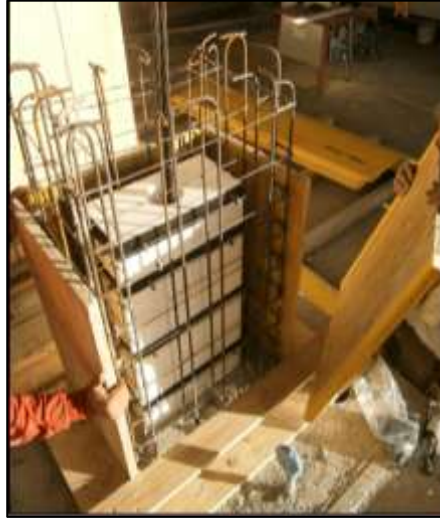
Figura 14: Chiusura della cassaforma del fusto della pila
