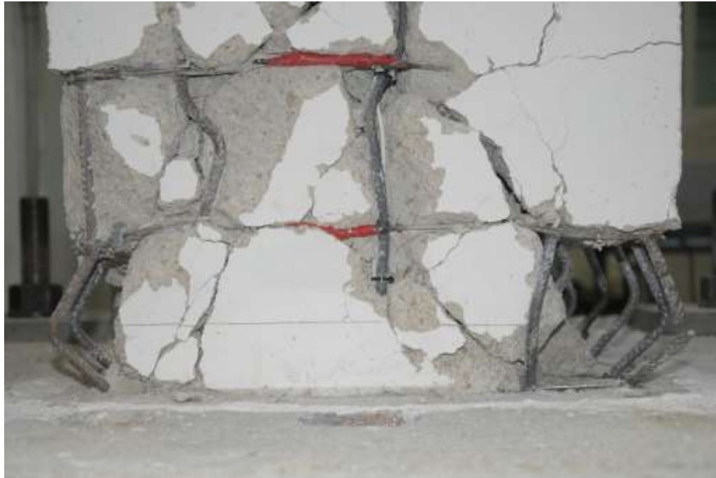
Figura 58: Buckling delle armature longitudinali in corrispondenza della sezione di base della Pila P2
