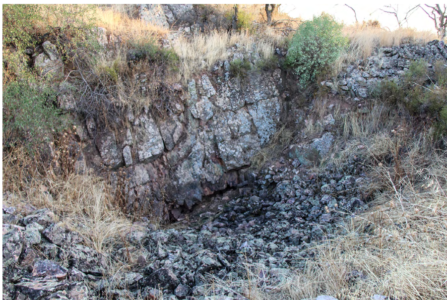
Fig. 3.—Fuente de los Pucheros. En la ladera norte se puede apreciar la presencia de infraestructura para el aprovechamiento del agua, surgencia y cisterna. Figura en color en la edición electrónica.
