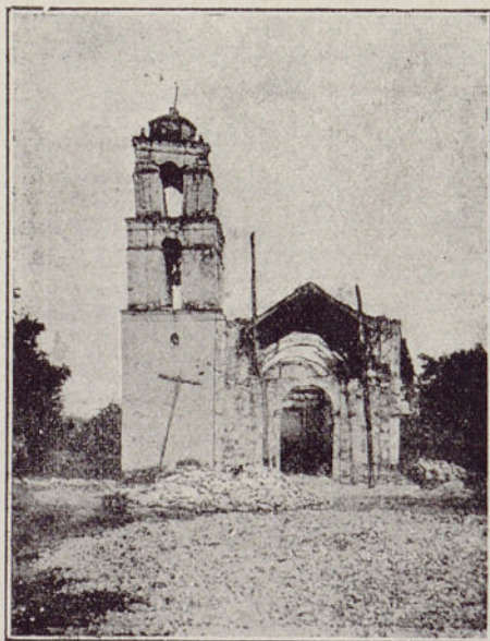
LÁM. V.—La iglesia de Aquilpa después del terremoto de Chilapa, la torre, seccionada en varios trozos, aun superpuestos, indica claramente los efectos de la inercia y de la reacción elástica, y además que la amplitud del movimiento no fué muy considerable.
