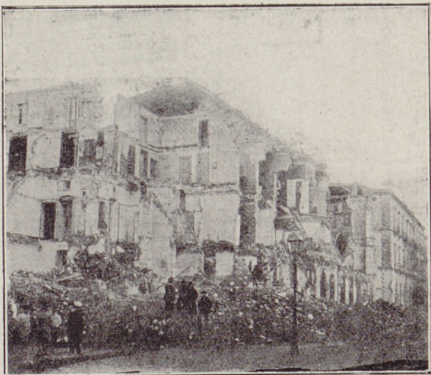
LÁM. VI.—Casas de la plaza Cavallotti después del terremoto de Messina, mostrando la destrucción de sus fachadas y de otros muros, debida a la mala calidad del material empleado. El desfondado de los pisos causó víctimas innumerables, y sin embargo, los tabiques en pie, las puertas aun cerradas y los cuadros todavía pendientes de los muros, indican un movimiento no más fuerte que el sentido en San Francisco, incomparablemente menos luctuoso, a pesar de su extensa área destructora y de lo poblado de ésta.
