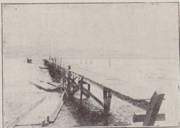
(b) Embarcadero de Inverness, cortado en dos y separados ambos trozos lateralmente unos 6 ms. (terr. de S. Francisco). (Omori.)
