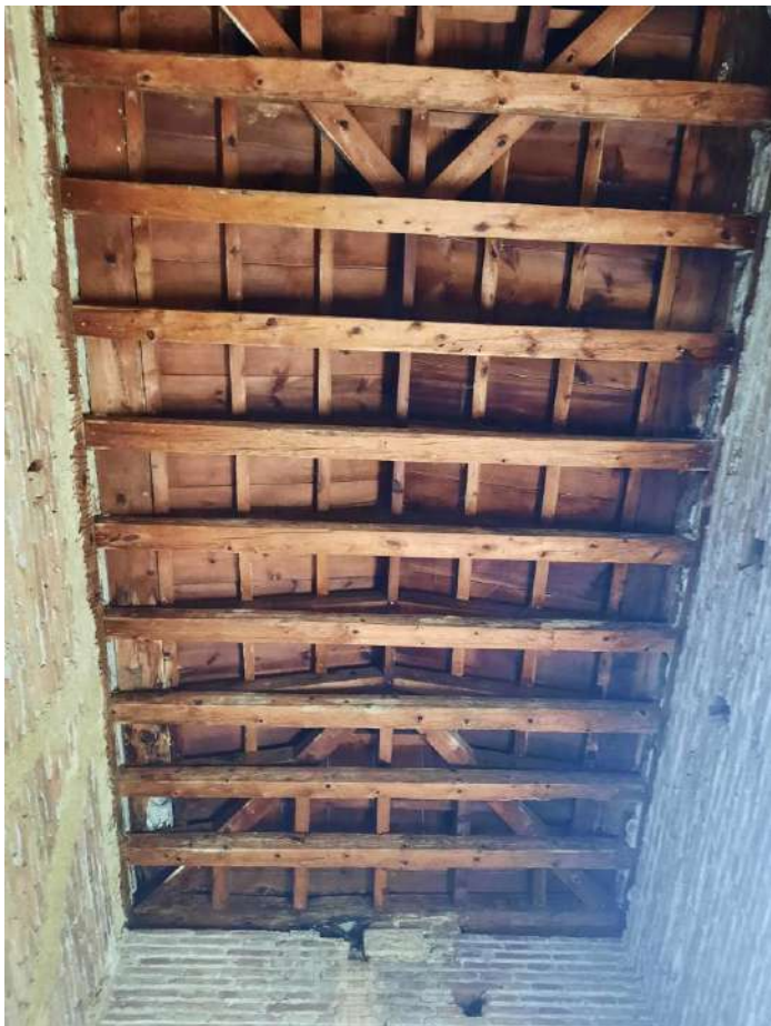
Fig. 127. Armadura de cerchas del torreón de levante del conjunto de la Sala de la Barca (Fotografía de la autora, 2022).
