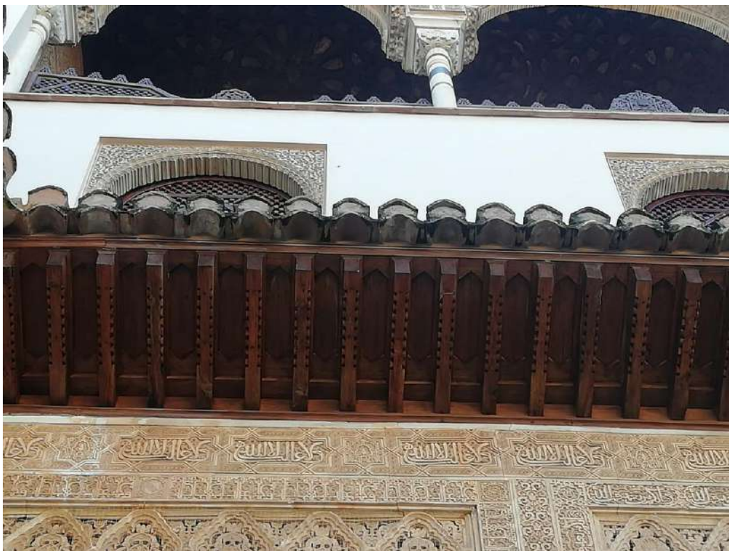
Fig. 230. Imagen del alero de la galería inferior del pórtico sur que Torres Balbás conserva y restaura. (Fotografía de la autora, 2020).
