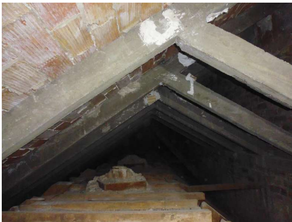
Fig. 128. Imagen de la estructura existente de hormigón armado que se sitúa sobre el artesonado que cubre el Cuarto Dorado. (Fotografía de la autora, 2017).
