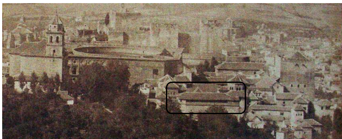
Fig. 49. Imagen de la galería de la Sala de los Reyes con la cubierta corrida. Clifford 1854. (FF Carlos Sánchez).
