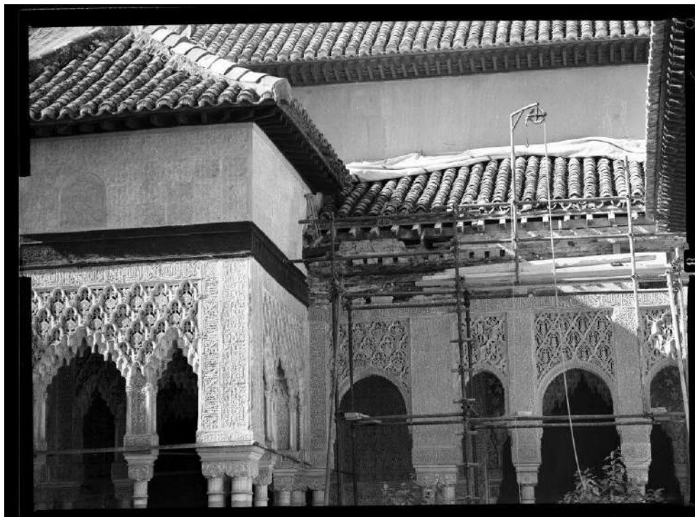
Fig. 108. Actuación del alero noroeste con la reposición de sus canecillos. Intervención que se lleva a cabo, como nos demuestra la imagen, una vez finalizada la construcción de la nueva altura de la Sala de los Mocárabes y cuando no se ha iniciado aún la restauración del cenador de poniente, puesto que se mantiene el atirantado entre columnas. Autor desconocido, 1964 (d.p.). (APAG/Colección de Fotografías/32689).
