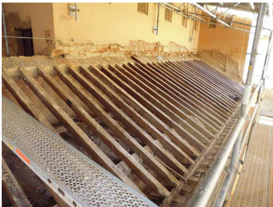
Fig. 123. Armadura de pares de la galería sur del Patio de los Leones previa a la reconstrucción de la obra de 2016-17. (Fotografía de la autora, 2016-17).
