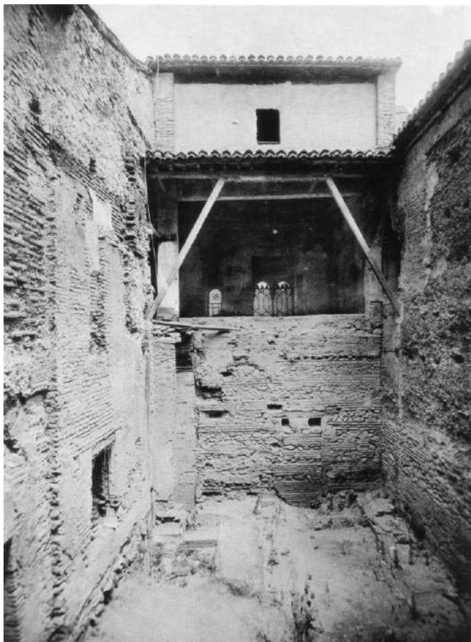
Fig. 169. Imagen del estado del patinillo que se encuentra Torres Balbás. Al fondo se ve el colgadizo de cubierta y el camaranchón que sobresale. Autor desconocido, sf. ( La Fachada del Palacio de Comares ).
