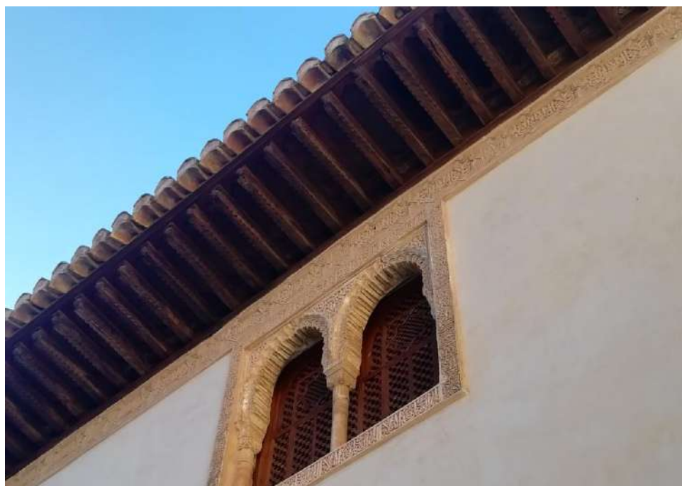
Fig. 222. Imagen del alero de la nave de poniente que Torres Balbás conserva y restaura. (Fotografía de la autora, 2020).
