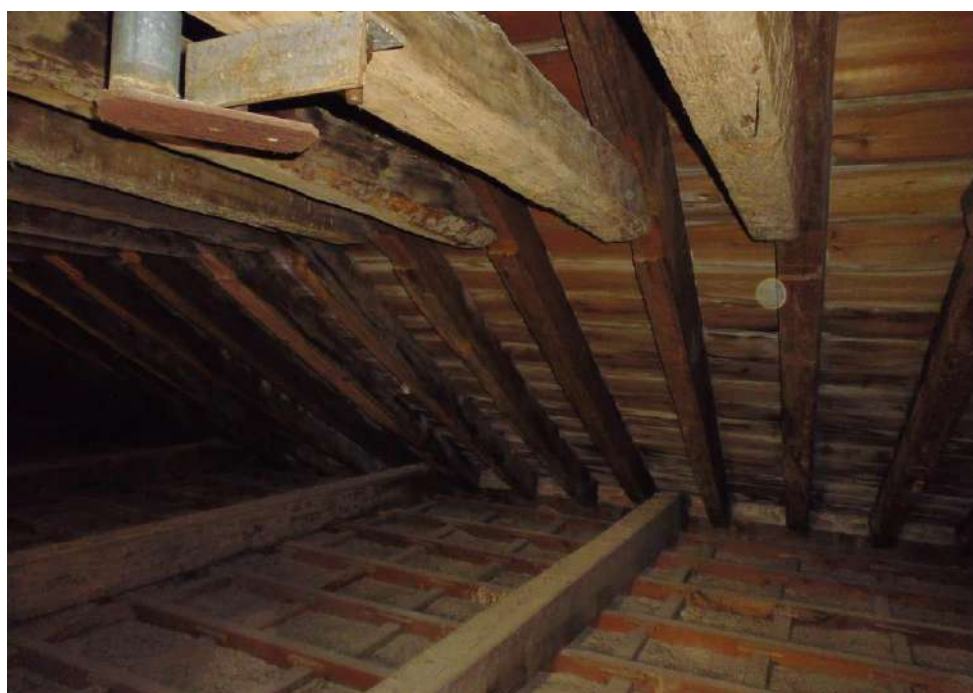
Fig. 121. Armadura de par y nudillo con tirantes de la cubierta del edificio del Mexuar. (Fotografía de la autora, 2017).
