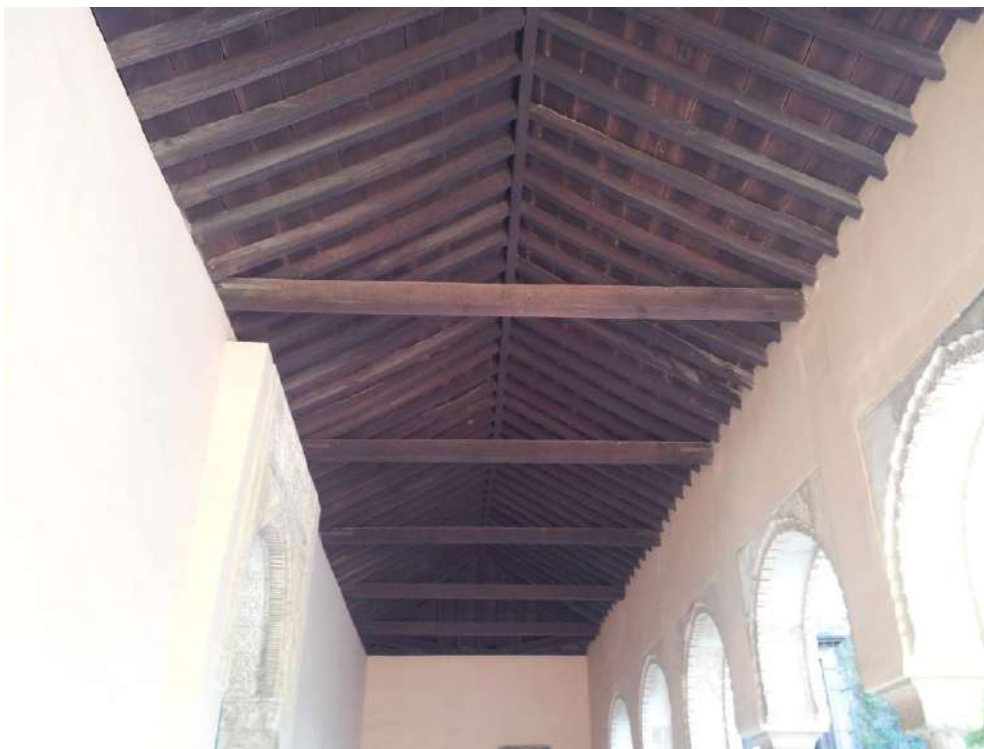
Fig. 119. Armadura de par e hilera de la Galería de Machuca. (Fotografía de la autora, 2014).
