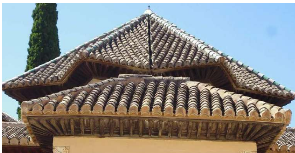
Fig. 131. Remate de las bocatejas con el sistema “a la granadina”. Cubiertas del mirador sur y Sala de Abencerrajes del Palacio de los Leones. (Fotografía de la autora, 2017).
