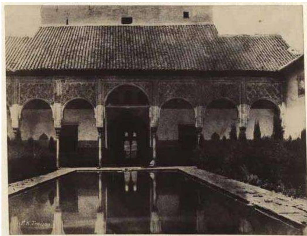
Fig. 54. Nave norte del Palacio de Arrayanes, antes de la transformación de mediados del siglo XIX. Se observa el faldón de cubierta continuo. Tenison, Eduard King, 1851. (Biblioteca virtual del Patrimonio, Link Fig. 54).
