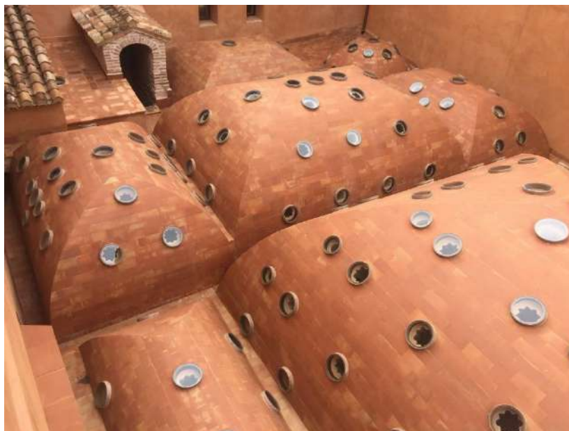
Fig. 112. Imagen del acabado dado a las bóvedas de los Baños de Comares tras su restauración. (Fotografía de Ramon Rivero Vargas, 2016).
