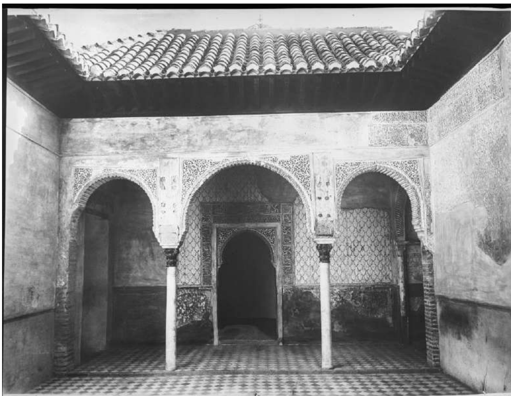
Fig. 85. Nave de levante tras su restauración y reconstrucción de cubierta. Torres Molina, Manuel, 1925. (APAG/ Colección de Fotografías/ F-00308).
