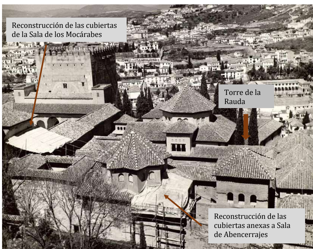
Fig. 104. Actuaciones de Prieto-Moreno en las cubiertas del Palacio de los Leones. Se observa la nueva cubierta de la Torre de la Rauda, y las obras en, anexos a Sala de Abencerrajes y Sala de los Mocárabes. Autor desconocido, 1963-1965 (d.p.). (APAG/ Colección de Fotografías/F-006891).
