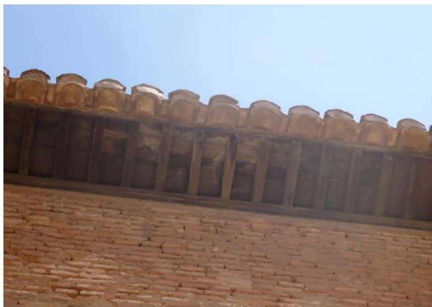
Fig. 292. Imagen actual que corresponde al alero colocado por Prieto Moreno, en los cuerpos que dan a calle Real Baja. (Fotografía de la autora, 2017).
