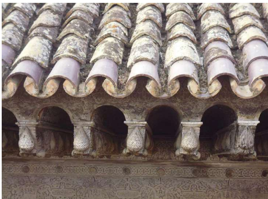
Fig. 130. Remate del faldón de la Fachada de Comares. (Fotografía de la autora, 2017).
