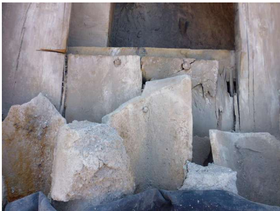
Fig. 129. Tejas clavadas en la cubierta de la Sala de Ajimeces. (Fotografía de la autora, 2017).
