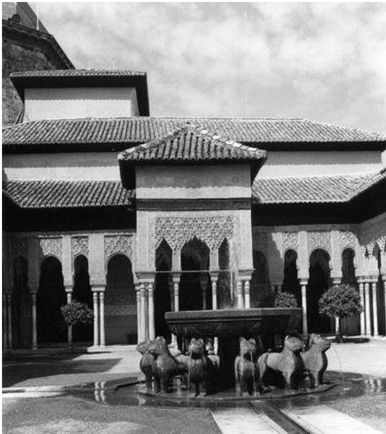
Fig. 294. Galería oeste del Patio de los Leones y Sala de los Mocárabes, tras la intervención de Prieto Moreno. Falta aún la actuación en el templete. Lala Aufsberg, 1964. (Fototeca Europea, Link Fig. 294).
