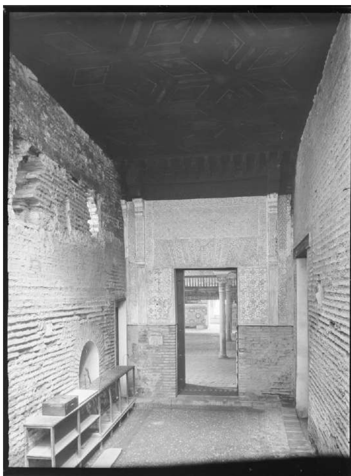
Fig. 78. Patio de entrada al Mexuar con armadura plana de madera. Torre Molina, Manuel. 1930 ca. (APAG/Colección de Fotografías/F-00106).
