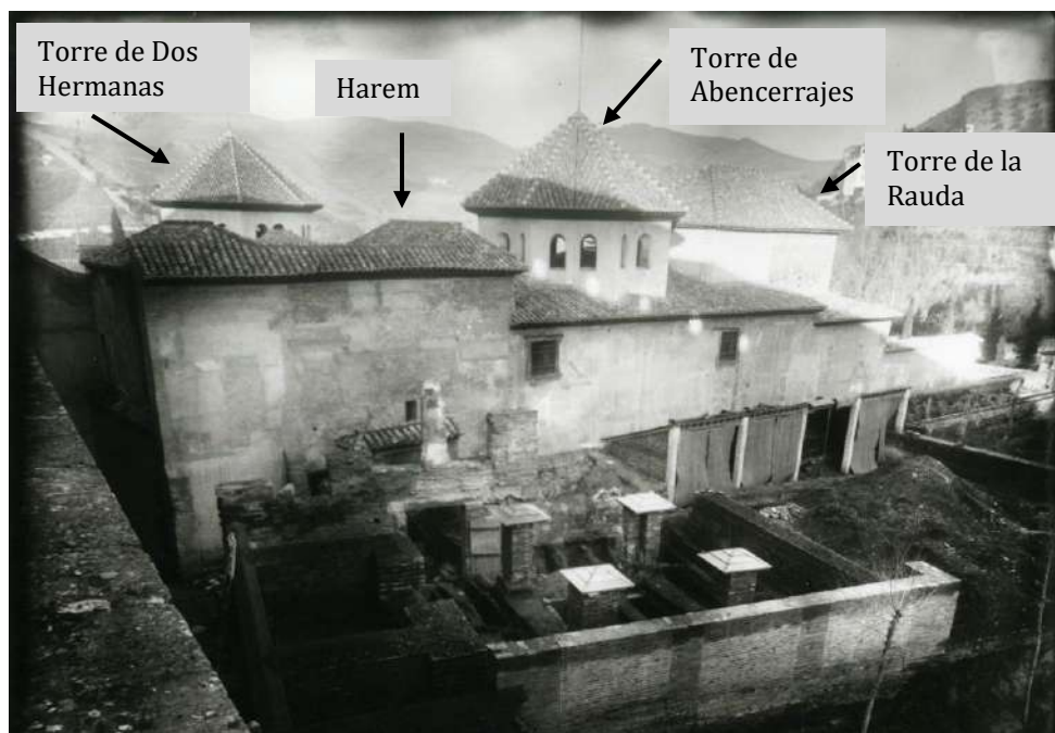
Fig. 279. Imagen posterior a las obras de 1915 en la torre de Abencerrajes y torre de Dos Hermanas. Autor desconocido, sf. (APAG/Colección de Fotografías/F-03329).
