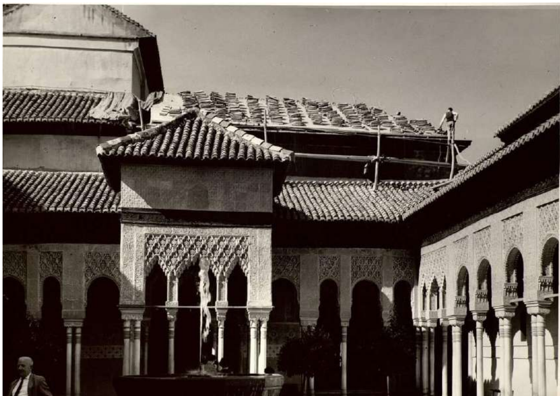
Fig. 103. Obras de construcción de la nave oeste (cubierta de la Sala de los Mocárabes). Autor desconocido, 1963-1964 (d.p.). (APAG/Colección de Fotografías/20711).
