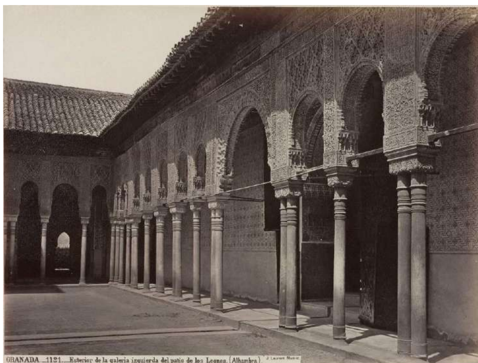
Fig. 52. Alero de la galería norte del Patio de los Leones. Se observa el importante alabeo y vencimientos que presentaba esta estructura. Estado de deterioro que debía de extenderse por todo el patio. J. Laurent. 1870. (Biblioteca Nacional de España, Link Fig. 52).
