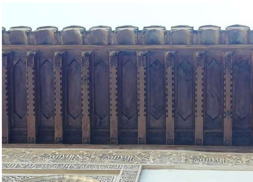
Fig. 225. Imagen del alero de la nave de saliente que Torres Balbás conserva y restaura. (Fotografía de la autora, 2020).
