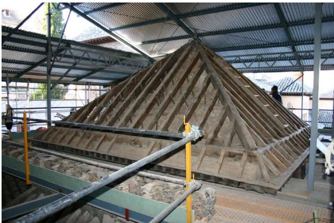
Fig. 120. Armadura de uno de los pabellones, previa a la reconstrucción de la obra de 2010. (FF de Pedro Salmerón Escobar).
