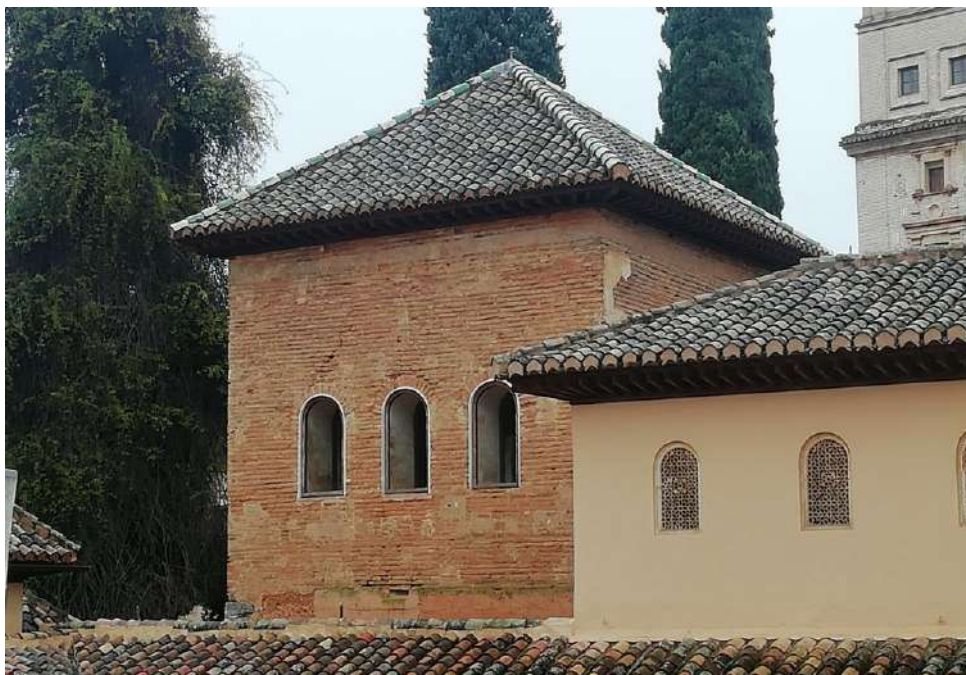
Fig. 302. Torre de la Rauda (Fotografía de la autora, 2020).
