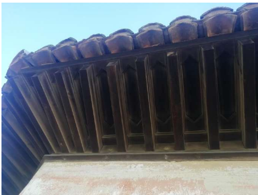
Fig. 310. Alero de la Sala de Dos Hermanas. (Fotografía de la autora, 2017).
