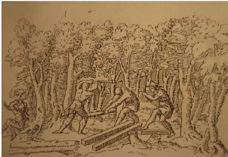
Fig. 317. Madereros trabajando en la tala de los árboles. (Felipe II. Los ingenios y las máquinas. Ingeniería y Obras Públicas en la época de Felipe II).
