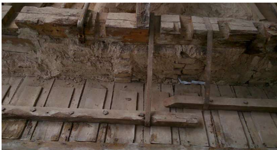
Fig. 135. Actuaciones de refuerzo de los aleros efectuadas por Torres Balbás en el Patio de los Leones. (Fotografía de la autora, 2016).
