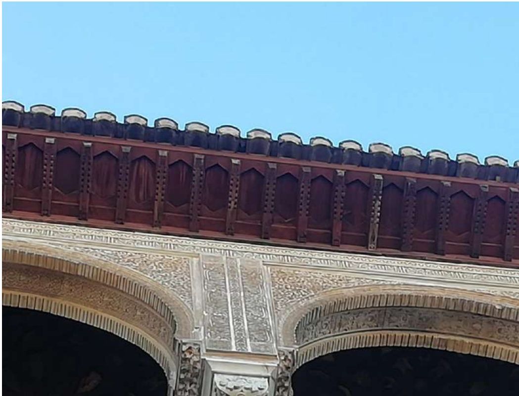
Fig. 229. Imagen del alero de la galería superior del pórtico sur que Torres Balbás conserva y restaura. (Fotografía de la autora, 2020).
