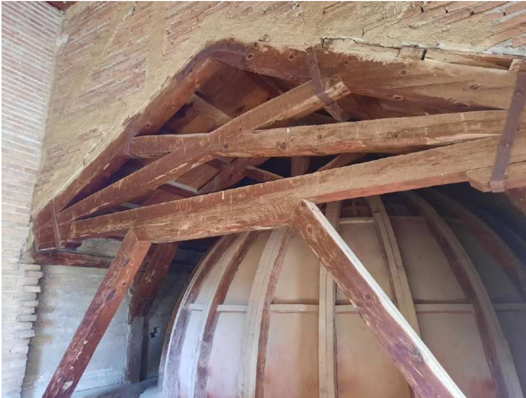
Fig. 126. Armadura de cerchas de la Sala de la Barca. (Fotografía de la autora, 2022).
