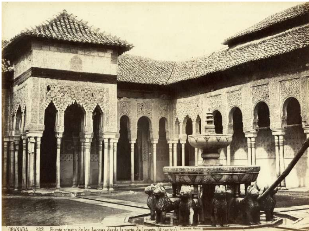
Fig. 63. Galería noroeste del Patio de los Leones, con las cubiertas aún sin restaurar. Jean Laurent, 1871. (APAG/ Colección de Fotografías/ F-05121).
