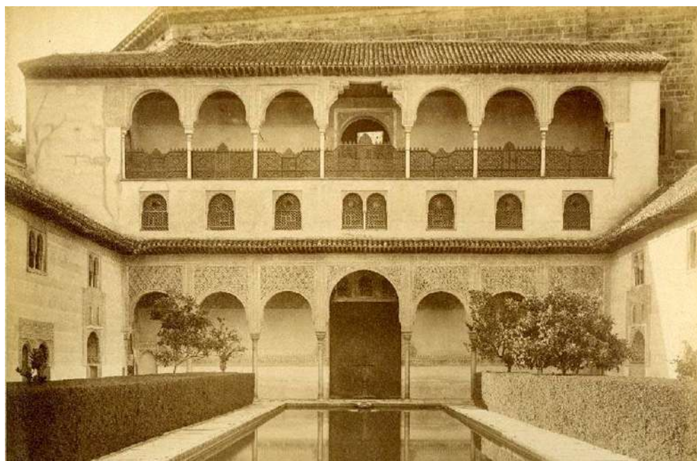
Fig. 218. Pórtico sur del Patio de Arrayanes. La imagen es posterior a la intervención en los aleros de la galería. Los alabeos en el alero han desaparecido, en cambio el faldón de cubierta presenta peor estado que en la imagen de 1871. Autor desconocido, sf. (APAG/Colección de Fotografías/F-13176).
