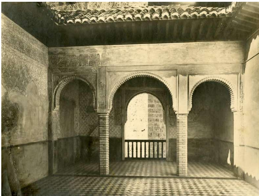
Fig. 86. Nave de poniente tras su restauración y reconstrucción de cubierta. Torres Molina, Manuel, 1925. (APAG/ Colección de Fotografías/ F-13076).
