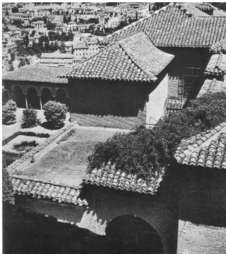
Fig. 185. Imagen de la cubierta plana tras el derrumbe de parte del cuerpo que remataba el edificio del Mexuar. Autor desconocido, 1978. ( La Alhambra ).
