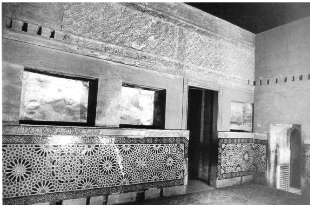
Fig. 142. Fotografía que muestra los canecillos de los aleros que daban al norte y este del patio junto al Mexuar en su origen. Autor desconocido, sf. ( La fachada del palacio de Comares ).
