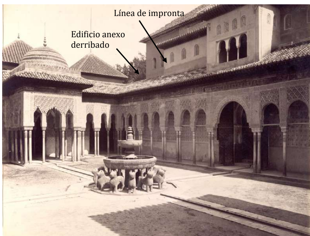
Fig. 267. Imagen de la esquina sureste del Patio de los Leones una vez iniciadas las obras de la galería sur. Se observa el nivel de pendiente que tenía el faldón sur antes de las obras en la impronta del edificio anexo al mirador de Abencerrajes. Autor desconocido, sf. (APAG/ Colección de Fotografías/F- 05389).
