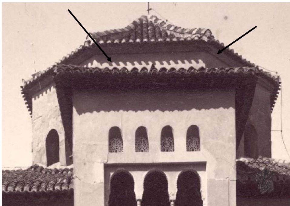
Fig. 281. Detalle de la Fig. 265. En la torre de Dos Hermanas podemos observar su alero de fábrica y el remate de sus faldones “a la toledana” (gracias a la sombra que proyecta en los muros). (APAG/ Colección de Fotografías/F- 05393).
