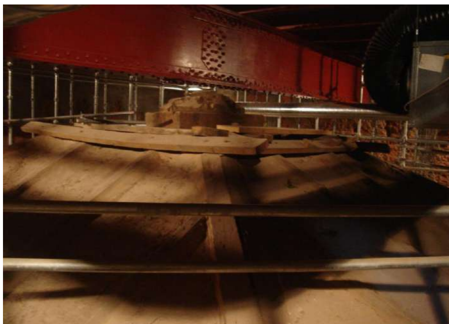
Fig. 84. Imagen inferior del forjado que sostiene la cubierta plana de la Torre de Comares, donde se visualiza la estructura metálica que instala Torre Balbás. (Fotografía de la autora, 2014).
