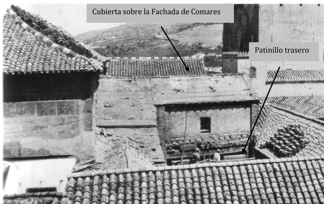
Fig. 76. Proceso de actuaciones en las cubiertas entre el cuerpo que alberga la Fachada de Comares y el patinillo trasero. Autor desconocido, sf. ( La Fachada del Palacio de Comares ).
