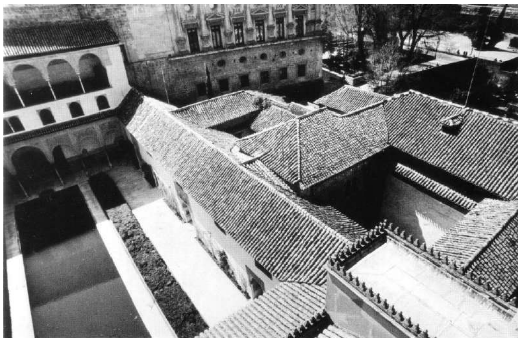
Fig. 235. Imagen de la nave de poniente del Patio de Comares del periodo de Prieto Moreno. José Jiménez Barrera, sf. ( La fachada del palacio de Comares ).
