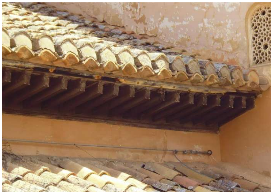
Fig. 309. Alero de la cubierta a poniente de la Sala de Dos Hermanas. (Fotografía de la autora, 2017).
