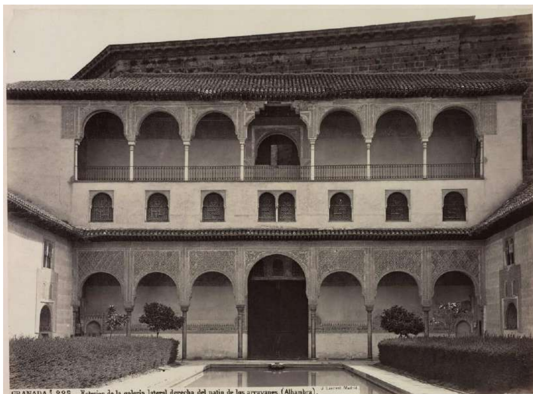
Fig. 217. Pórtico sur del Patio de Arrayanes. La imagen nos muestra un deterioro muy apreciable en el alero de la cubierta superior, con importantes alabeos y vencimientos. Estado previo a la actuación de Juan Pugnare. J. Laurent, 1870. (Biblioteca Nacional de España, Link Fig. 217).
