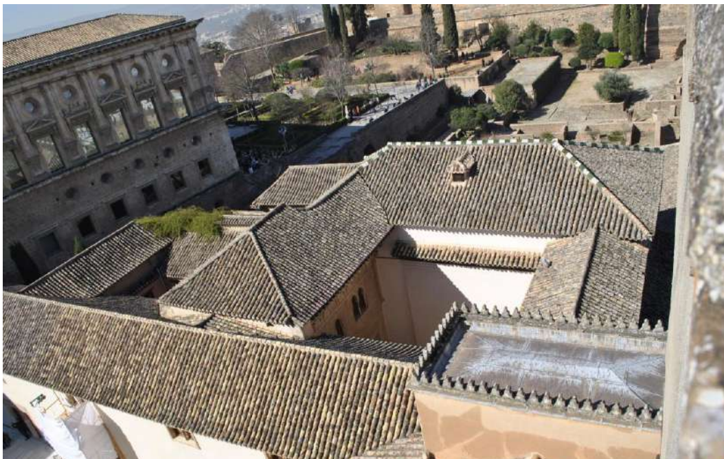
Fig. 189. Parte del conjunto del Mexuar en este periodo. La imagen nos permite saber el color de las limas y cumbreira del edificio del Mexuar, blancas y verdes. (Fotografía de la autora, 2014).
