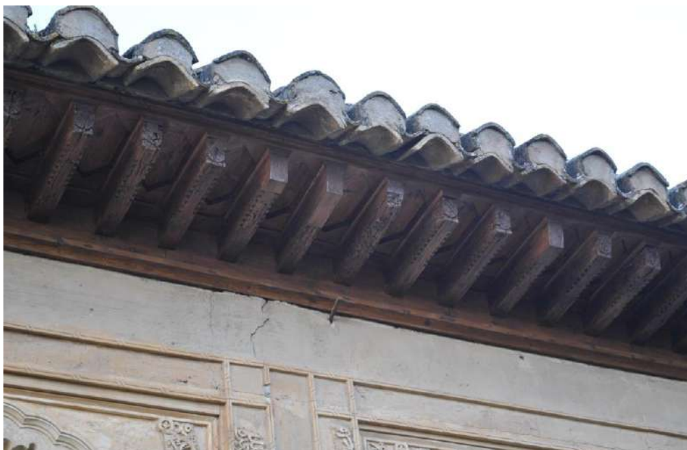
Fig. 139. Alero de la galería norte del Patio de Machuca, donde se conservan aún canecillos originales. (Fotografía de la autora, 2017).
