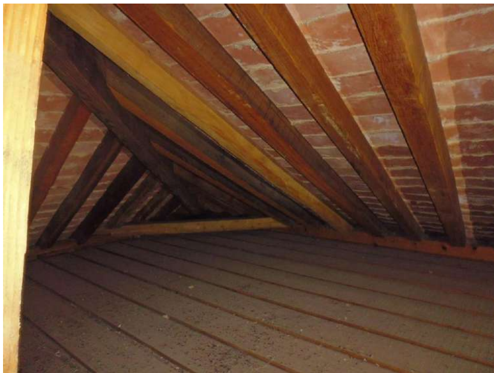
Fig. 122. Armadura sobre el Oratorio con cuadral en la esquina. (Fotografía de la autora, 2017).
