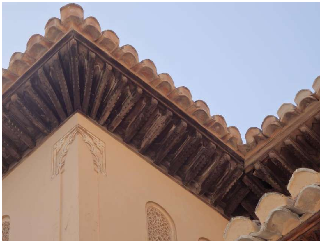
Fig. 277. Imagen del alero del mirador de Abencerrajes, probablemente similar a la dada en las obras de este periodo (Fotografía de la autora, 2017).
