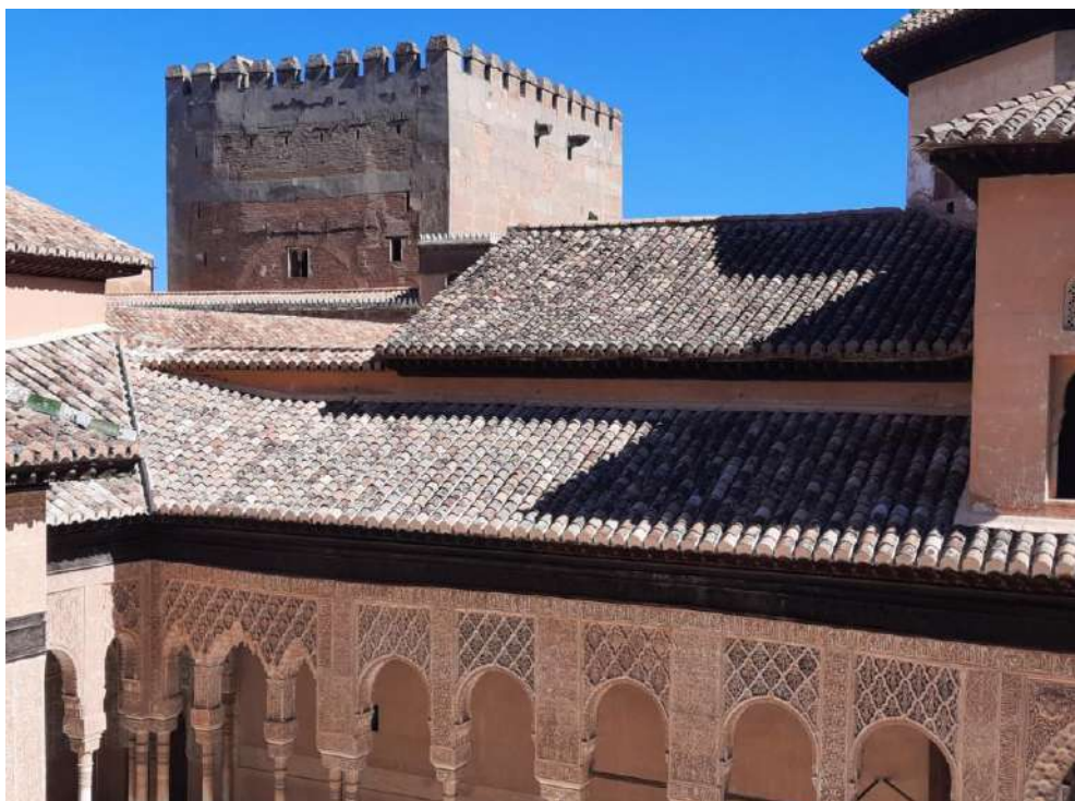
Fig. 300. Imagen de las cubiertas de la galería noroeste del Patio de los Leones, tras las obras de 2020-21. (Fotografía de la autora, 2021).
