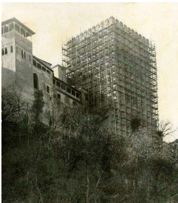
Fig. 323. Vista de la Torre de Comares durante el proceso de restauración. Torres Molina, 1931. (APAG/Colección de fotografías/F-13052).
