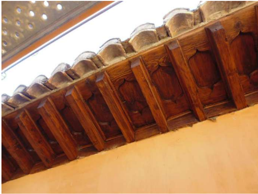
Fig. 312. Alero de la cubierta de la Sala de Ajimeces. (Fotografía de la autora, 2017).
