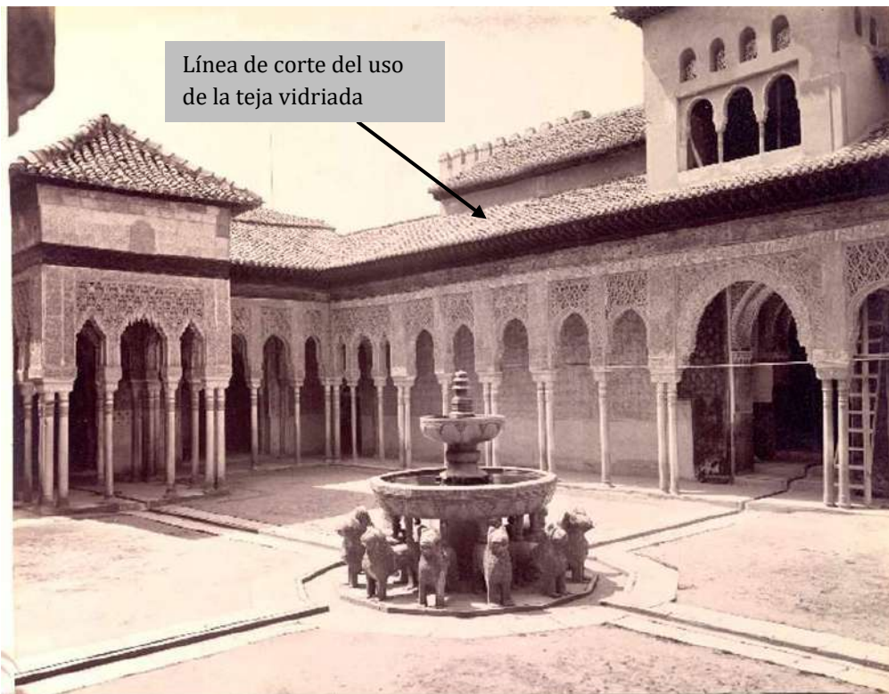
Fig. 64. La imagen nos muestra el faldón norte con tejas vidriadas hasta la mitad del cuerpo adyacente a la Sala de Dos Hermanas y el resto hasta la esquina, también restaurado, pero con teja sin vidriar. Esta última parte es la que creemos restaurada por Mariano Contreras. García Ayola, José (1863-1900). (APAG/ Colección de 227 Fotografías/ F-05392).
