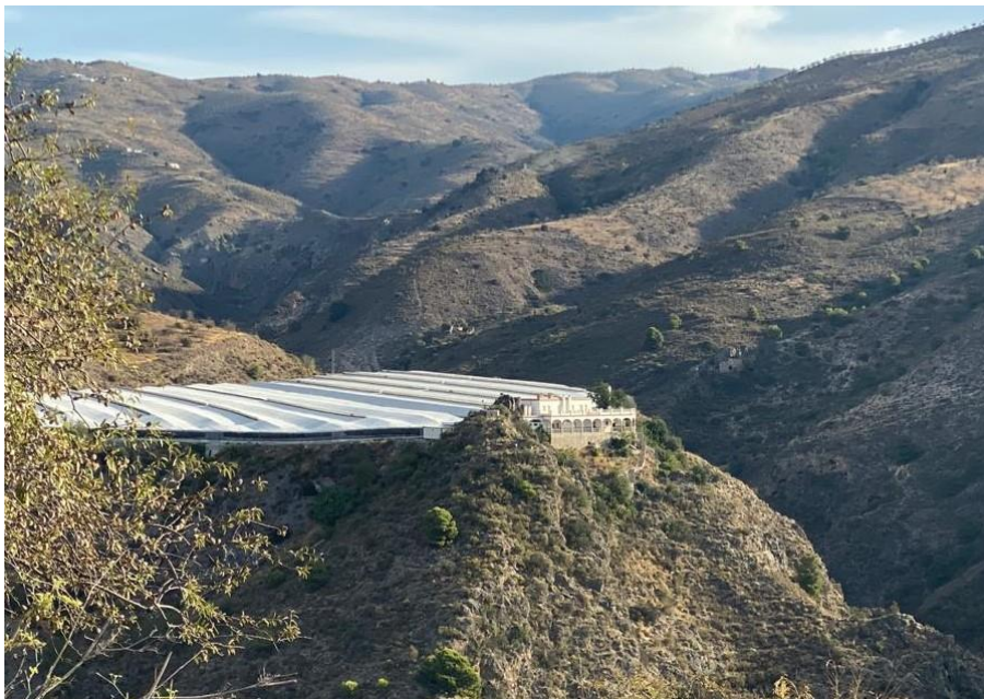
Figura 7: De los autores, Nuevas edificaciones caracterizan el hábitat diseminado. Vivienda-almacén junto a invernadero sobre el barranco de las Angosturas (Elaboración propia).
