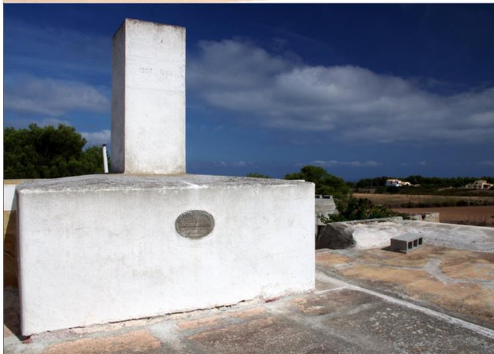
El vértice Mola en la Isla de Formentera. En la parte superior se presenta la ficha técnica del mismo, con las distancias angulares a los vértices Furnás y Mongó. La imagen fotográfica es actual, leyéndose en el pilar superior 1807 y 1868, en la inferior figura la placa elíptica que lo identifica como integrante de la Red Geodésica principal gestionada por el Instituto Geográfico Nacional.
