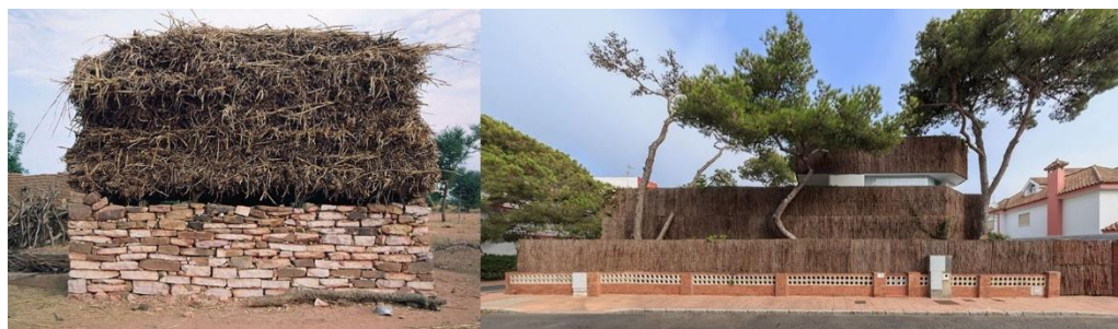
Figura 6: Antonio Jiménez Torrecillas, Apilamiento de caña de maíz sobre estructura de madera de higuera, muro mampuesto construido en seco con piedra y ripios del lugar. El interior se utiliza como establo. Alaile, Kokolo. Malí (Jiménez Torrecillas, “El viaje...”) (izda.) y Antonio Luis Martínez Cano, Casa en Rota, Cádiz (www.antonioluismartinez.com) (dcha.).
