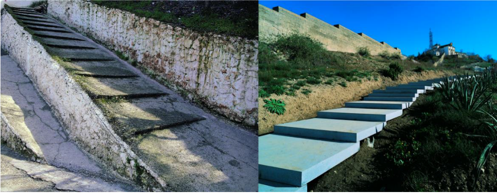
Figura 1: Antonio Jiménez Torrecillas, Rampa escalonada. Acuerdo entre calles, Cogollos Vega. Sierra de Cogollos, Granada (Jiménez Torrecillas, “El viaje ...”) (izda.) y David Arredondo y Alberto García, Intervención en los alrededores de la Muralla Zirí en el Alto Albaicín, Granada , (Plataforma Arquitectura) (dcha.).
