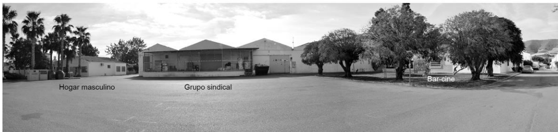
Espacio público central - Plaza Juan de Austria
