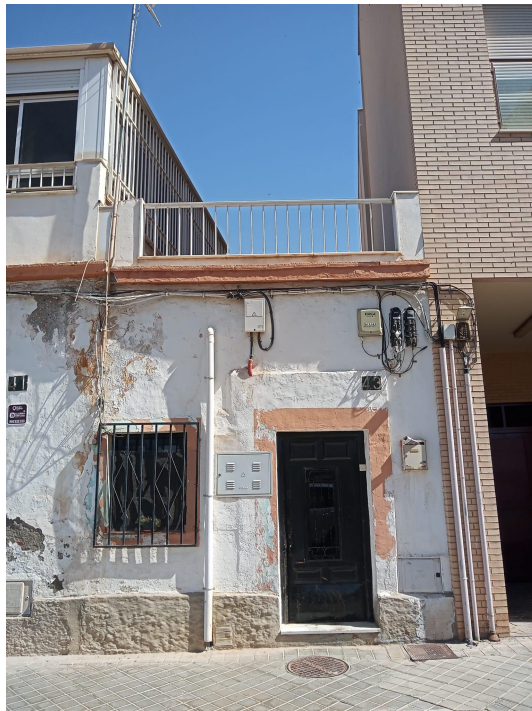
Anexo 18. Vivienda obrera o de jornaleros en la calle San Luis nº 43. Imagen propia.
