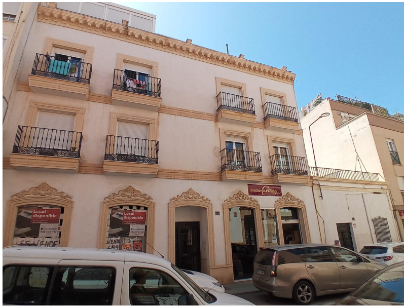
Anexo 39. Estado actual calle Granada 66. Imagen propia.
