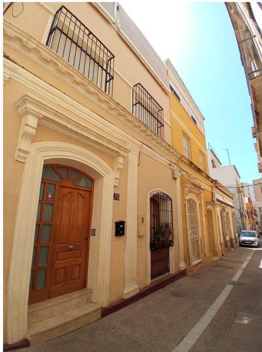
Anexo 37. Estado actual calle El Pueblo 26 y 24. Imagen propia.
