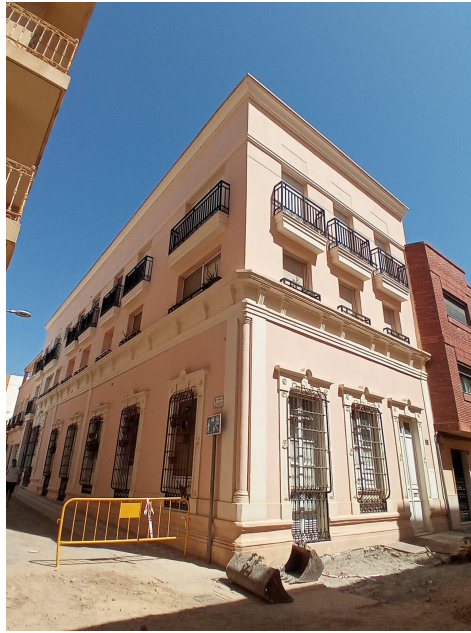
Anexo 43. Estado actual calle Cruces 57. Imagen propia.
