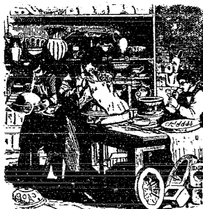
Fig. 216.—Moldeo por coladura
