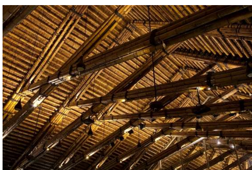
Figura 121. Detalle del techo de bambú del Dai Lai Conference Hall. Fuente: Hiroyuki Oki.
