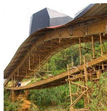
Figura 81. Puente de Santo Domingo Savio (Medellín, Colombia). Fuente: SENA.
