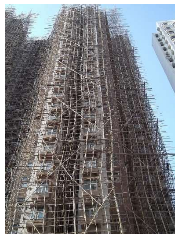
Figura 35. Andamio de bambú en un rascacielos.
