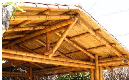
Figura 61. Cubierta realizada con Guadua . Fuente: Bambusa Estudio.
