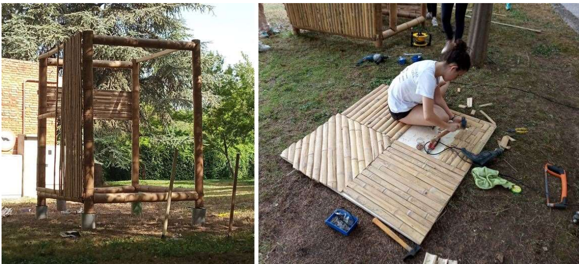
Figura 134. Fabricación de las paredes y del suelo del modelo experimental
