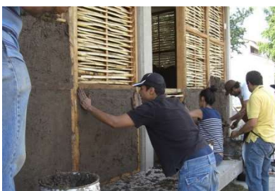
Figura 66. Cerramiento construido con bahareque encementado. Fuente: Plataforma Arquitectura.
