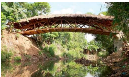
Figura 84. Puente construido con Dendrocalamus asper en Davao (Filipinas). Fuente: Andrea Fitrianto.
