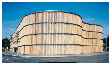
Figura 98. Fachada del aparcamiento del zoológico de Leipzig (Alemania). Fuente: Architectuul.
