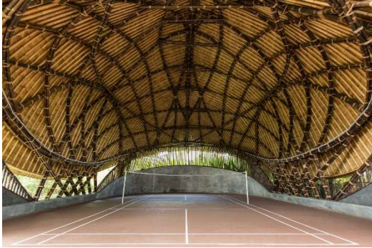
Figura 114. Interior de la Kura Kura Badminton Court. Fuente: Tommaso Riva.
