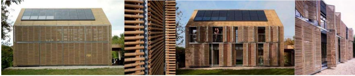
Figura 100. Passive House en Bessancourt (Francia), obra de Karawitz Architecture. Fuente: Hervé Abbadie y Karawitz.
