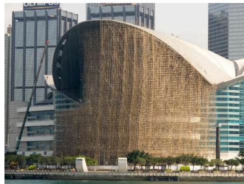
Figura 69. Andamio de bambú en la construcción de un edificio de Hong Kong. Fuente: Plataforma Arquitectura.
