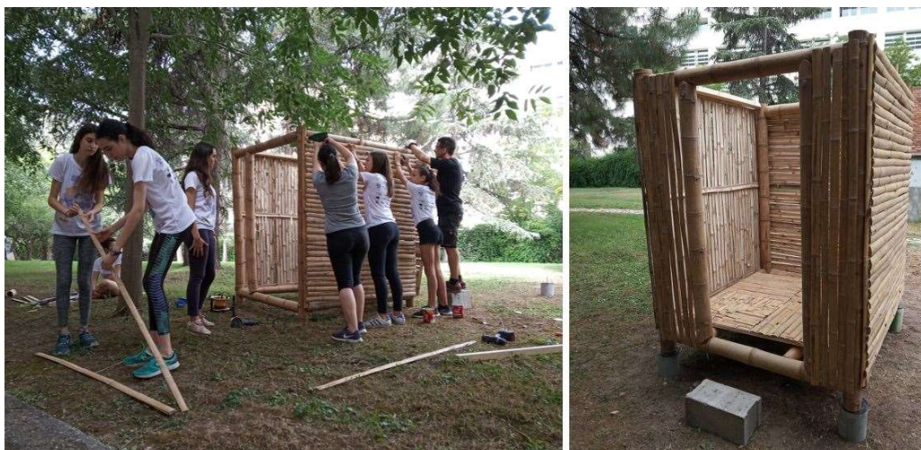
Figura 135. Montaje y finalización del modelo experimental
