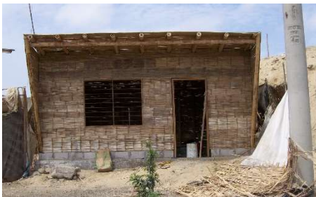
Figura 73. Módulo de vivienda de 22 m 2 construido por el IVUC en Pisco (Perú). Fuente: IVUC.
