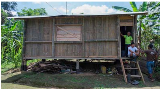
Figura 70. Vivienda tradicional de bambú en la región de Esmeraldas (Ecuador). Fuente: Semana Sostenible.
