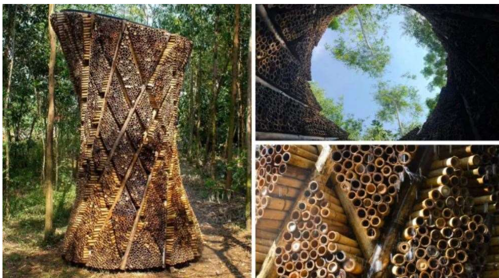
Figura 8. Torre de refrigeración adiabática de AREP Fuente: AREP
