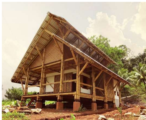
Figura 75. Casa modelo diseñada por Bambú Social y la BICU en El Rama (Nicaragua). Fuente: Archivo Digital Arquitectura Panamericana.
