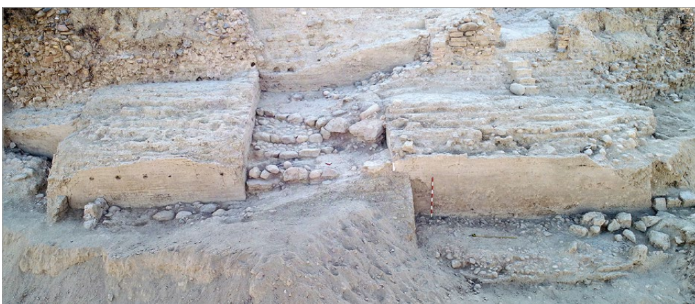
fig. 7 – Restos de la muralla y torres realizadas en tapial calicostrado de Mojácar la Vieja (Mojácar, Almería).
