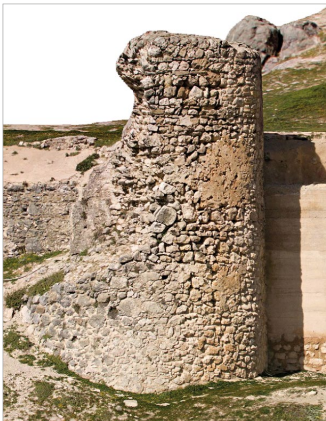
fig. 8 – Ortofotografía de una de las torres de mampostería enripiadas nazaríes de la fortaleza de Píñar (Granada) (BENAVIDES LÓPEZ et al. 2020).
