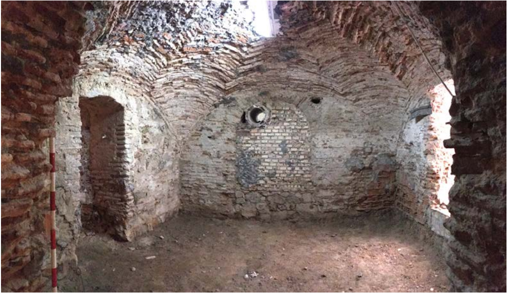
Figura 6. Vista del arco tapiado que permitía la comunicación interna del sótano, acceso principal (izquierda) y roto en el muro (derecha).
