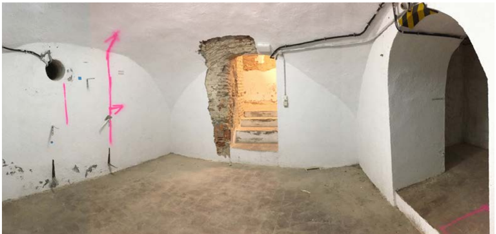
Figura 5. Aspecto de la bóveda central y acceso contemporáneo (E11) antes de iniciar los trabajos arqueológicos, con el acceso B aún tapiado (izquierda) y E (derecha).
