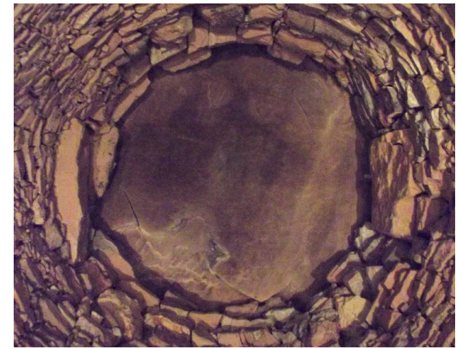
57_Losa de cubierta de la falsa cúpula de la cámara principal del Romeral.
