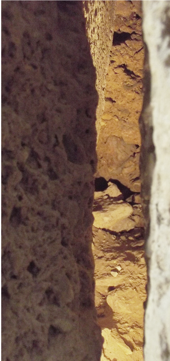
40_Izq. Encuentro entre ortostatos verticales. Se aprecia la profundidad de estos.
