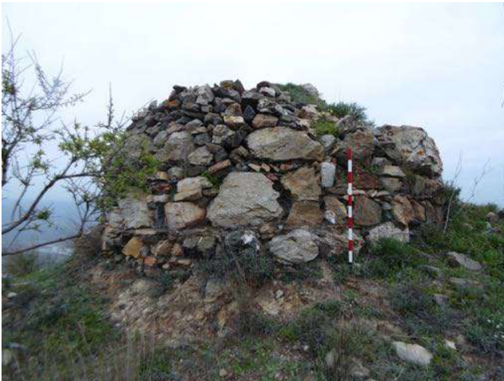
Figura 762: Restos de la torre alta de Benamargosa. Fuente: elaboración propia.
