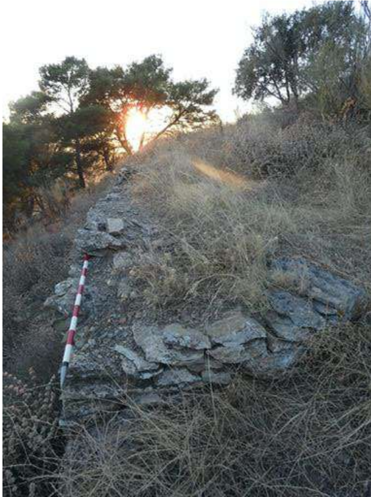
Figura 64: Estructura muraria en el cerro de Jotrón. Fuente: elaboración propia.
