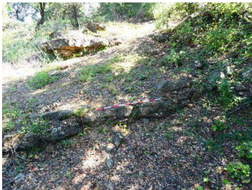
Figura 49: Posible resto de muro. Fuente: elaboración propia.
