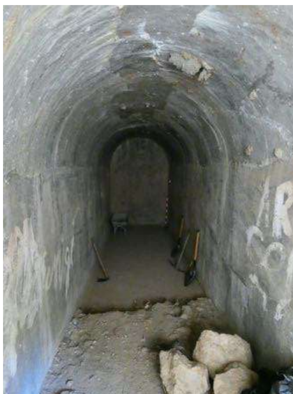
Figura 503: Interior del aljibe de la fuente Delgada durante las tareas de limpieza. Fuente: elaboración propia.
