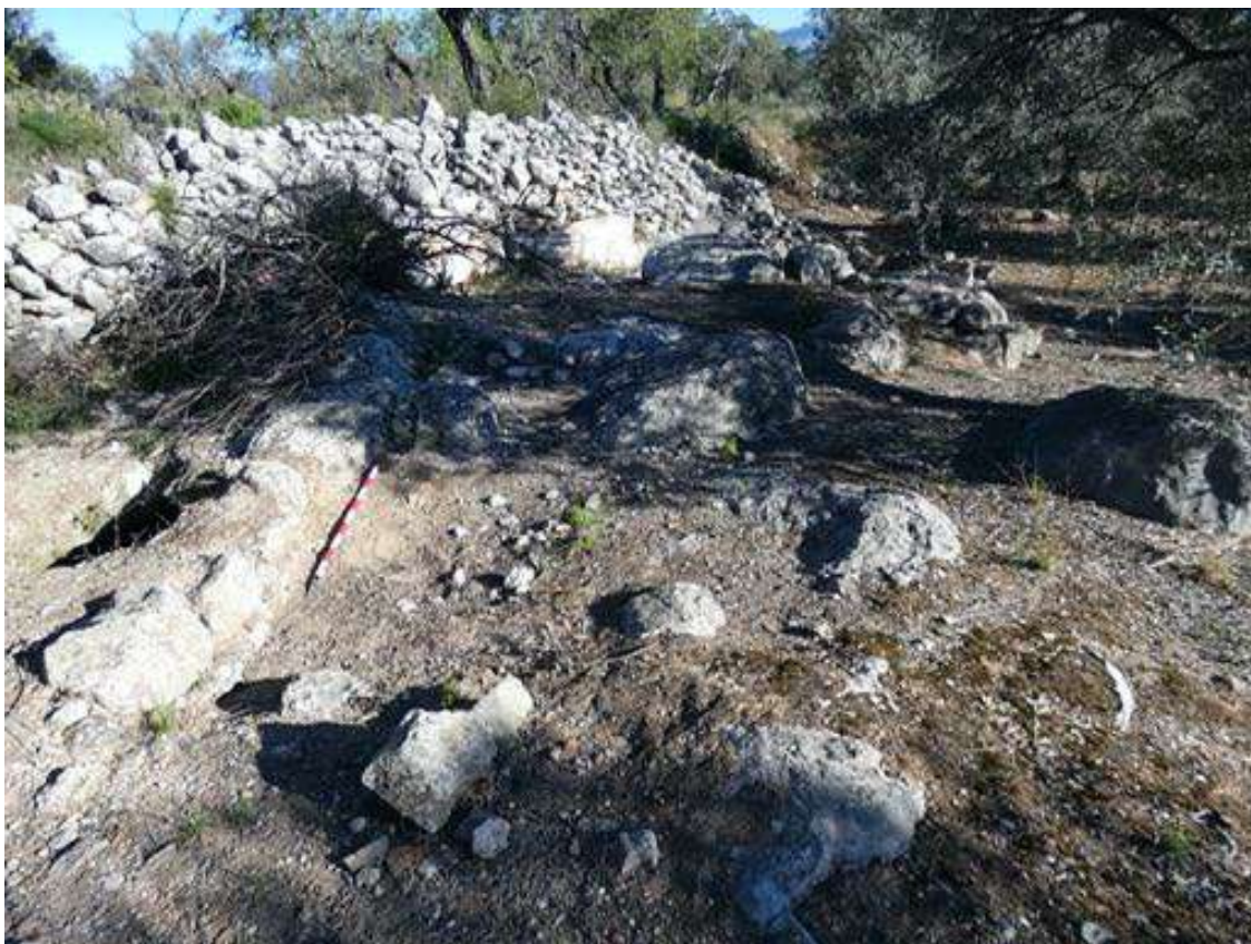
Figura 151: Estructura situada al noreste del aljibe, junto a un silo, tal vez esté vinculado a uno de estos aljibes. Fuente: elaboración propia.
