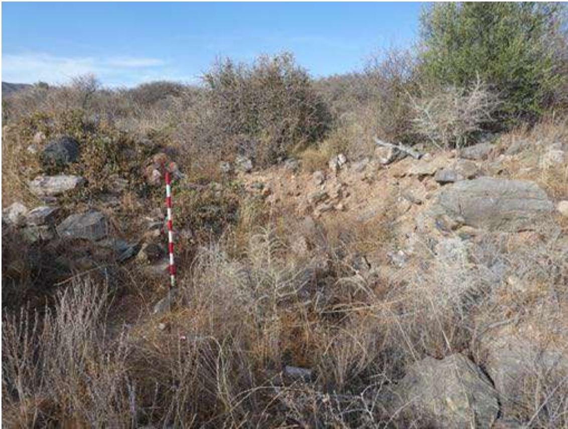
Figura 278: Apertura o rotura entre los lienzos 4 y 5. Fuente: elaboración propia.
