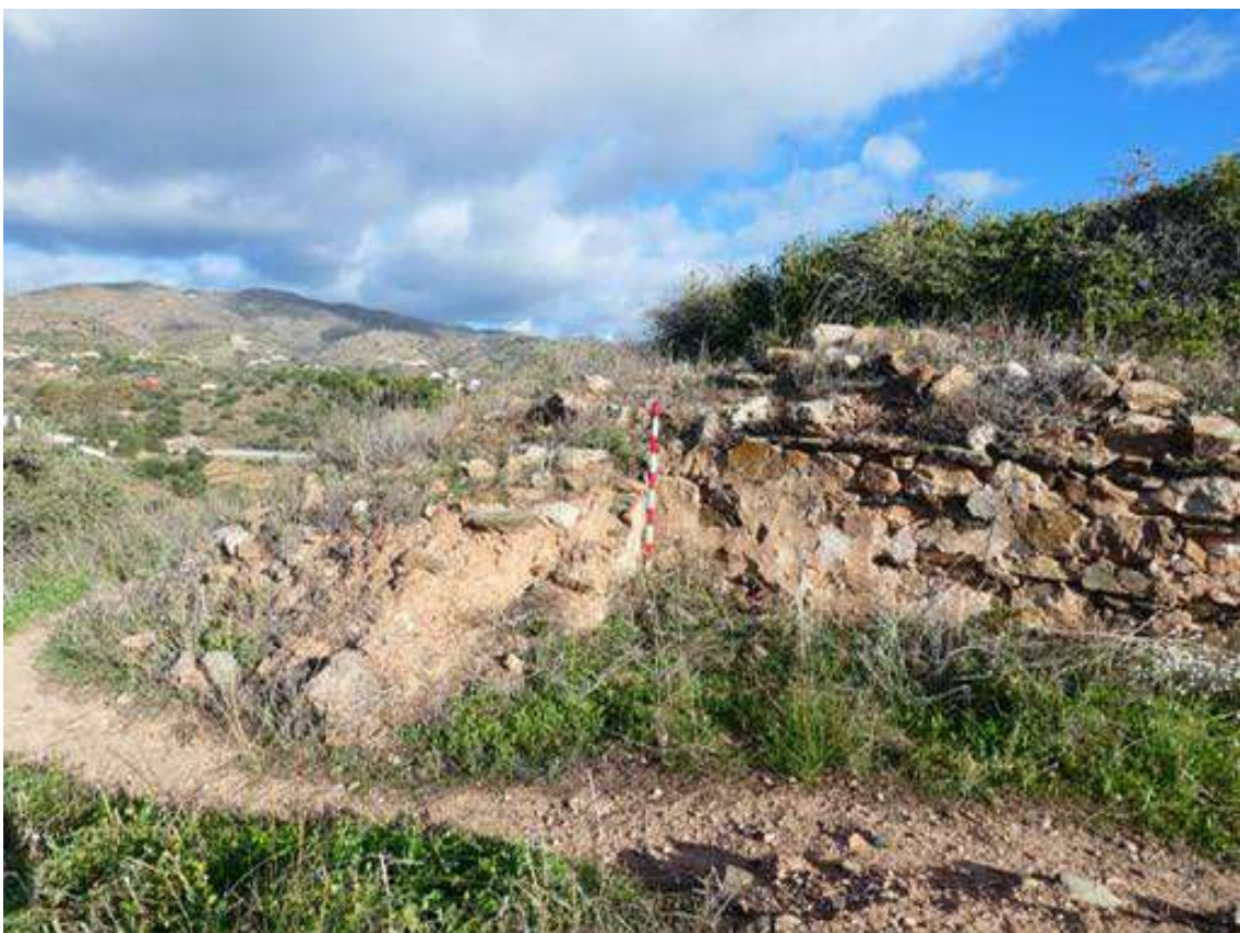
Figura 289: Torre 2 junto al lienzo 3. Fuente: elaboración propia.
