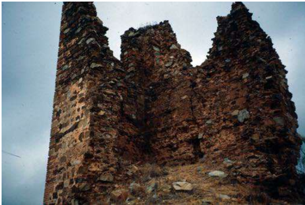
Figura 811: Interior de la torre de Salazar antes de la restauración. Fuente: ADPM, signatura: DP-8-1.
