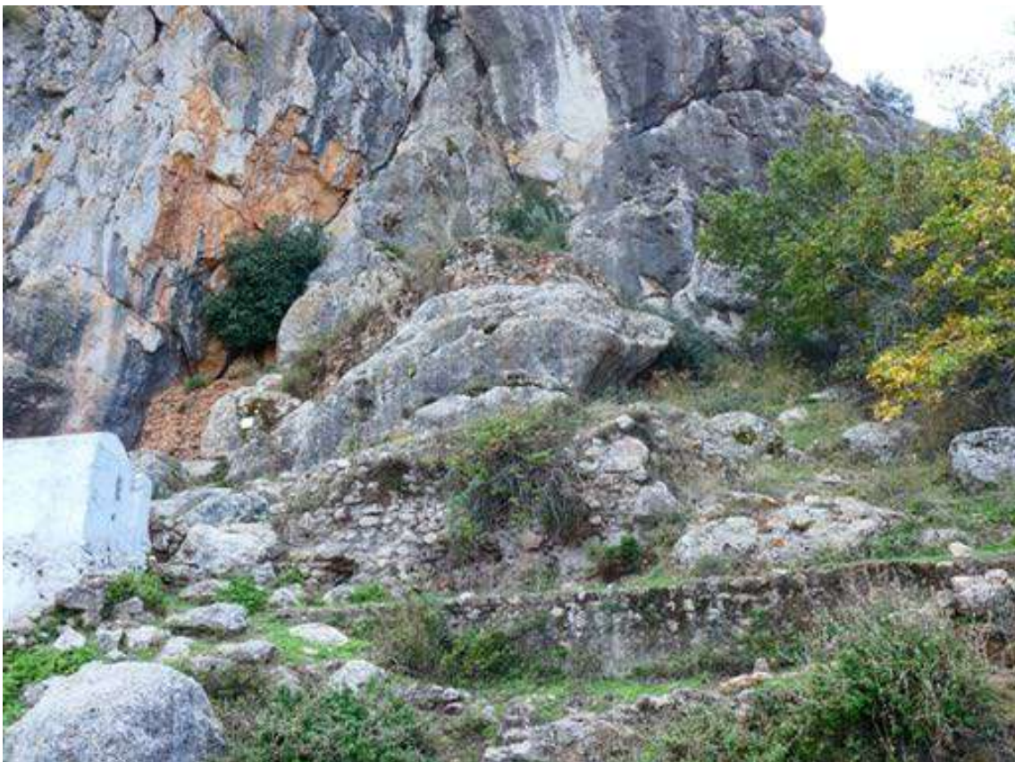
Figura 487: Vistas del ángulo norte de la Coracha en la parte superior. Fuente: elaboración propia.
