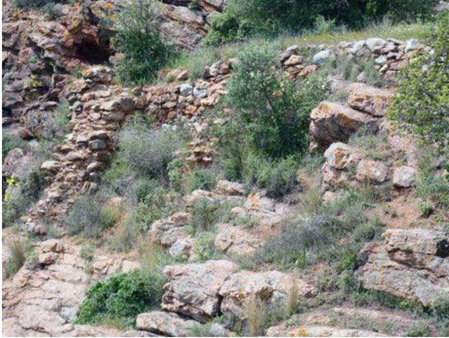
Figura 56: Vista de la construcción desde enfrente. Fuente: elaboración propia.
