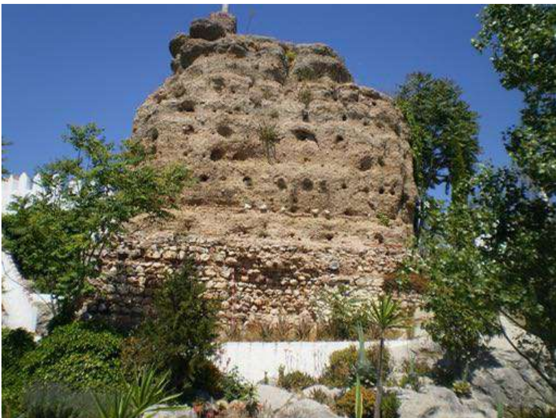
Figura 449: Vista de la cara oeste de la Tahona. Fuente: elaboración propia.
