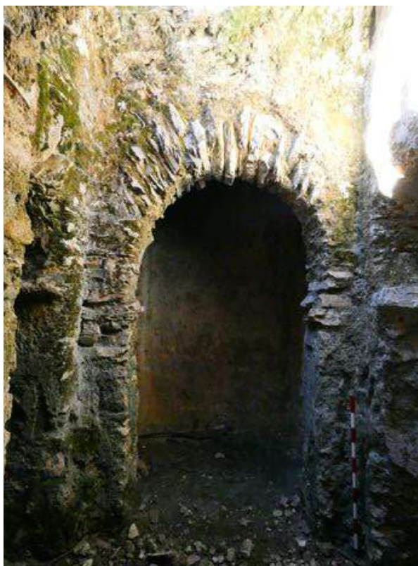
Figura 146: Arco de herradura del hueco que divide el compartimento IV y el V. Fuente: elaboración propia.
