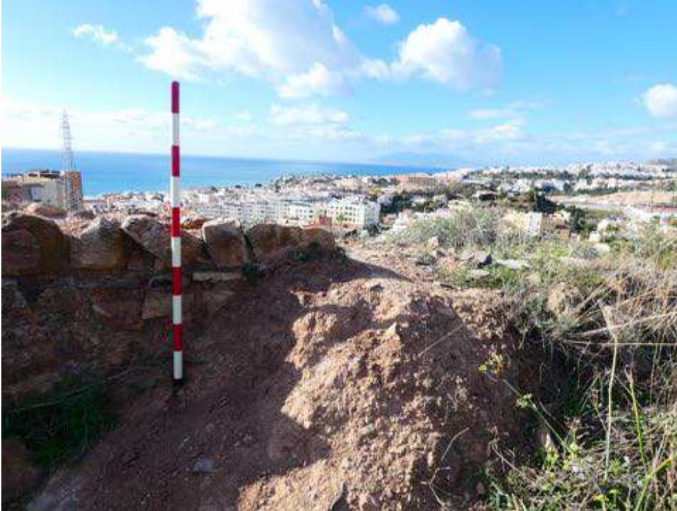
Figura 268: Vertido de tapial en la sección interior del lienzo 3. Fuente: elaboración propia.
