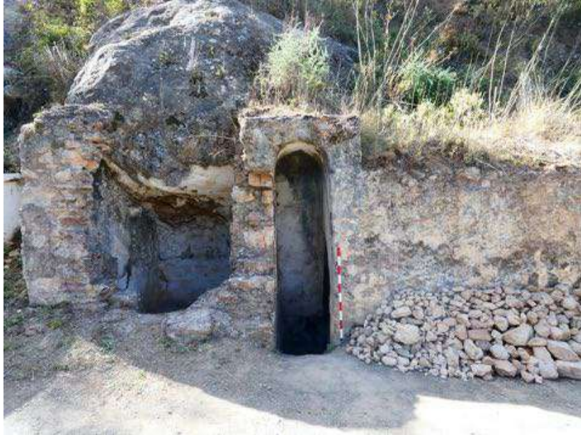
Figura 504: Entrada al aljibe de la fuente Delgada y alcubilla decantadora. Fuente: elaboración propia.
