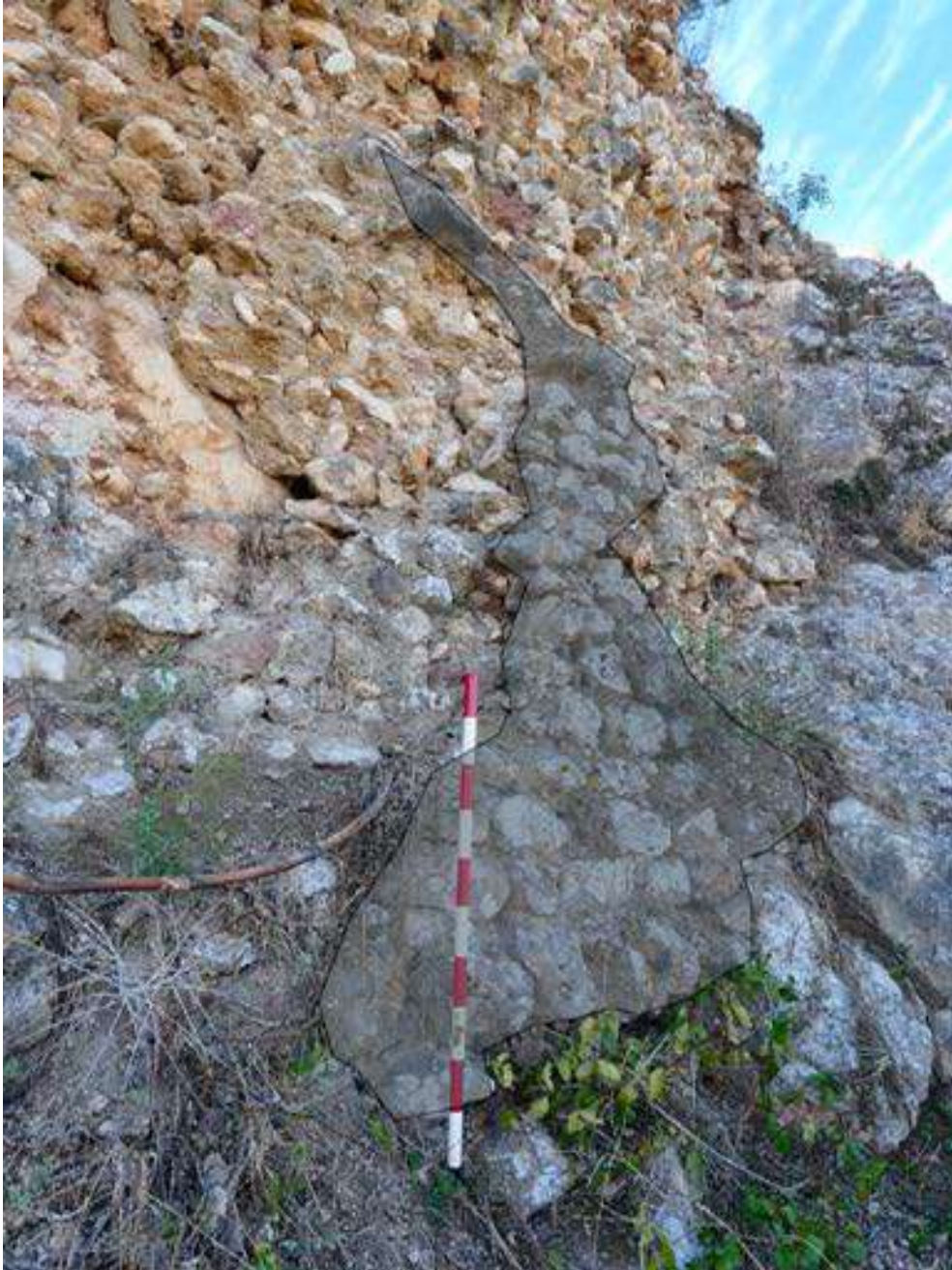
Figura 468: Cuerpo inferior del lienzo 3 donde apenas se conservan los mampuestos externos. Fuente: elaboración propia.
