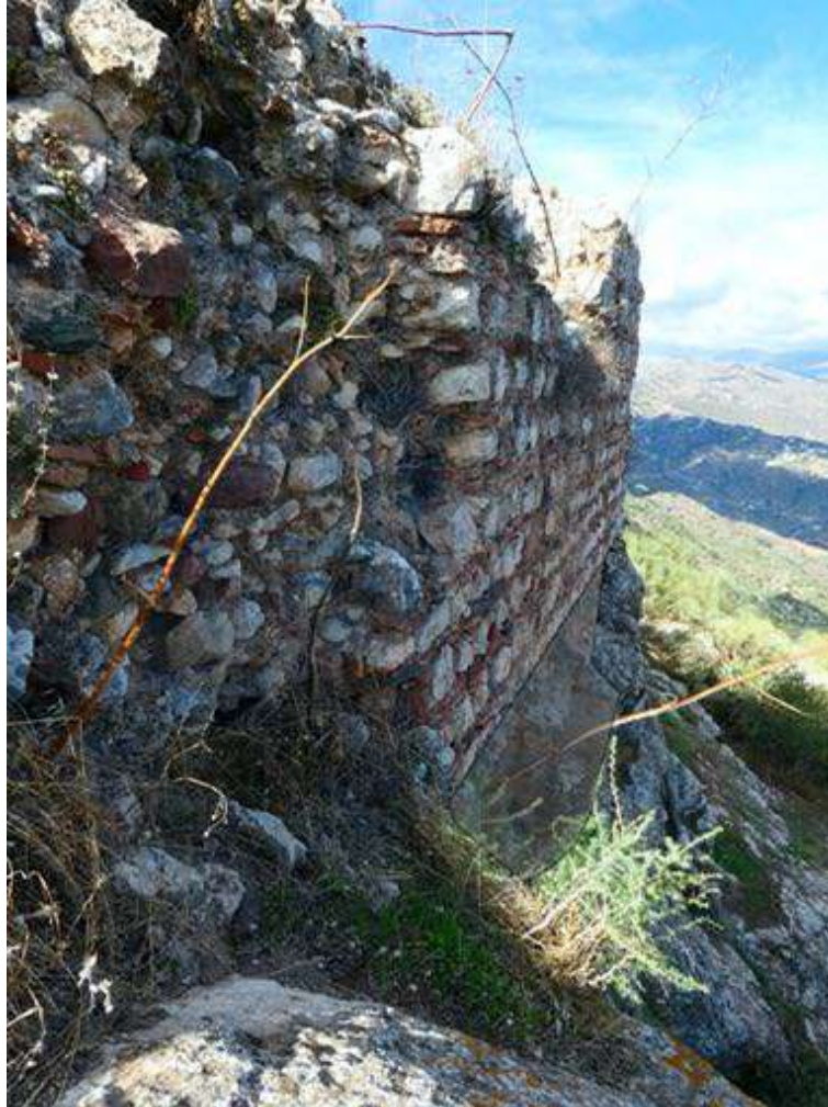
Figura 469: Cuerpo superior del lienzo 3. La parte sombreada bajo la obra nazarí muestra el ángulo distinto con respecto la fase constructiva anterior. Fuente: elaboración propia.
