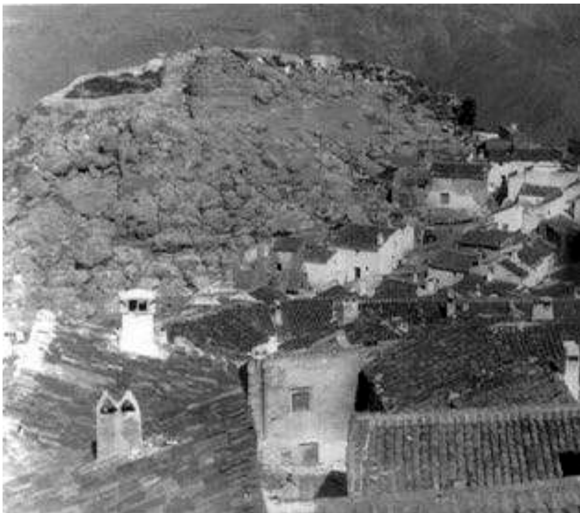
Figura 437: Entorno de la Tahona en 1935. Fuente: BCC – Colección: Legado Temboury. Archivo Fotográfico – Signatura: 1092A.
