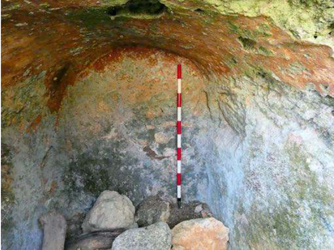
Figura 155: Interior del primer espacio embovedado. Fuente: elaboración propia.
