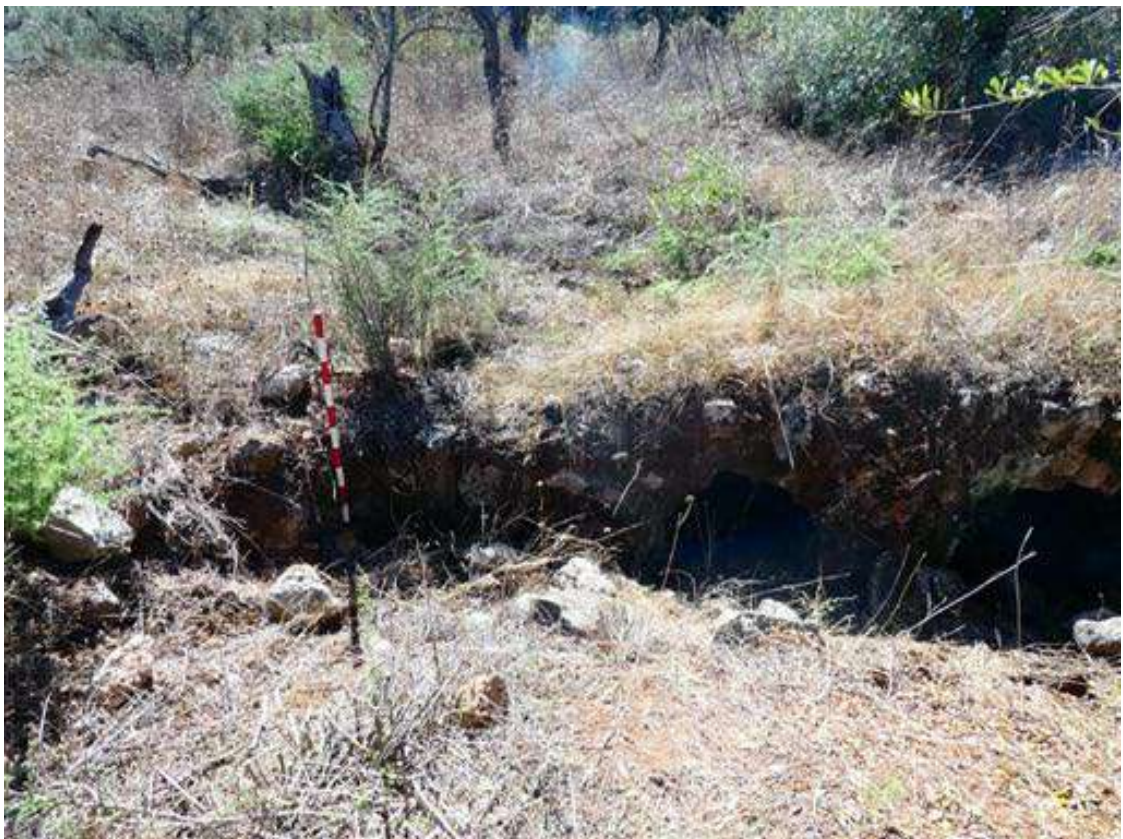
Figura 154: Doble espacio abovedado junto a la alberca e hipotético tercer espacio embovedado a la izquierda. Fuente: elaboración propia.
