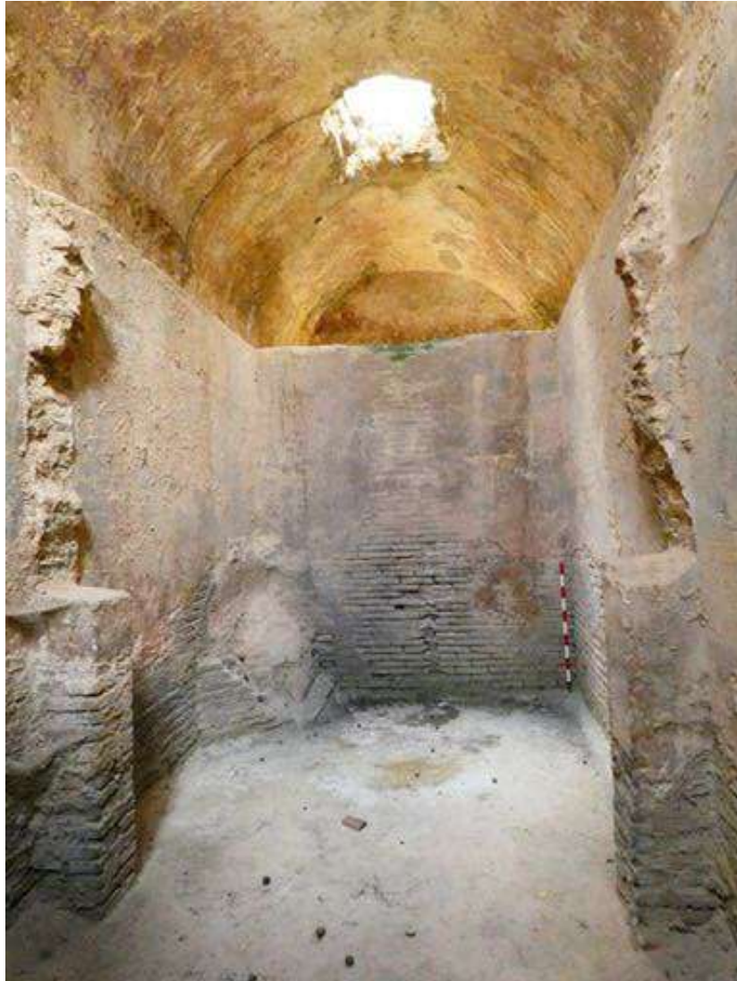
Figura 460: Interior del aljibe. Fuente: elaboración propia.
