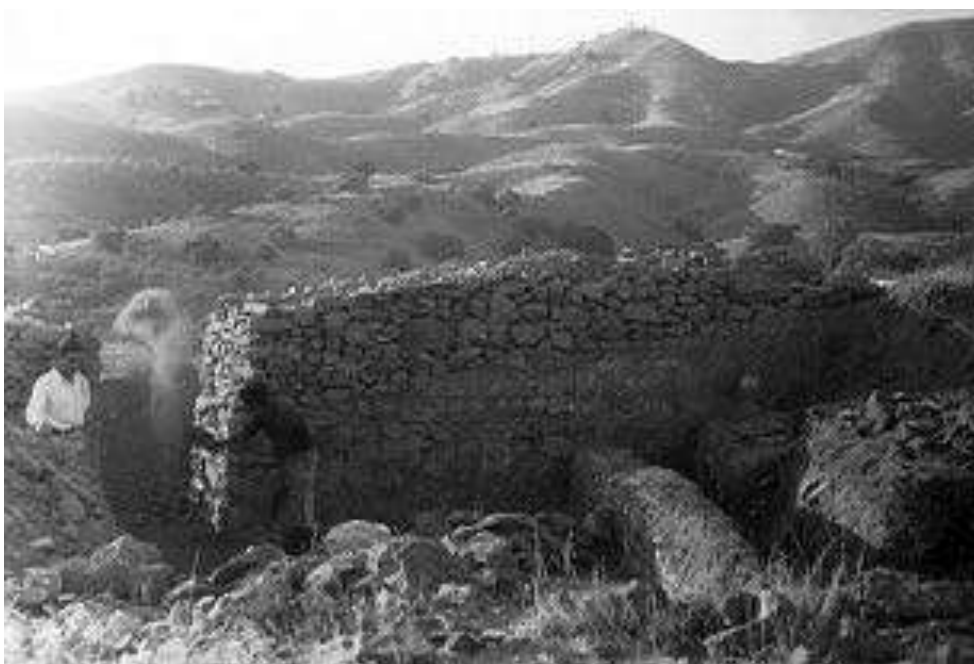
Figura 246: Excavaciones en el castillo de Bizilyāna en 1954. Fuente: BCC – Colección: Legado Temboursy. Archivo fotográfico – Signatura: 5117C.
