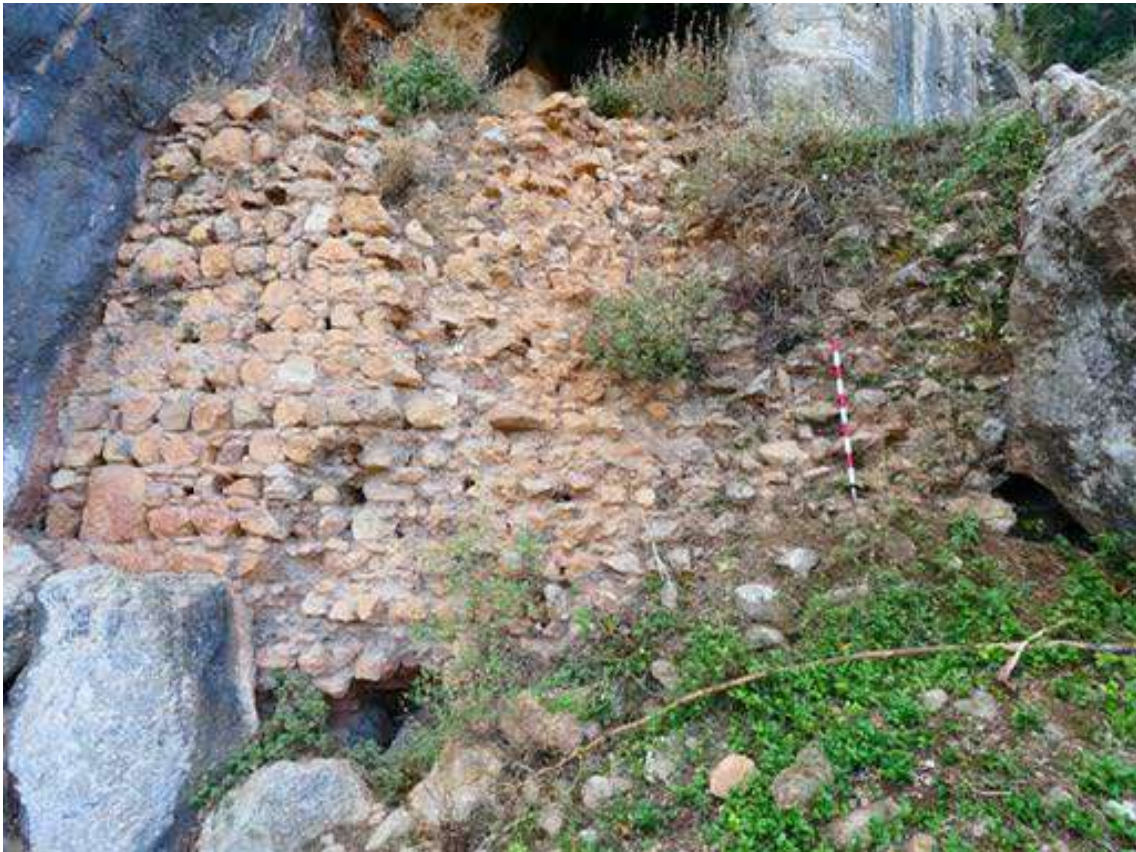
Figura 485: Sección este del muro de la Coracha. Fuente: elaboración propia.
