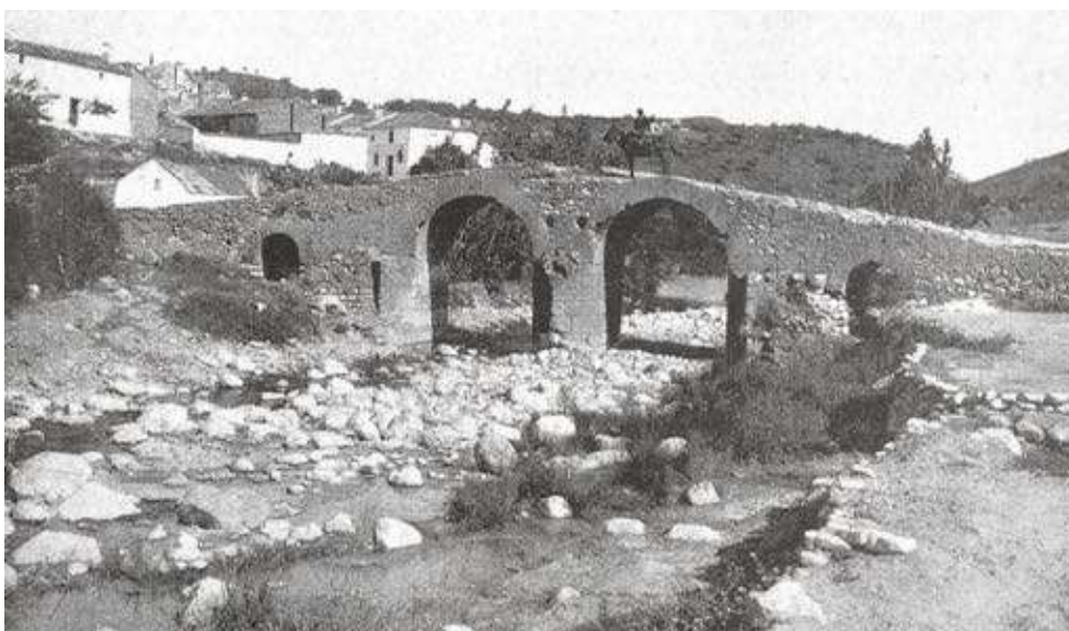
Figura 569: Puente sobre Riogordo. Fuente: BCC – Colección: Legado Temboury. Archivo Fotográfico – Signatura: 5125.
