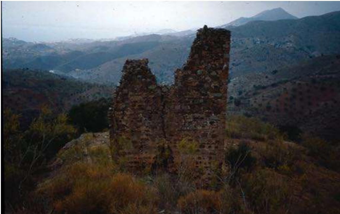
Figura 810: Cara norte de la torre de Salazar antes de la restauración. Fuente: ADPM, signatura: DP-8-1.
