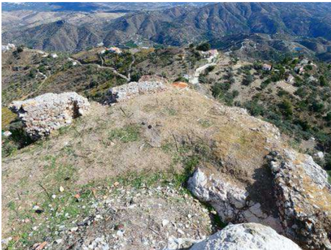
Figura 467: Vista de los lienzos 2 y 3. Fuente: elaboración propia.
