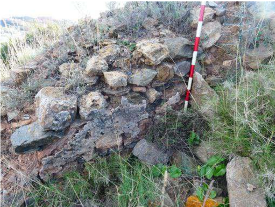
Figura 309: Decoración en torre 8. Fuente: elaboración propia.
