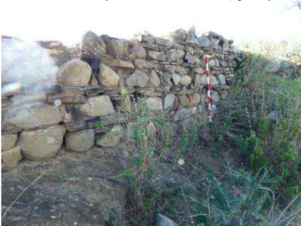
Figura 829: Lienzo situado en el extremo oriental de la torre. Fuente: elaboración propia.
