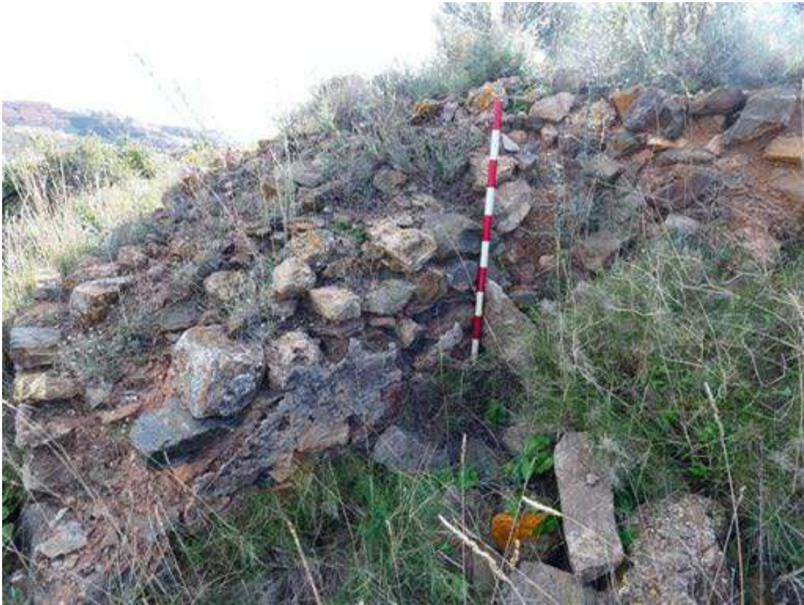
Figura 295: Torre 8 junto al lienzo 12. Fuente: elaboración propia.
