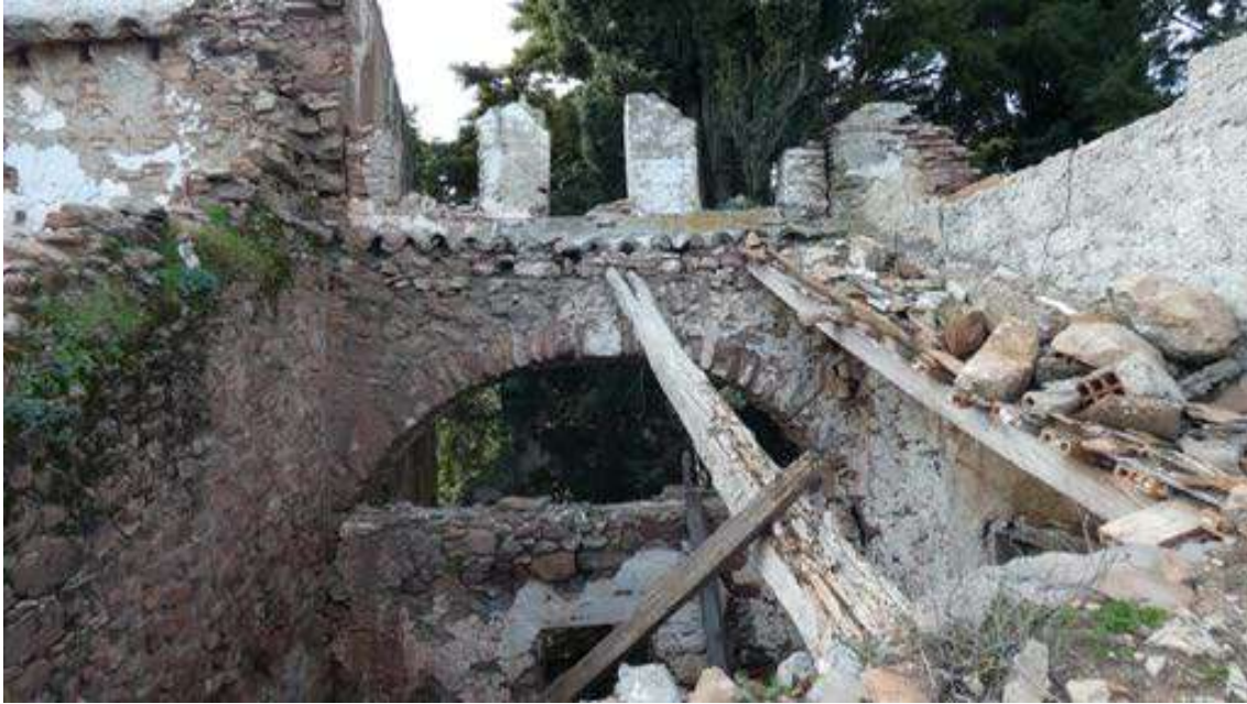
Figura 96: Arco del lagar de Santo Pitar. Fuente: elaboración propia.
