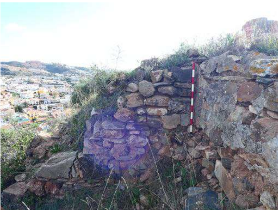
Figura 294: Torre 7 junto al lienzo 11. Fuente: elaboración propia.
