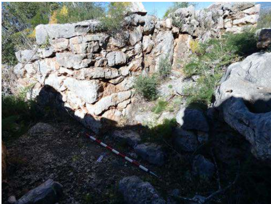
Figura 175: Esquina relativa al muro de mayor anchura. Fuente: elaboración propia.
