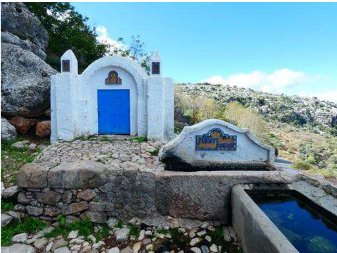
Figura 489: Fuente Gorda, pilar y aljibe. Fuente: elaboración propia.
