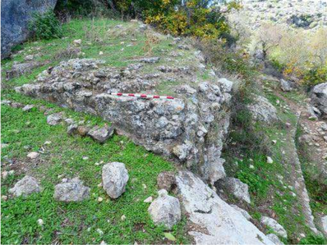
Figura 488: Estructura relacionada con la Coracha, posiblemente un aljibe. Fuente: elaboración propia.
