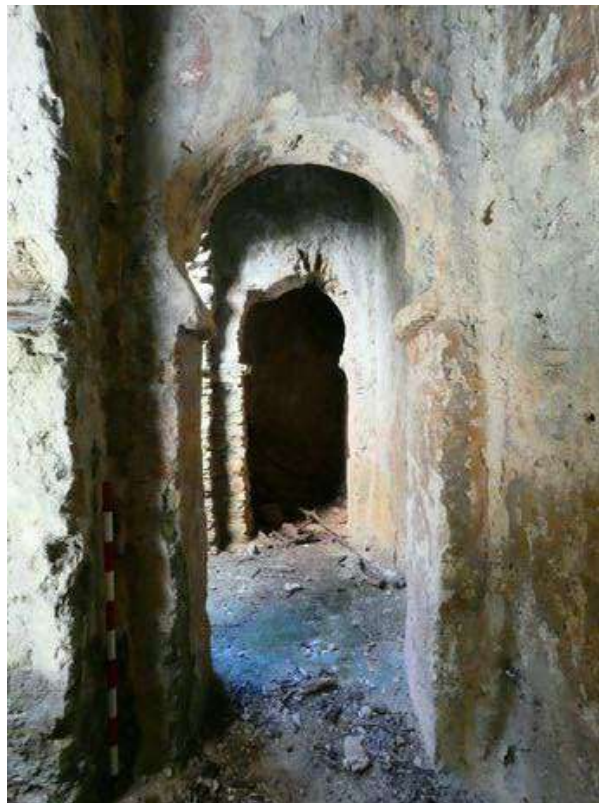
Figura 145: Arco de herradura que divide los compartimentos I y IV y al fondo otro arco de herradura que divide los compartimentos IV y VII. Fuente: elaboración propia.
