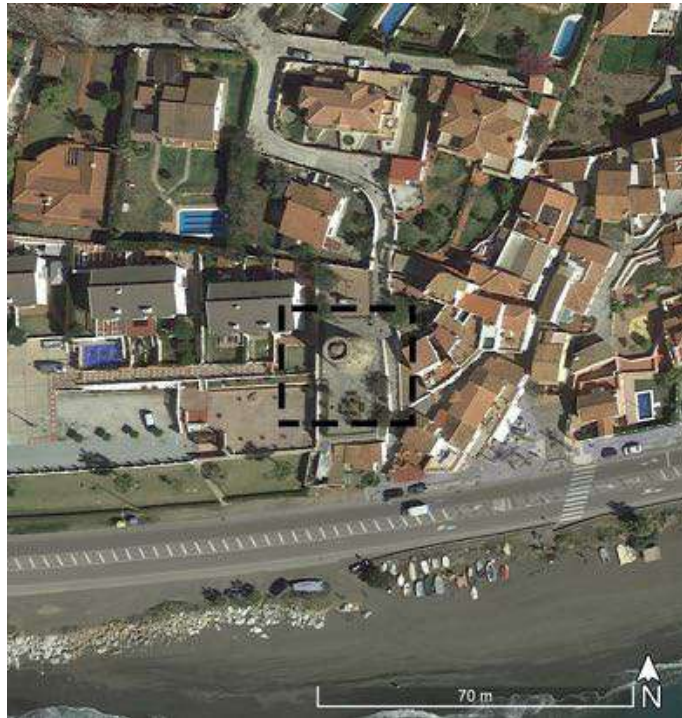
Figura 792: Vista cenital de la atalaya moderna de Chilches. Fuente: elaboración propia.
