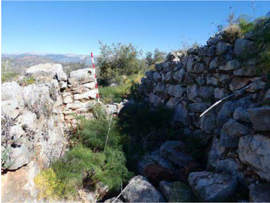
Figura 170: Vista del acceso noreste de la vivienda y de la primera sala trapezoidal. Fuente: elaboración propia.
