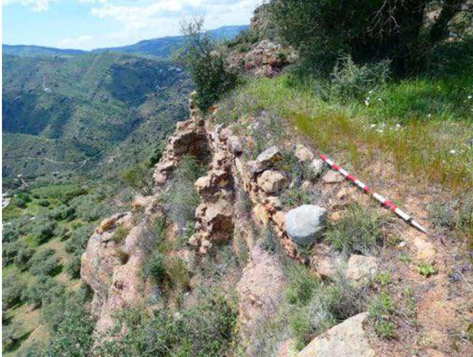
Figura 58: Vista del muro sur con los dos contrafuertes. Fuente: elaboración propia.
