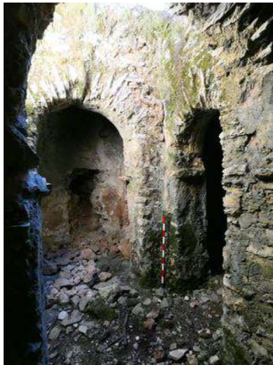
Figura 147: Ejemplo de pilar cruciforme. Se presencia los compartimentos V, VI y VIII. Fuente: elaboración propia.
