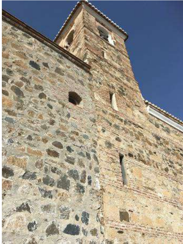
Figura 625: Torre campanario de la iglesia de Benaque. Fuente: elaboración propia.
