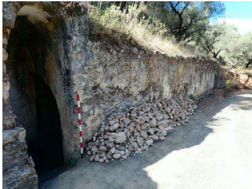
Figura 505: Entrada y muro del aljibe de la fuente Delgada. Fuente: elaboración propia.
