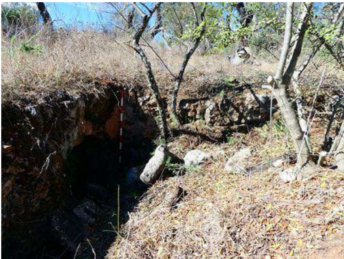
Figura 152: Vista del muro Norte de la alberca. Fuente: elaboración propia.
