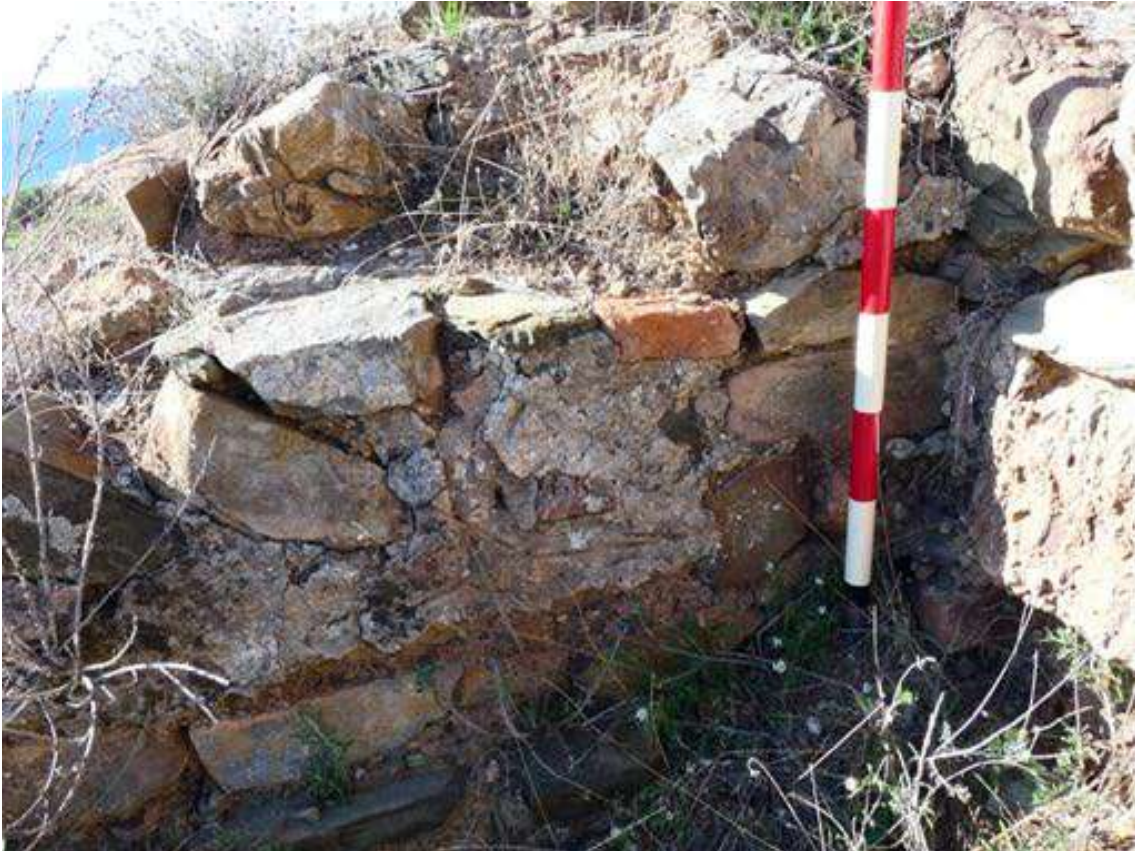
Figura 308: Decoración en torre 5. Fuente: elaboración propia.
