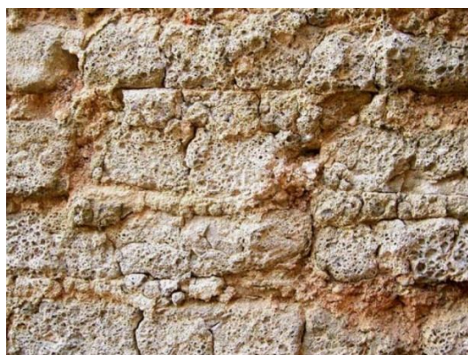
Fig. 5.92. Detalle de las paredes del horno 2 de calle Parras nº2-8 (Llamas, 2005).
