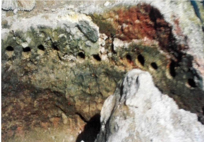
Fig. 5.35. Detalle de los agujeros para las barras del Horno 2 de calle Parras, esquina calle Alta (Pérez Narváez, 2010).
