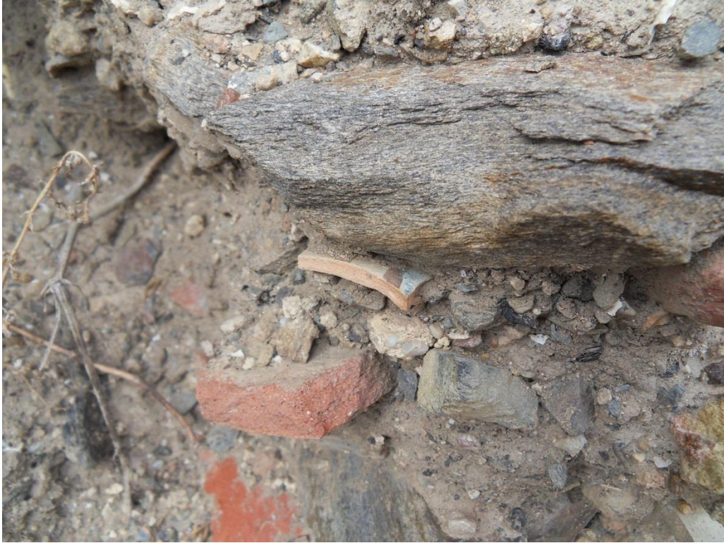
Fig. 6.34. Inclusiones cerámicas del siglo XIII en el tapial de la muralla situada al suroeste de la torre principal.
