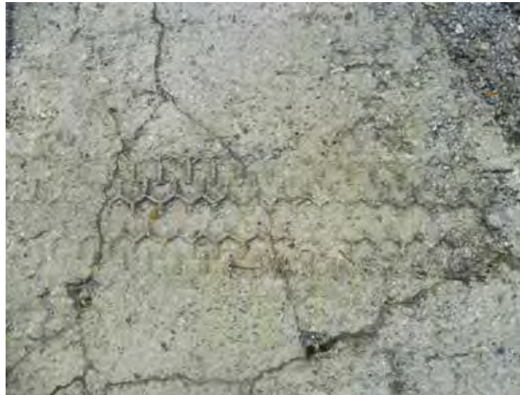
Fig. 122. Autora (2019) Trayecto. Caminata hacia el gimnasio. Entorno y detalle. Fotoensayo compuesto por, arriba, Autora (2019) Salida estrecha , fotografía; abajo, Autora (2019) Pavimento texturado , fotografía; y derecha, Autora (2019) Estampa II . Estampa, 10 x 10 cm.
