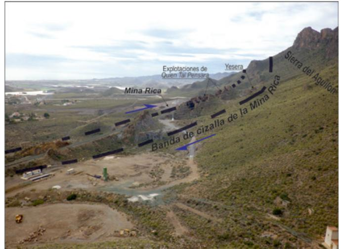
**Figura 13.** Alineación de afloramientos carbonatados de rumbo general NE-SW en la ladera oriental de la Sierra del Aguilón, que va marcando la banda de cizallamiento dextral en la que se encuentra el yacimiento. Vista hacia el Sur
