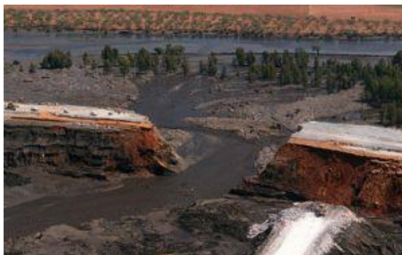
Figura 1. Zona de rotura de la balsa minera de Alnalcóllar ( https://elpais.com/ccaa/2012/05/22/andalucia/1337692996_148522.html )
