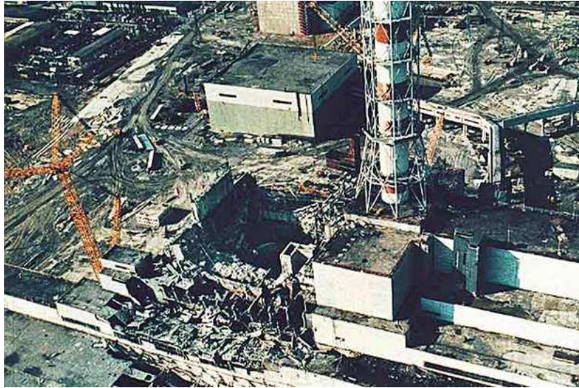
Figura 3. Fotografía de la central nuclear de Chernóbil tras el accidente en abril de 1986 ( https://www.ebrd.com/ebrds-mission-in-chernobyl-gallery.html ).
