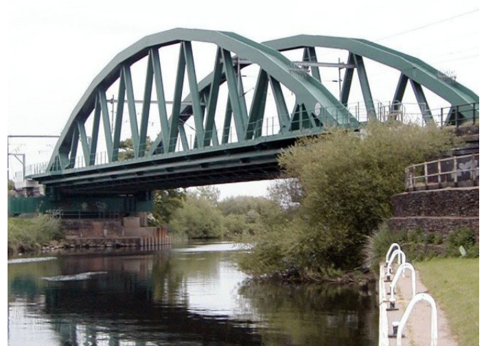
Figura 79: Puente de Newark Dyke, Cass Hayward, Reino Unido, 1890
