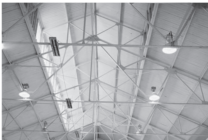
Figura 63: Fábrica en Milltown, Missoula (Metálica)
