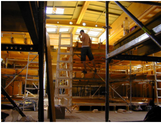
Figura 137: planos del barco Kassa, EASA Site. Figura 138 :Exterior e interior del barco durante el montaje de la estructura de literas de andamios para dormir.
