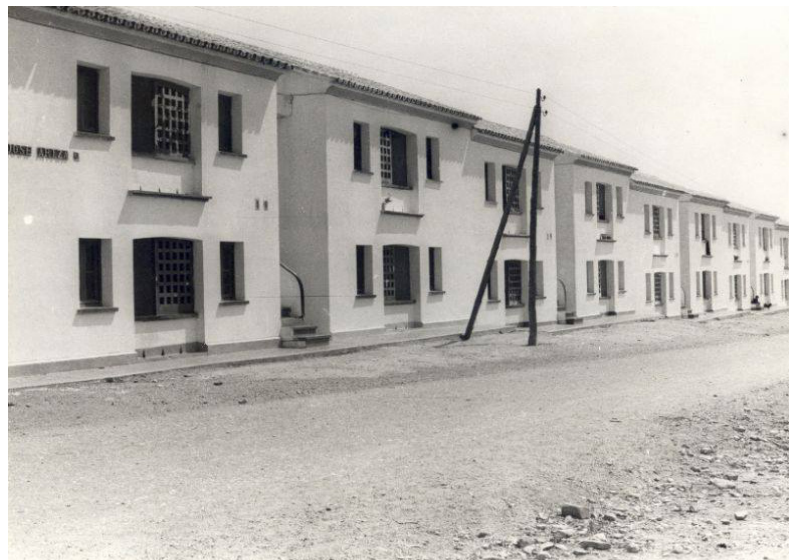
Figura 9: Construcción viviendas en la barriada “Las protegidas” en Torrox (Málaga) 1965. (Fuente: Ayuntamiento de Torrox)
