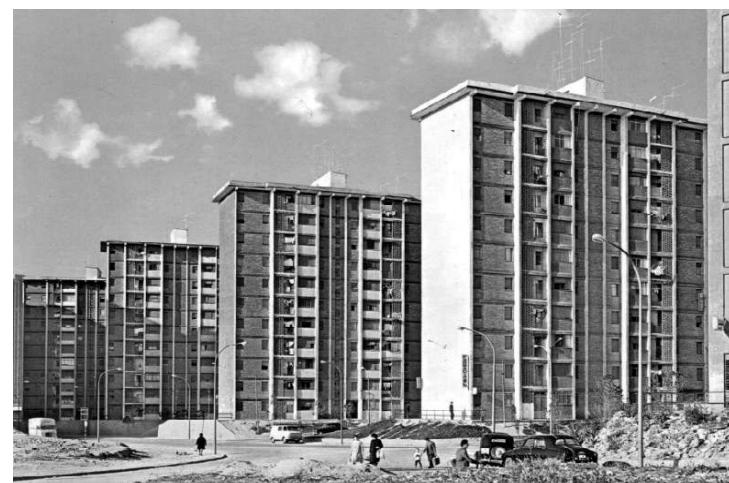
Figura 7: Grupo de viviendas en construcción en Madrid años 60. (Fuente: www.alamys.es )
