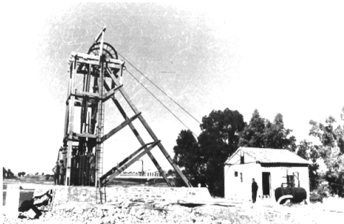
Cabria metálica y casa de extracción del pozo Dorda Colectivo Proyecto Arrayanes
