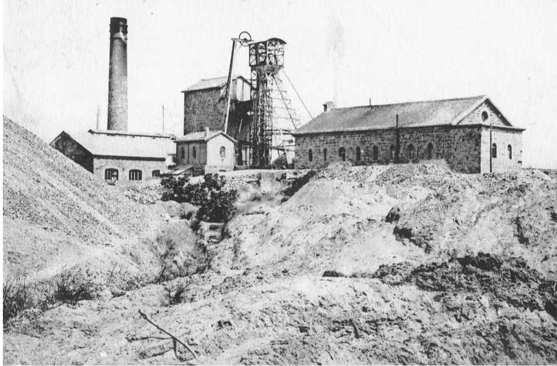
Arquitecturas de extracción del pozo San José Colectivo Proyecto Arrayanes
