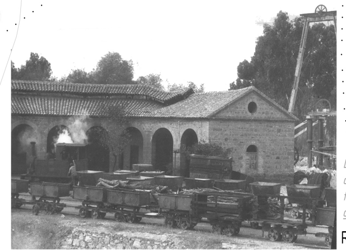
La mina de Restauración contaba con almacenes, talleres, depósitos de agua y gajales para las vías férreas. Restauración
