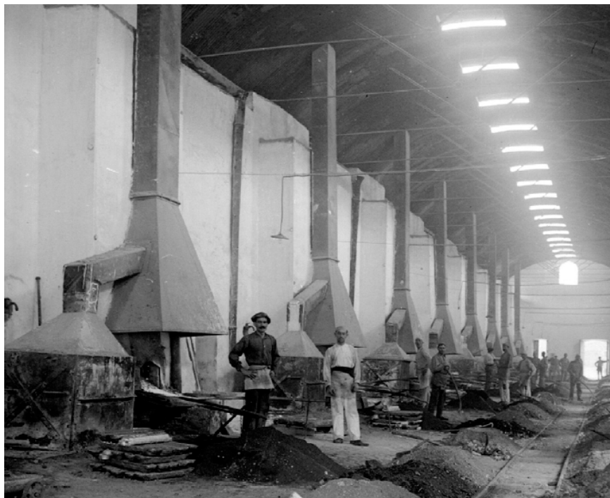
Vista general de los hornos de la Fundición La minería y la metalurgia en el Alto Guadalquivir
