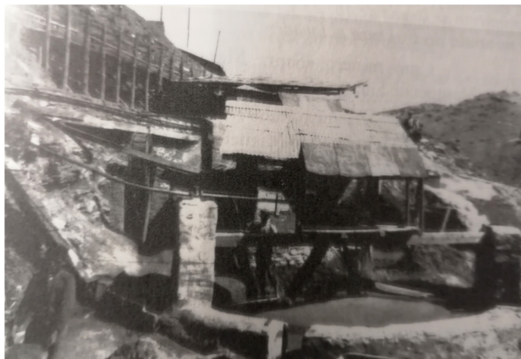
Round buddle de un lavadero junto a la tubería de suministro de agua, principios del siglo XX Lavaderos en minas y terreros de Linares-La Carolina
