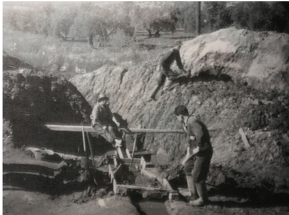
Trabajadores echando tierras al royo inglés, principios del siglo XX Lavaderos en minas y terreros de Linares-La Carolina
