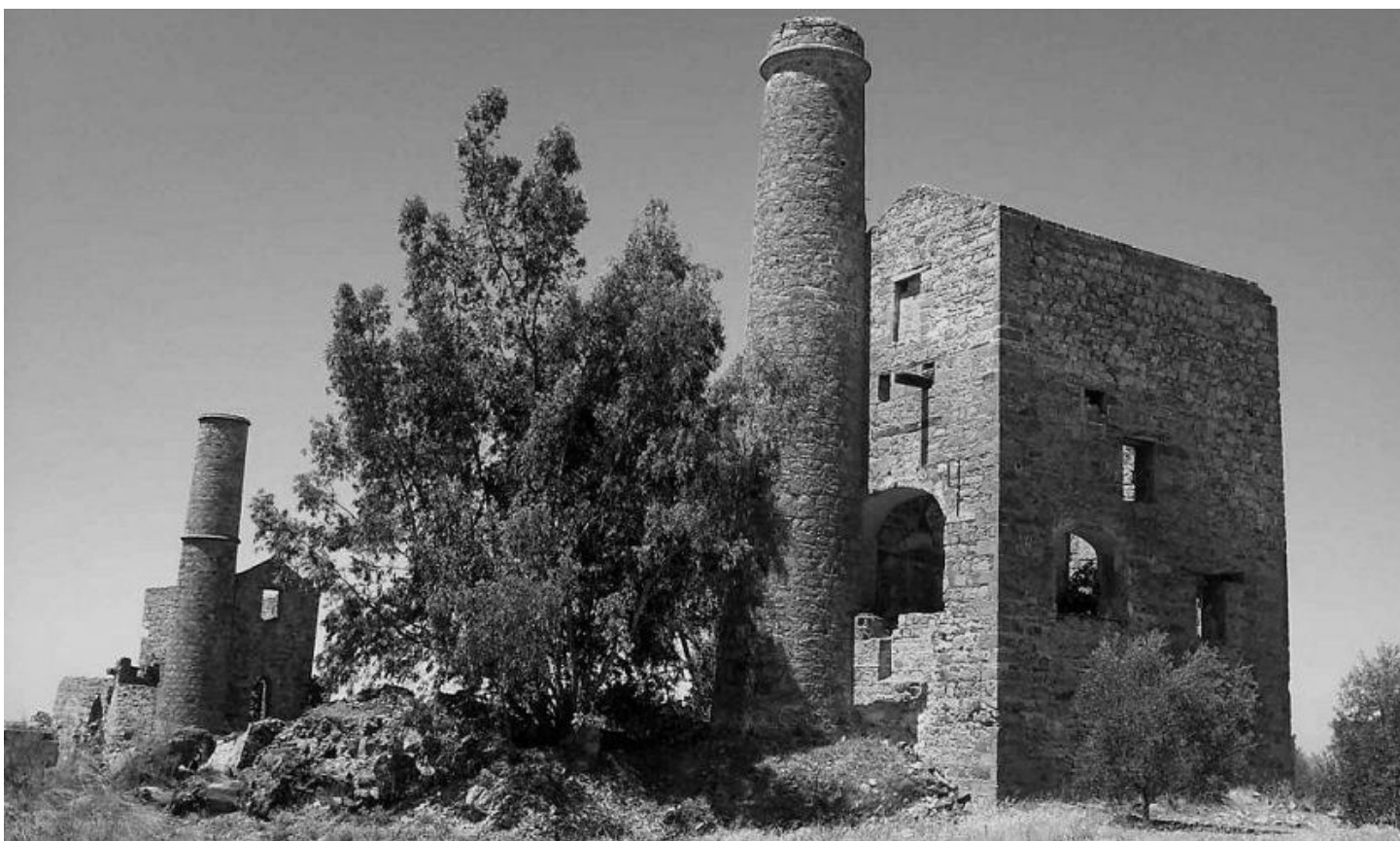
Casa Cornish de Santo Tomás junto a un eucalipto Colectivo Proyecto Arrayanes
