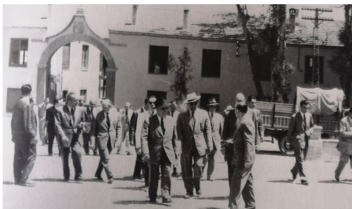
Entrada principal al recinto de la Fundación de la Cruz, 1954 Lavaderos en minas y terreros de Linares- La Carolina
