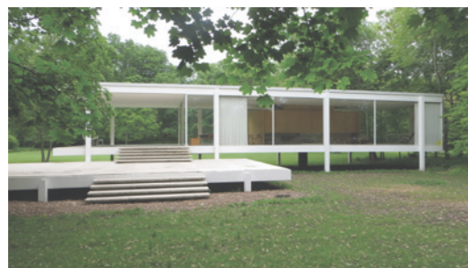
2. Casa Farnsworth, Mies Van der Rohe Fuente: americanrepective.es
