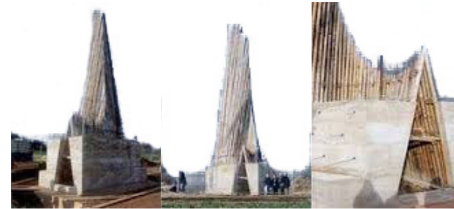
FASES DE ENCOFRADO
