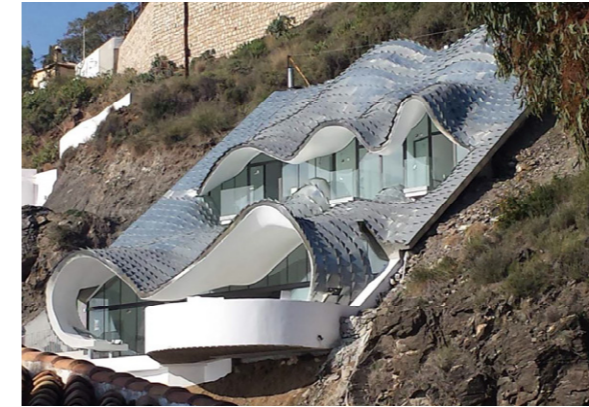
Cubierta de Vivienda Unifamiliar. Granada, España (2012). Gil-Bartolomé.
