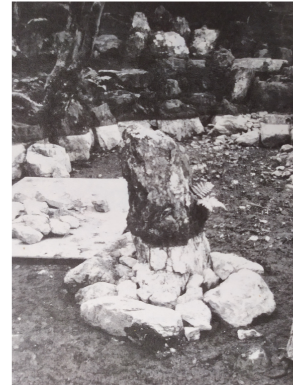
Fig. 6. Roca con cimientos en lago sin agua, templo Tenryu-ji en construcción.
