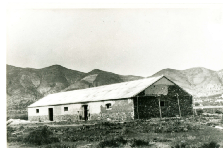
fig. 67. Construcción del primer almacén "Los Vázquez", 1953.
