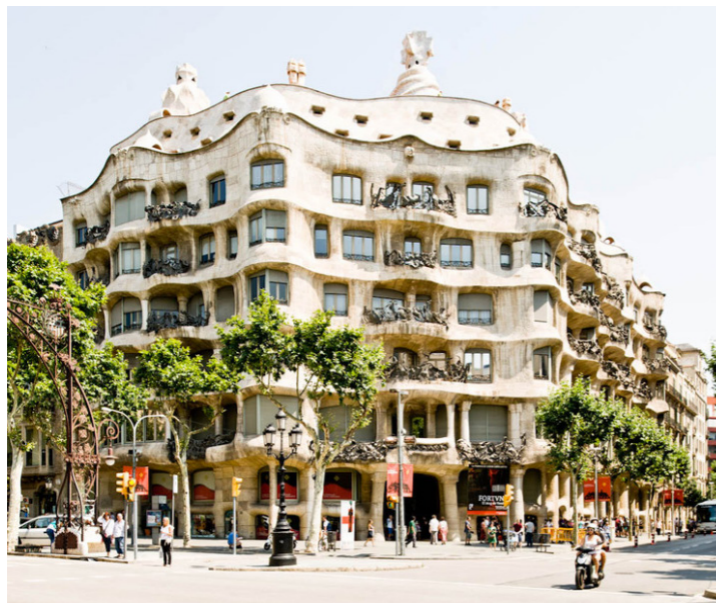
[32] Fachada de la Casa Milá
