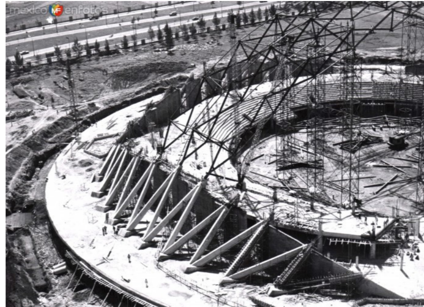
[43] Palacio de los Deportes durante su construcción
