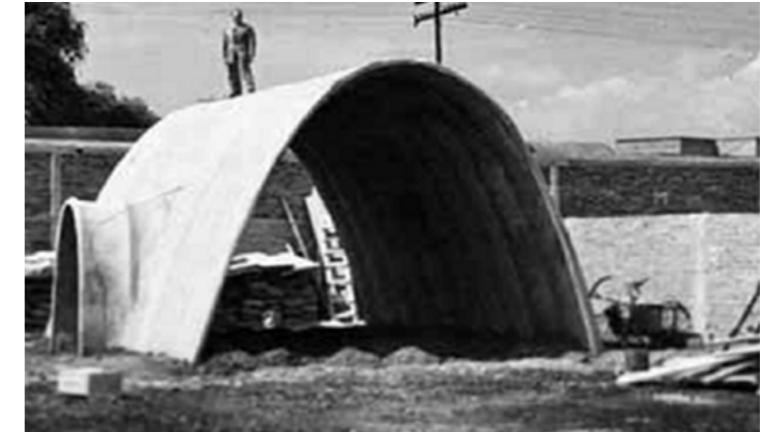
[35] Bóveda antifunicular experimental tipo ctesiphon (1949)
