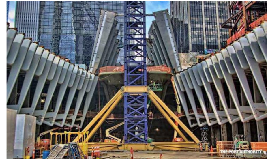
[52] Oculus durante su construcción
