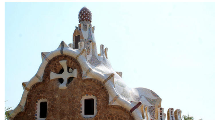
[29] Cubierta del pabellón de entrada del Parc Güell.
