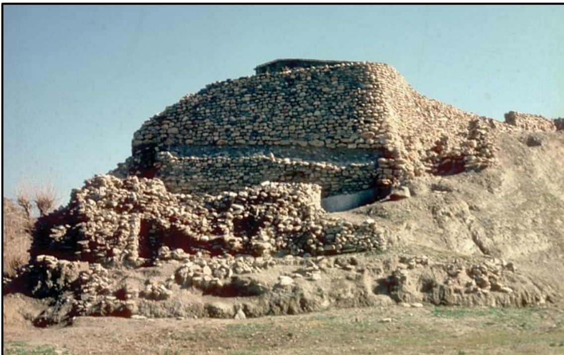
Figura 2.14. Recinto amurallado del poblado del Cerro de la Encina (Monachil). Imagen tomada de Aranda et al. (2009).
