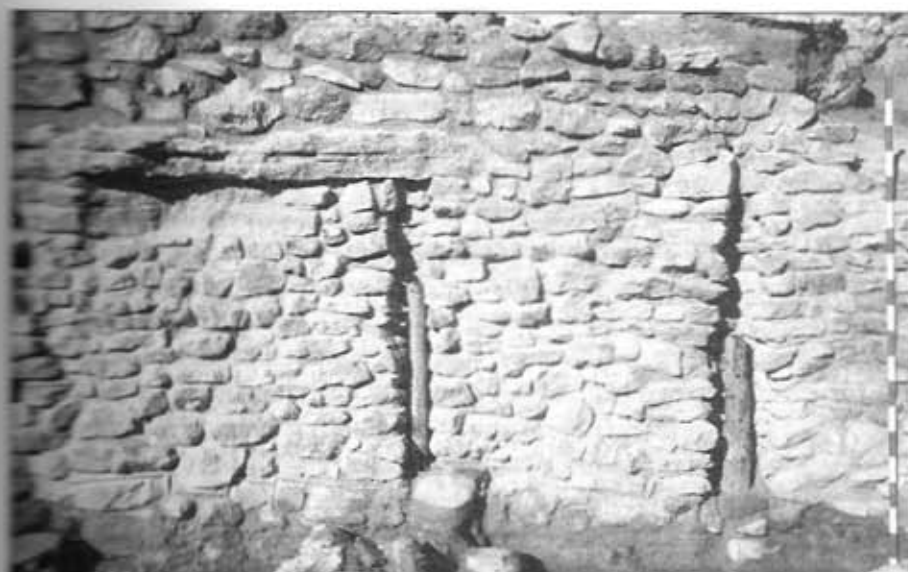
FIGURA 1. Revestimiento de una terraza mediante muro de mampostería reforzado con postes en El Castellón Alto (Galera, Granada).
