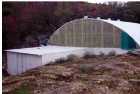
Estructura de protección de la estratigrafía de los Castillejos.
