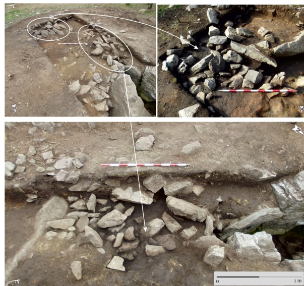
Figura 13: a) Vista general de las dos zonas ocluidas con piedras. b) Tramo sellado en el supuesto Tramo II. c) Tramo sellado en el corredor de piedra, o Tramo I
