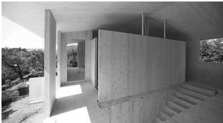
Figura 3.9 - Construcción de vivienda con estructura de paneles de madera contralaminada KLH.
