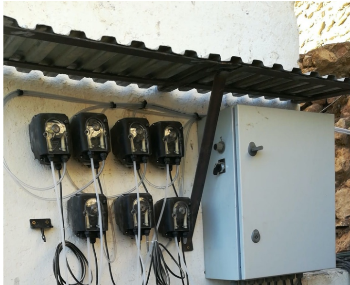
Figura 32: Bombas peristálticas para regular el flujo de reactivos
