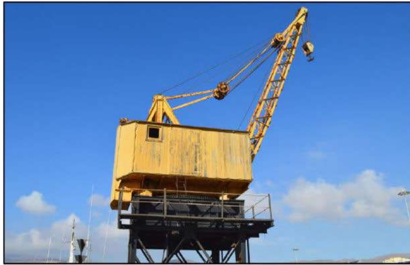
Ilustración 48. Grúa Babcock & Wilcox del puerto de Almería. Autoría propia.
