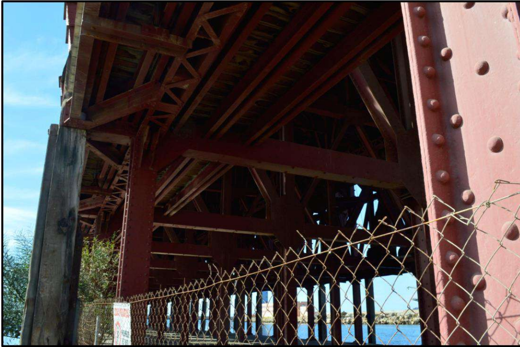
Ilustración 119. Detalle del interior del Cable Inglés. Autoría propia.
