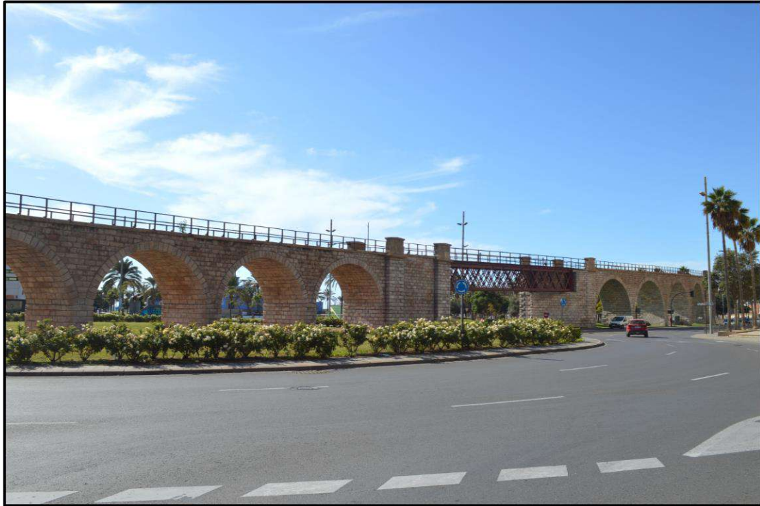
Ilustración 113. Arcadas de fábrica del primer tramo del Cable Inglés.
