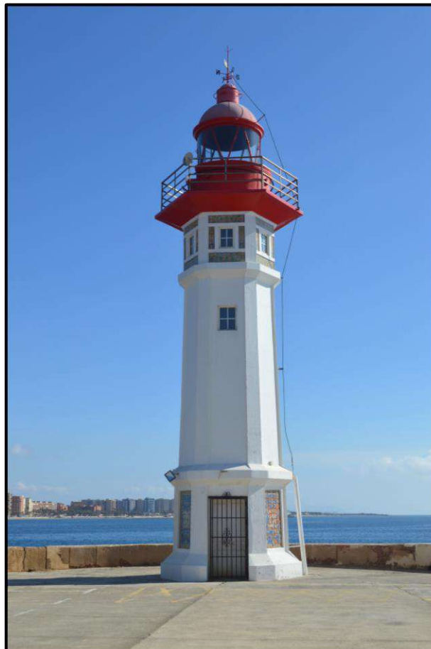
Ilustración 61. Faro del Muelle de Poniente. Autoría propia.
