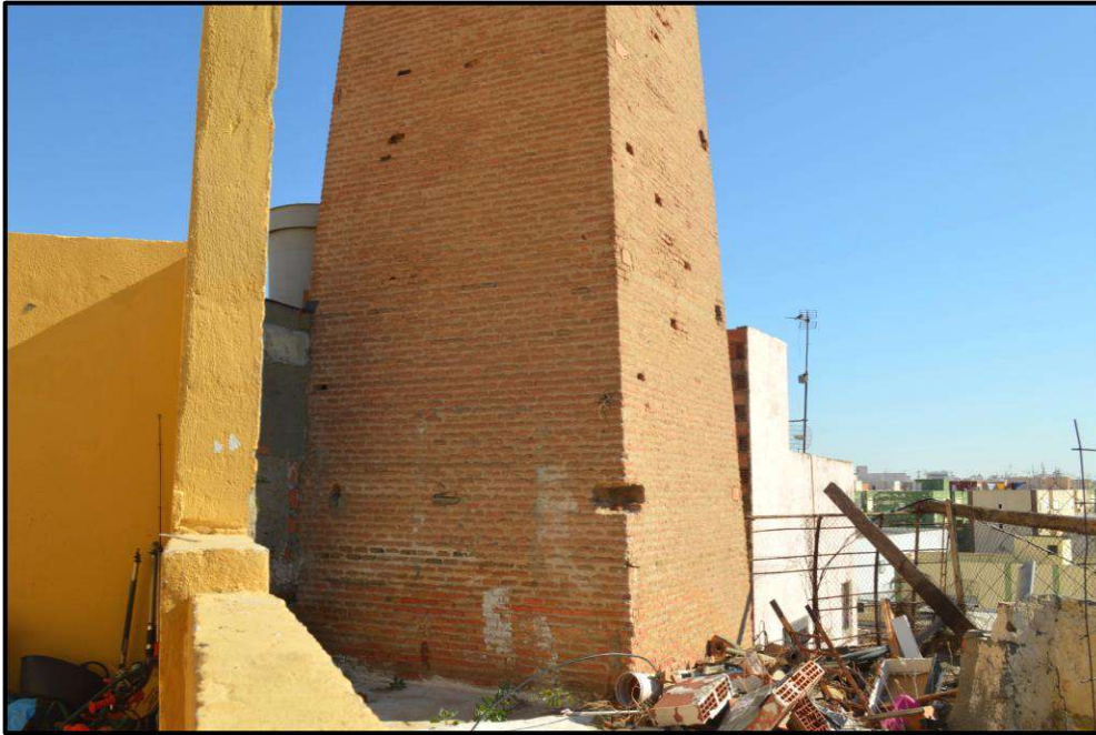
Ilustración 131. Base de la chimenea de la Fundación Santo Tomás, ubicada en el patio de una vivienda. Autoría propia.
