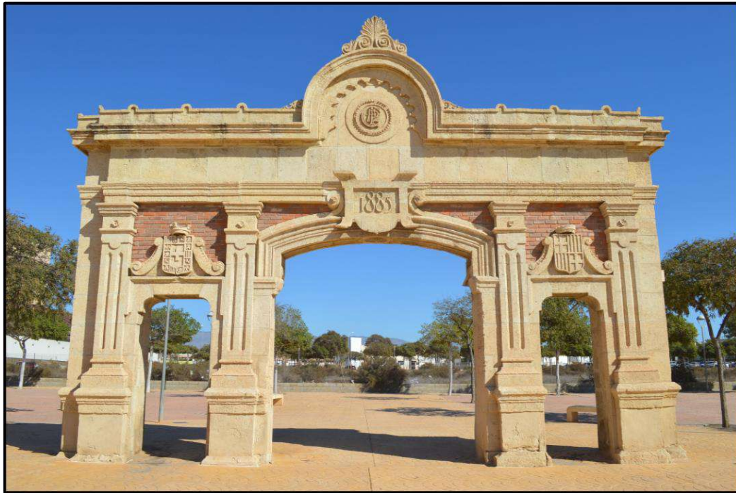
Ilustración 75. Estado actual de la portada del Ingenio de Nuestra Señora de Monserrat. Autoría propia.
