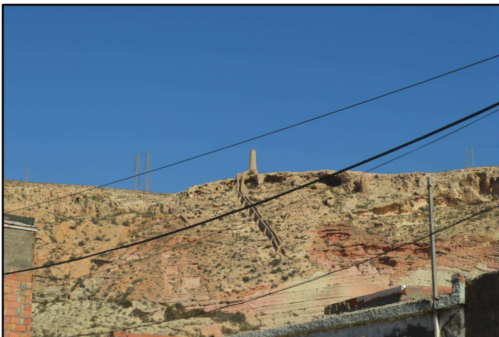
Ilustración 134. Restos de la galería de condensación de humos y chimenea de la Fundición Santo Tomás, ubicada en las estribaciones de la Sierra de Gádor. Autoría propia.
