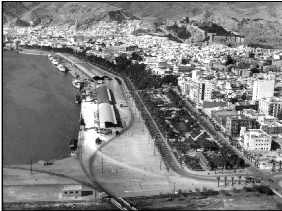
Ilustración 188. Vías férreas portuarias hacia 1965 pocos años antes de caer en desuso. En la parte inferior de la foto se aprecia el puente sobre la Rambla. Fuente: Biblioteca Digital de la Diputación de Almería [En línea]. Recuperado el 11 de noviembre de 2020, de https://app.dipalme.org/pandora/?view=global
