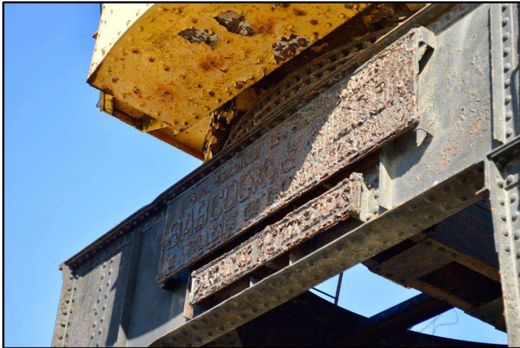
Ilustración 204. Placas traseras de la grúa en las que se lee: "SOC. ESPAÑOLA DE CONSTRUCCIONES BABCOCK & WILCOX. TALLERES EN GALINDO, VIZCAYA. CARGA MÁX. 25 TONELADAS". Autoría propia.
