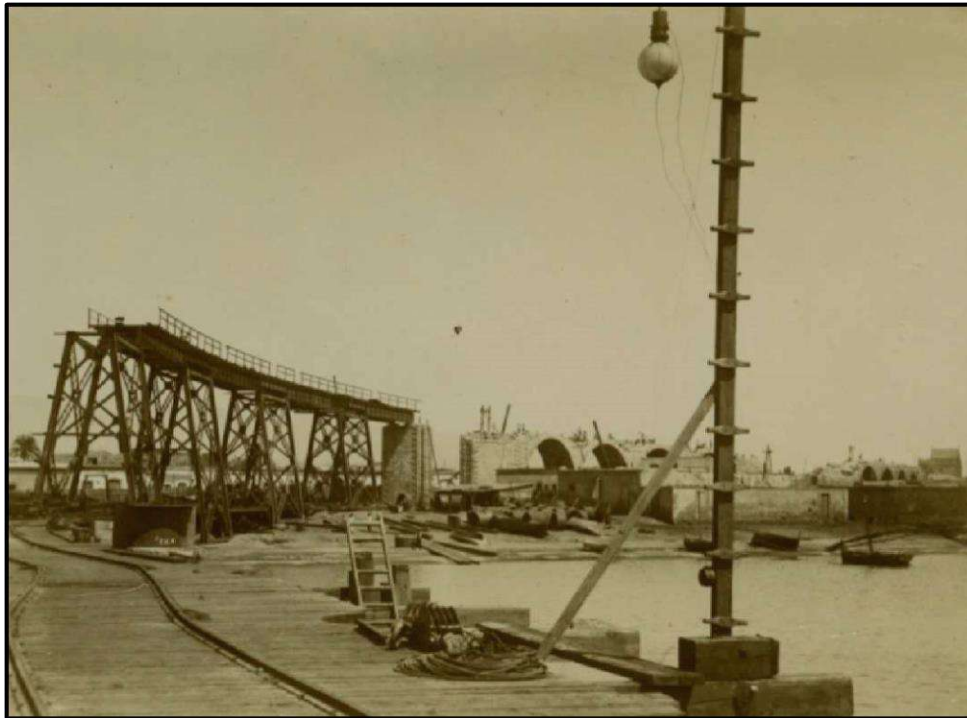
Ilustración 101. Construcción del Cable Inglés hacia 1903. Fuente: Biblioteca Digital de la Diputación de Almería [En línea]. Recuperado el 10 de noviembre de 2020, de https://app.dipalme.org/pandora/?view=global
