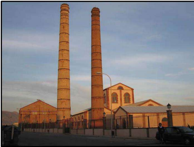
Ilustración 19. Azucarera Libre de Adra. Fuente: Revista Electrónica de Patrimonio Histórico [En línea]. Recuperado el 24 de septiembre de 2020, de
