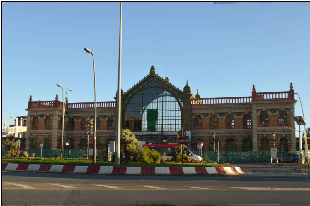
Ilustración 92. Estado actual de la Estación de Ferrocarril. Autoría propia.
