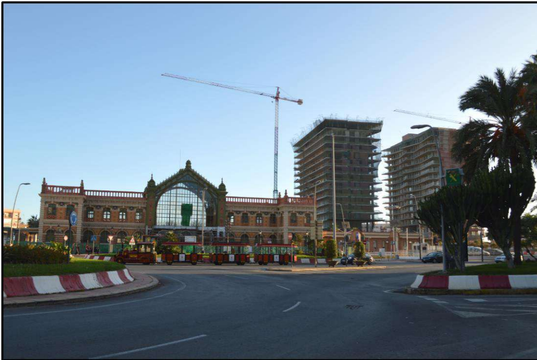
Ilustración 91. Estado actual de la Estación de Ferrocarril. Obsérvense los descomunales edificios de viviendas en construcción justo detrás, en el solar que ocupaba antiguamente el Toblerone. Autoría propia.
