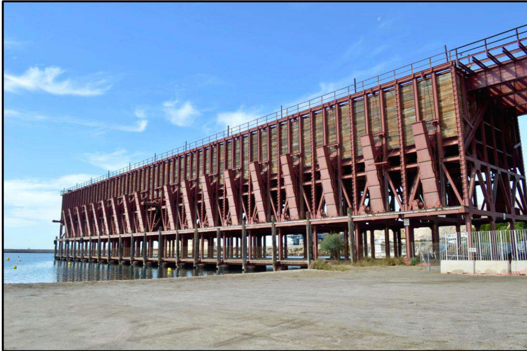
Ilustración 117. Estado actual de la tercera sección del Cable Inglés. Autoría propia.
