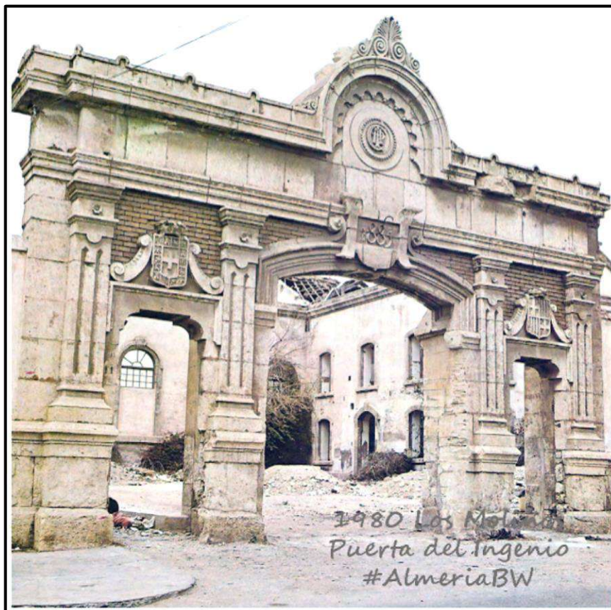
Ilustración 74. Restos de la portada del Ingenio de Nuestra Señora de Monserrat hacia 1980. Fuente: Blog Almería Antigua [En línea]. Recuperado el 7 de noviembre de 2020, de https://almeriaantigua.blogspot.com/2019/04/1980-el-ingenio-de-monserrat-edificio.html
