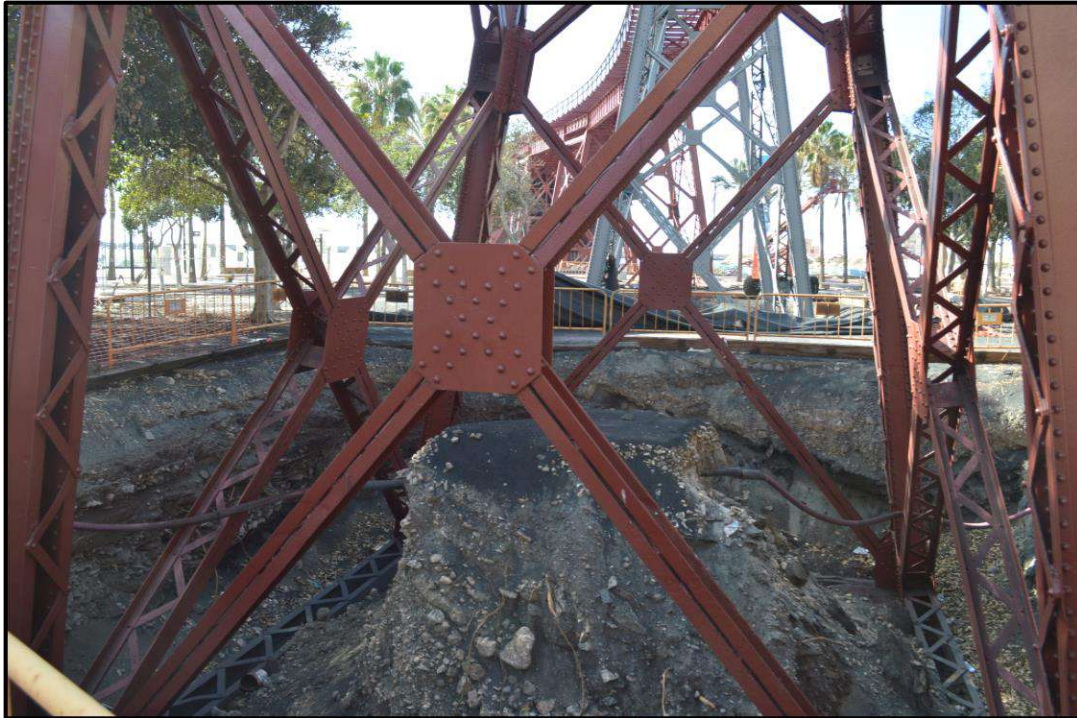
Ilustración 115. Estado actual de las actuaciones de conservación en la cimentación del Cable Inglés. Autoría propia.
