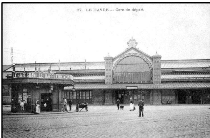
Ilustración 23. Portada del Edificio de salida de viajeros, Estación de Le Havre. Fuente: Wikimedia Commons [En línea]. Recuperado el 16 de septiembre de 2020, de https://commons.wikimedia.org/wiki/File:Gare-Lisch-d%C3%A9part-Le-Havre-1900.jpg
