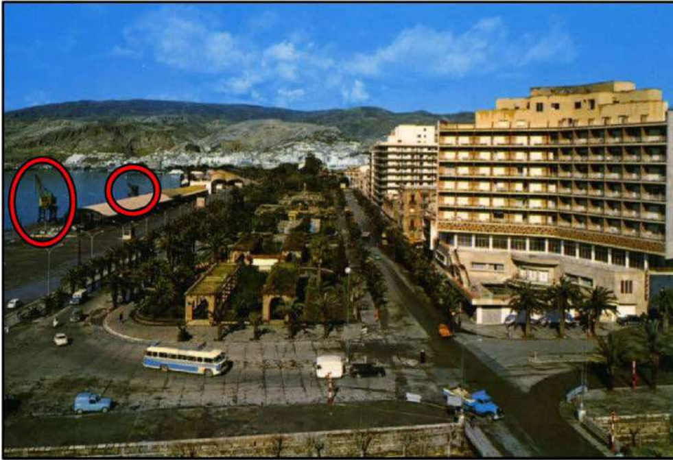
Ilustración 198. Grúas del puerto en el andén de costa hacia 1960. La grúa de la SECWB se ubicó originalmente allí. Fuente: Biblioteca Digital de la Diputación de Almería [En línea]. Recuperado el 11 de noviembre de 2020, de https://app.dipalme.org/pandora/?view=global
