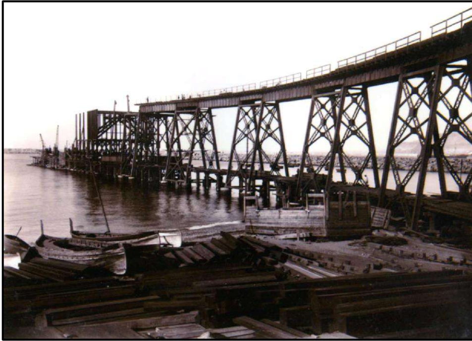
Ilustración 103. Construcción del Cable Inglés hacia 1903. Fuente: Biblioteca Digital de la Diputación de Almería [En línea]. Recuperado el 10 de noviembre de 2020, de https://app.dipalme.org/pandora/?view=global
