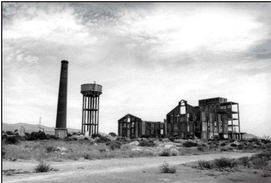
Ilustración 71. Vista de las instalaciones ruinosas del Ingenio de Nuestra Señora de Monserrat, fecha desconocida. Fuente: Javier Morcillo Padilla [En línea]. Recuperado el 7 de noviembre de 2020, de https://www.morx.net/photo-album/#http%3A%2F%2Fwww.morx.net%2Fwp-content%2Fuploads%2FImagen.jpg
