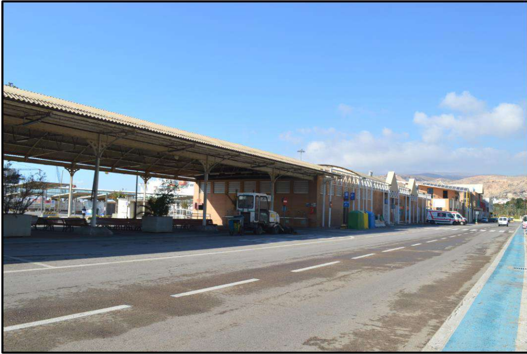
Ilustración 62. Andén de costa y estación marítima. Autoría propia.
