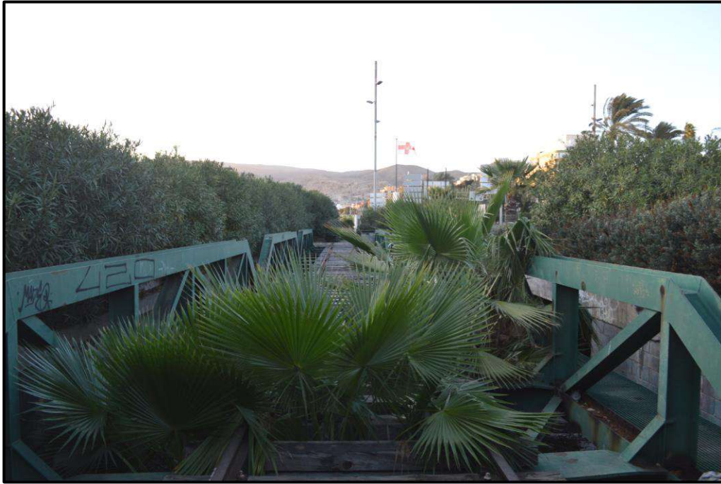
Ilustración 190. Estado actual del puente de las vías férreas del Puerto sobre la rambla. Autoría propia.
