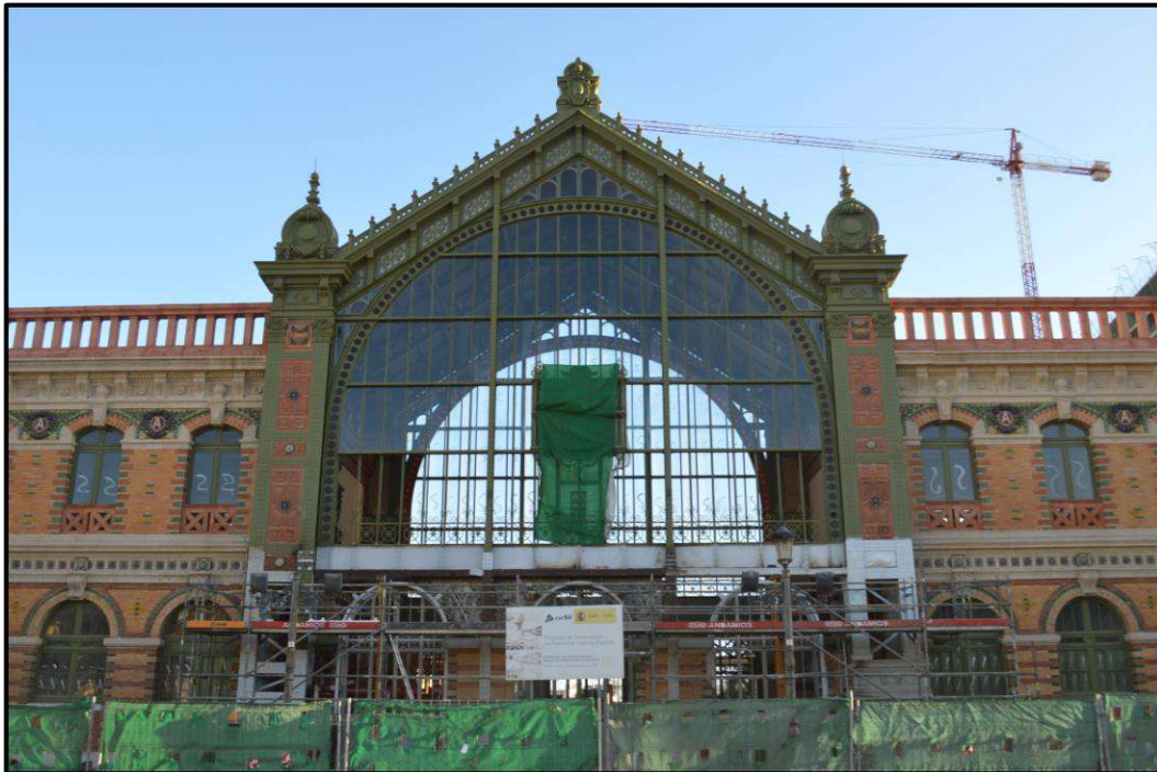
Ilustración 93. Estado actual de la Estación de Ferrocarril. Autoría propia.
