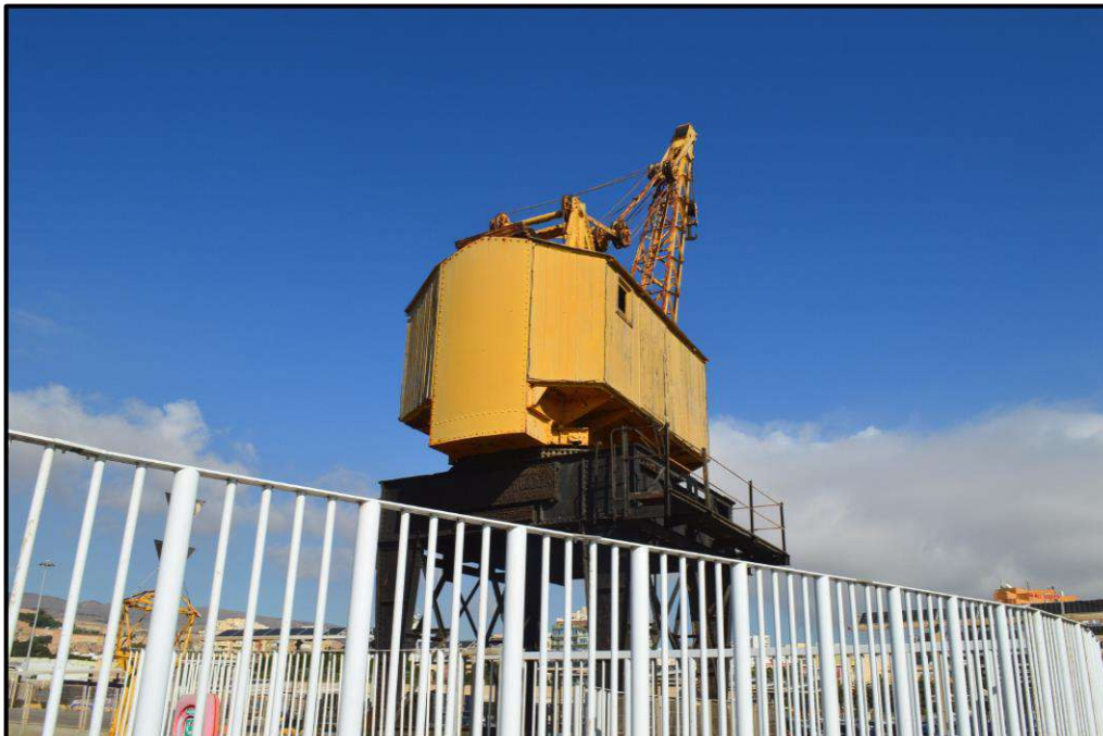
Ilustración 203. Parte trasera de la grúa de la SECBW. Autoría propia.
