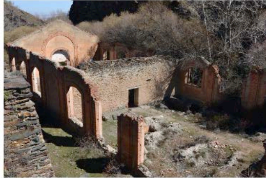
ILUSTRACIÓN 9. CASA DE MÁQUINAS, FOTOGRAFÍA DEL AUTOR
