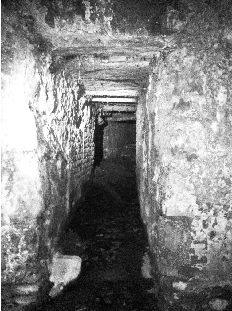
Vestigio de la acequia que daba riego al antiguo convento junto a Plaza Bibrambla. (Fuente: Fotografía de Antonio García Bueno, Granada, 2014)
