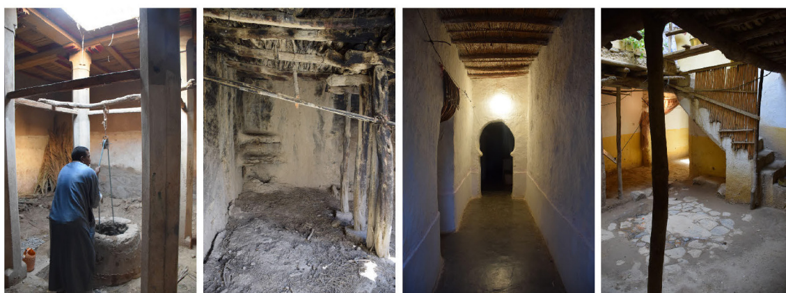
Figura 5: Figura 5.1: Casa de Ouled Yahia, Erfoud, Marruecos; Figura 5.2: Casa de Ghazouane, Alto Atlas, Marruecos; Figura 5.3: Casa de Zaouit, Marruecos; Figura 5.4: Casa de Mediouna, Medio Atlas, Marruecos Fuente: R. Costa y D. Batista (2018)
