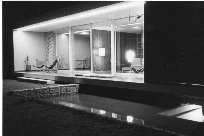
Figure 3: Pinto da Cunha House (1965), Luanda; J. Pinto da Cunha Source: Private Colection
