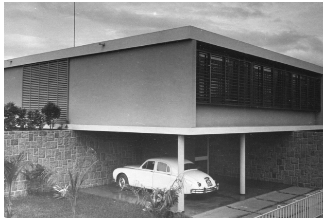
Figure 4: Pinto da Cunha House (1965), Luanda; J. Pinto da Cunha Source: Private Colection
