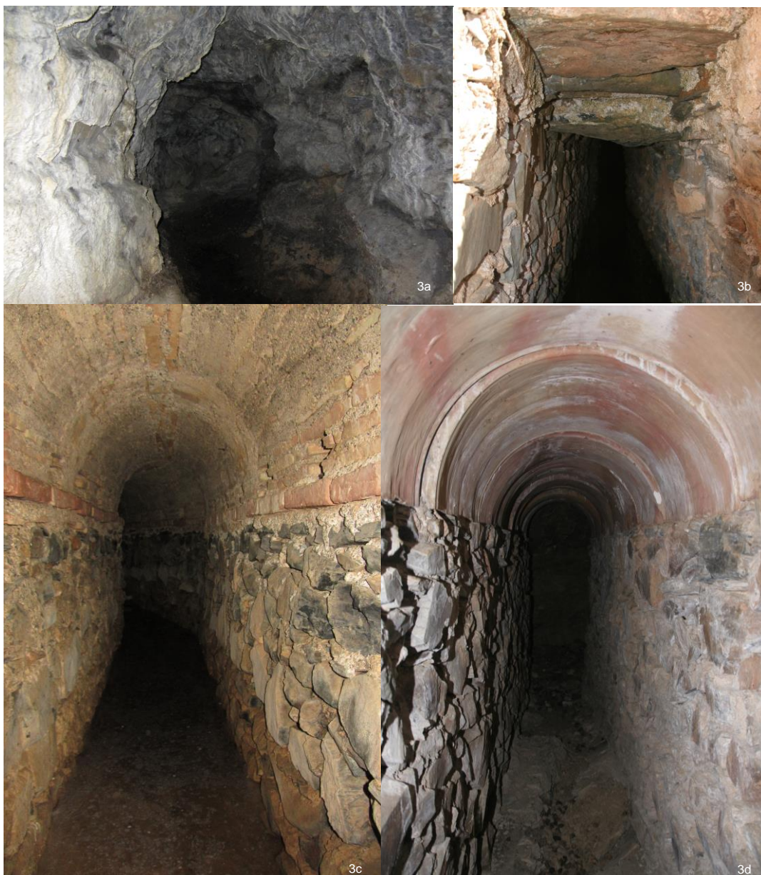
Ilustración 3. Materiales de los paramentos y techos: (a) Mina con paredes y techos sin revestir, construida en roca caliza (finca Linares), (b) Mina con paredes y techo adintelado de mampostería (finca Molino de Viento), (c) Mina con paredes de mampostería y bóveda de cañón de ladrillo (finca Pro de Molino de Viento), (d) Mina con paredes de mampostería y bóveda de cañón de ladrillo (finca Pro de Molino de Viento).
