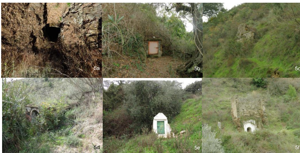
Ilustración 5. Tipos de bocaminas: (a) Bocamina abierta en la roca sin ningún tipo de tratamiento (finca Jiménez), (b, c) Bocamina cerrada con tabique (finca Rubira el Viejo, b) y con función de muro de contención (finca Rubira el Nuevo, c), (d, e) Bocamina de tipo caseta (finca Camino de la Encina, d), (finca El Herrador, e), (f) Bocamina de tipo alcubilla (restos de la alcubilla del lagar de Rubira el Nuevo). Fuente: Imágenes de los autores.
